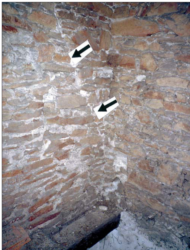
Obr. 15: Pohled k severozápadnímu koutu 3. nadzemního podlaží nárožní věže se šikmou spárou v západním boku, svědčící o starší výstavbě západního štítu kostela.
