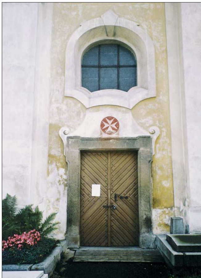
Obr. 9: Detail střední osy severní stěny kostelní lodi se vstupním portálem.
