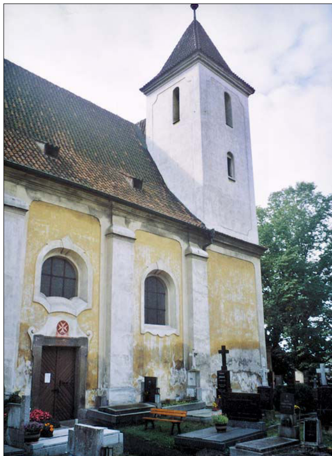
Obr. 8: Nárožní věž s dílem severního průčelí kostelní lodi při pohledu od severovýchodu.
