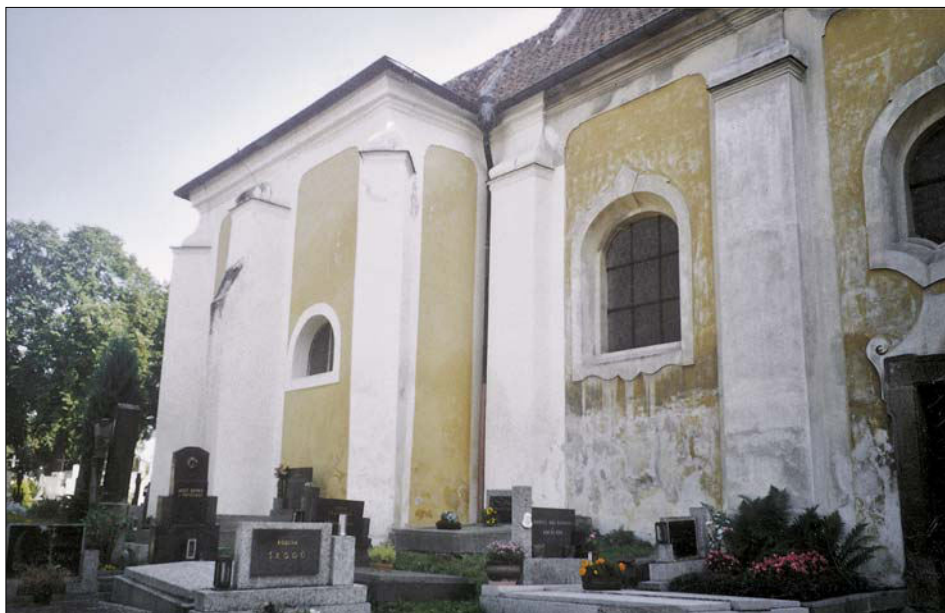
Obr. 10: Východní díl severního průčelí kostelní lodi s bývalou kaplí sv. Michaela.
