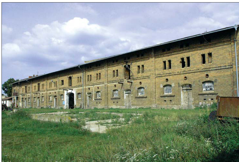
Obr. 15: Brníkov (okres Litoměřice), bývalé panství Libochovice. Budova chlévů s příčným uspořádáním stání z dob kolem roku 1900. Symetricky řešená budova se střední řezárnou-obročníkem a dvěma chlévy.
