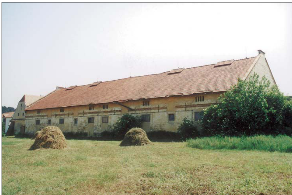
Obr. 9: Valtice, okres Břeclav, budova chlévů v čele hospodářského dvora z doby kolem roku 1880. Na fasádě z kamenných kvádrů, se střídají vstupní a okenní otvory.
