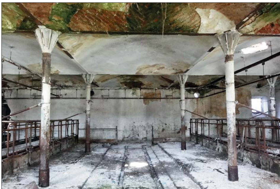
Obr. 7: Bylany (okres Kolín), bývalé panství Kostelec nad Černými lesy, interiér krawského chléva z druhé poloviny 70. let 19. století. Pohled ze vstupu do příčné obslužné chodby. Litinové sloupky jsou umístěny v ploše stání pro dobytek. Po stranách žlabů s vyvýšenými krmnými chodbami.
