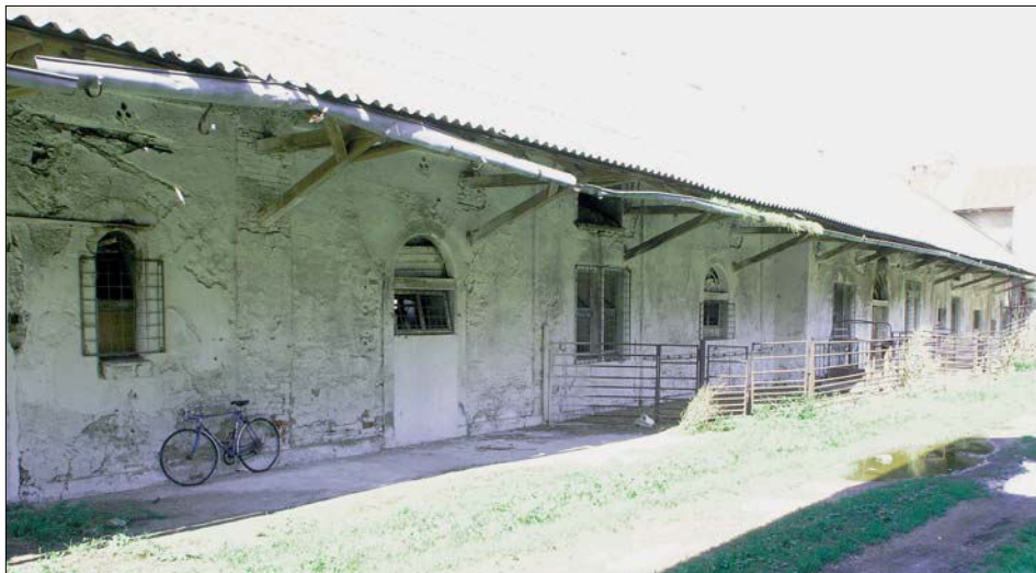
Obr. 10: Velký Dvůr (k. ú. Pulice, okres Rychnov nad Kněžnou), bývalé panství Opočno. Pohled na část nádvorní fasády krauských chlévů ze 70. let 19. století.
