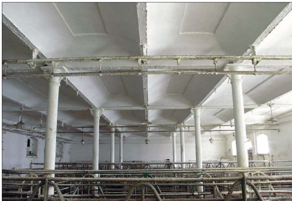
Obr. 16: Brníkov (okres Litoměřice), bývalé panství Libochovice. Interiér části chléva zastropený zrcadlovými klenbami nesenými železnou konstrukcí s litinovými sloupky.
