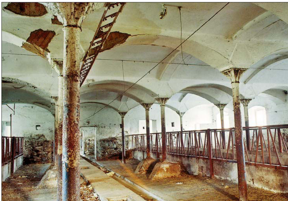
Obr. 18: Tupadly (okres Kutná Hora), bývalé panství Zleby. Interiér volských chlévů postavených na sklonku 70. let 19. století. Rytmus sloupů reaguje na uspořádání příčných stání a šířky příčných chodeb. Podezděné dvojice sloupů stály původně na vyvýšené krmné chodbě.
