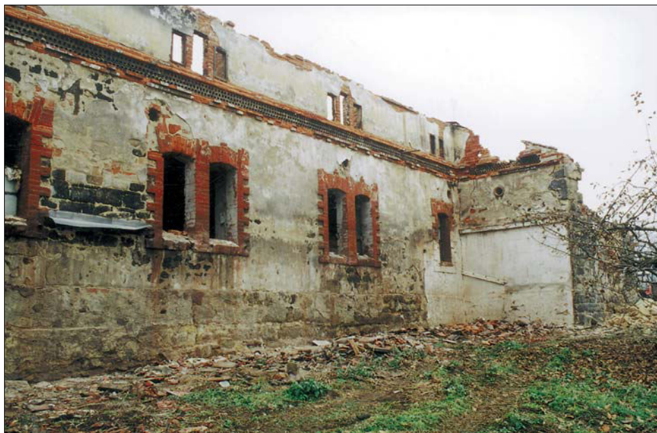
Obr. 11: Vysoká Libeň (okres Mělník), bývalé panství Řepín. Pohled na část vnější fasády budovy chlévů s příčným uspořádáním stání, se středním rizalitem řezárny, postavené krátce po roce 1875.
