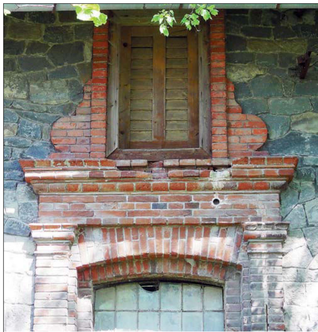
Obr. 14: Poměnice (okres Benešov), bývalé panství Konopiště. Detail jednoho z portálů chléva s nakládacím otvorem v supraportě.
