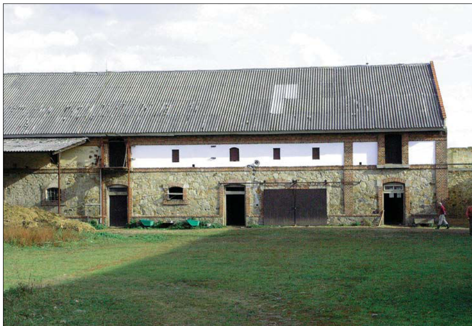
Obr. 12: Vřesná, bývalé panství Kardašova Řečice. Pohled na část nádvorní fasády chlévů s příčným stáním postavených zřejmě kolem roku 1880.
