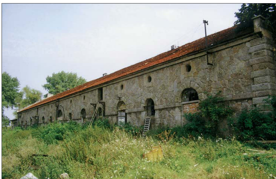
Obr. 5: Křenice (okres Praha-východ), bývalé panství Uhříněvse, pohled na nádvorní fasádu chlévů postavených v roce 1875. Náročně řešená fasáda s bosovanými kvádry a klenáky je zcela provedena ze žuly. Křenické chlévy lze pokládat za nejvýstavnější budovu tohoto typu na středočeských lichtenštejnských panstvích.
