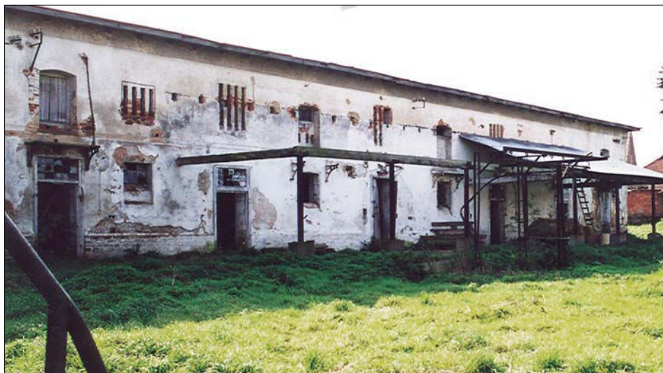
Obr. 8: Dobré Pole (okres Kolín), bývalé panství Kostelec nad Černými lesy, nádvorní fasáda chlévů z doby kolem roku 1878. Budova s vysokým pícníkovým podlažím, zastřešená sedlovou střechou malého sklonu reprezentuje mladší a méně architektonicky náročný typ lichtenštejnských chlévů s příčným stáním.
