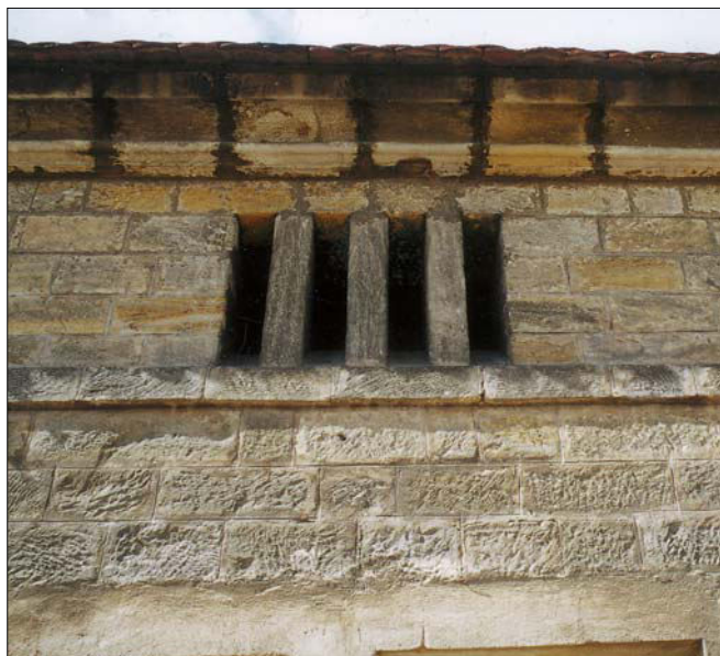
Obr. 4: Kounice (okres Nymburk), detail fasády chlévů roku 1874. Provedení fasády z pískovcových kvádrů s profilovanou římsou ilustruje úroveň kamenické práce, uplatněné na fasádách lichtenštejnských chlévů.
