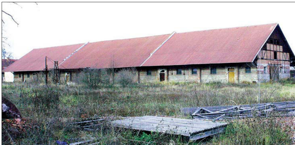
Obr. 17: Bor (okres Písek), bývalé panství Protivín. Pohled na chlév postavený v letech 1907–1908 od jihu. Vstupy umístěné v drobných rizalitech s dvojitými dveřmi se střídají s okny. Většina dveřních otvorů byla zazděna po změně uspořádání stání z příčného na podélné. Polopatro pícníku je hrázděné stejně jako štíty.
