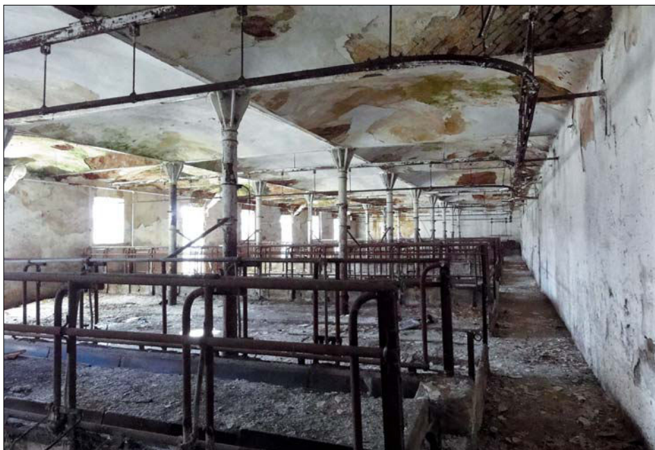
Obr. 6: Bylany (okres Kolín), pohled do chléva s dochovanými příčnými chodbami. Vpravo podélná chodba při obvodové stěně. Dobře je patrná konstrukce zastropení s plochými klášterními klenbami.
