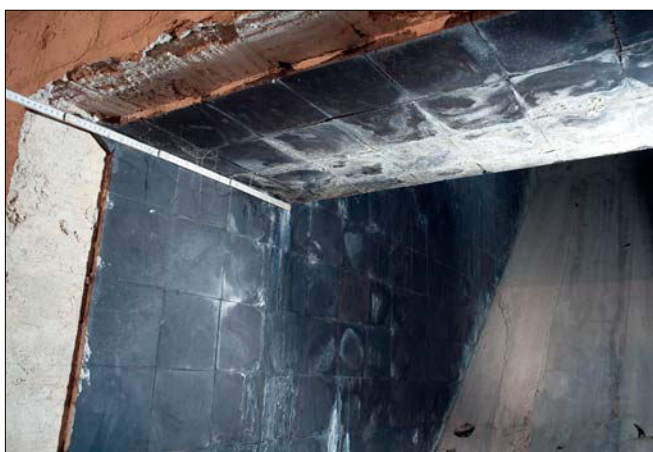
Obr. 1: Vila Tugendhat: a – původní světlá keramická dlažba zn. RAKO CZECHOSLOVAKIA, dochovaná pod příčkou z 80. let v kuchyni v hlavním obytném podlaží (2. NP); b – původní černá keramická dlažba, zřejmě také zn. RAKO CZECHOSLOVAKIA dochovaná v obložení shozu na koks v někdejší skladu koksů v technickém podlaží (1. NP) (všechny snímky D. Židlický, 2010, není-li uvedeno jinak).
