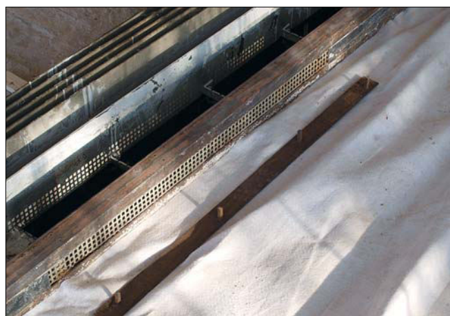
Obr. 13: Vila Tugendhat, a – ocelový krycí profil vzduchové šterbiny zajišťující regulaci větrání zimní zahrady; b – vzduchová šterbina vyplněná perforovaným plechem se čtvercovými otvory a její ocelový krycí profil s hranatými trny pro uchycení v perforaci plechu (foto M. Žáček, 2010).
