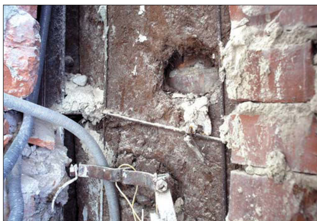
Obr. 4: Vila Tugendhat: a – izolační desky zn. Torfoleum ve zdivu v někdejším pokoji kuchařky v personálním traktu (2. NP); b – detail izolace zn. Torfoleum u ocelového nosného sloupu (vlevo).
