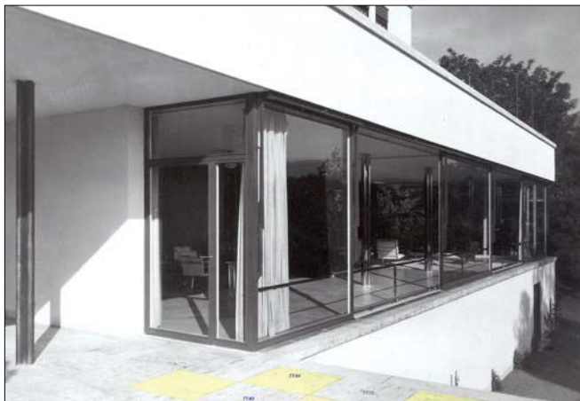
Obr. 7: Vila Tugendhat, zahradní terasa (počátek 30. let 20. stol.) s vyznačením původní šachovnicové orientace travertinových desek (MuMB, Fond Oddělení dějin architektury a urbanismu – vila Tugendhat, kopie v SDC-VT, zákres I. Wahla).
