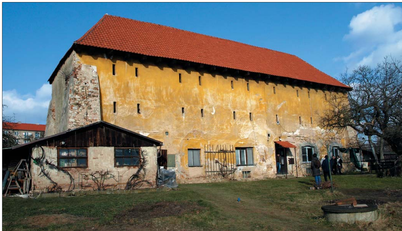
Obr. 18: Mníšek pod Brdy, budova čp. 115 od jihozápadu – bývalý zahradní dům (foto J. Žižka, 2008).
