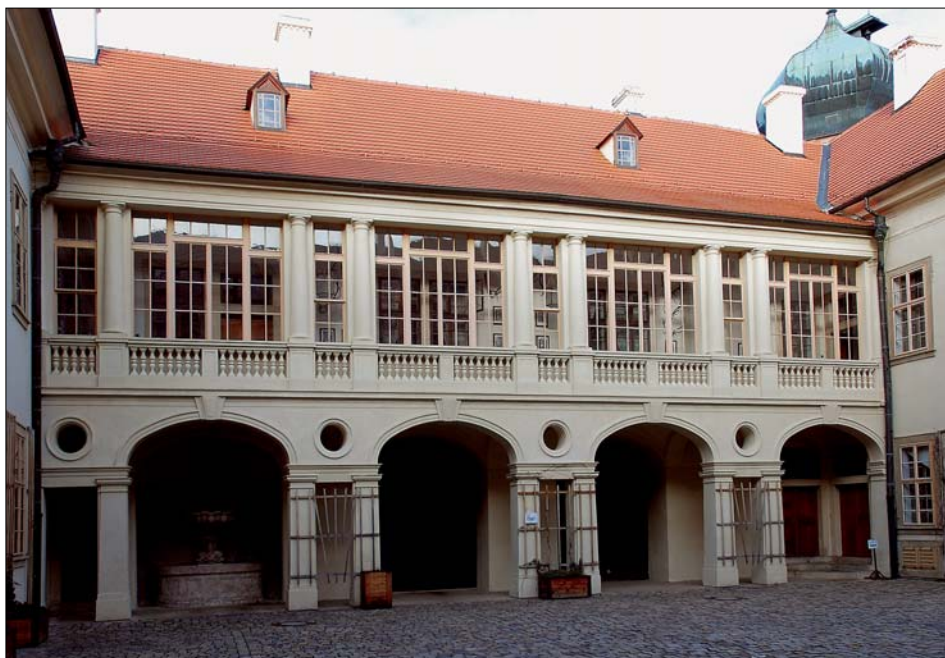
Obr. 10: Mníšek pod Brdy, zámek, pohled na nádvoří s arkádou projektovanou M. Blechou (foto V. Tutr, 2011).
