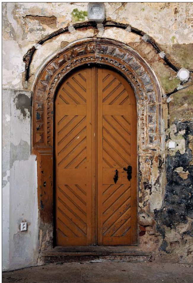
Obr. 6: Ústí nad Labem - Krásné Březno, kostel sv. Floriána, presbytář, portál vstupu do spojovacího krčku (foto M. Pavlíková, 2010).
