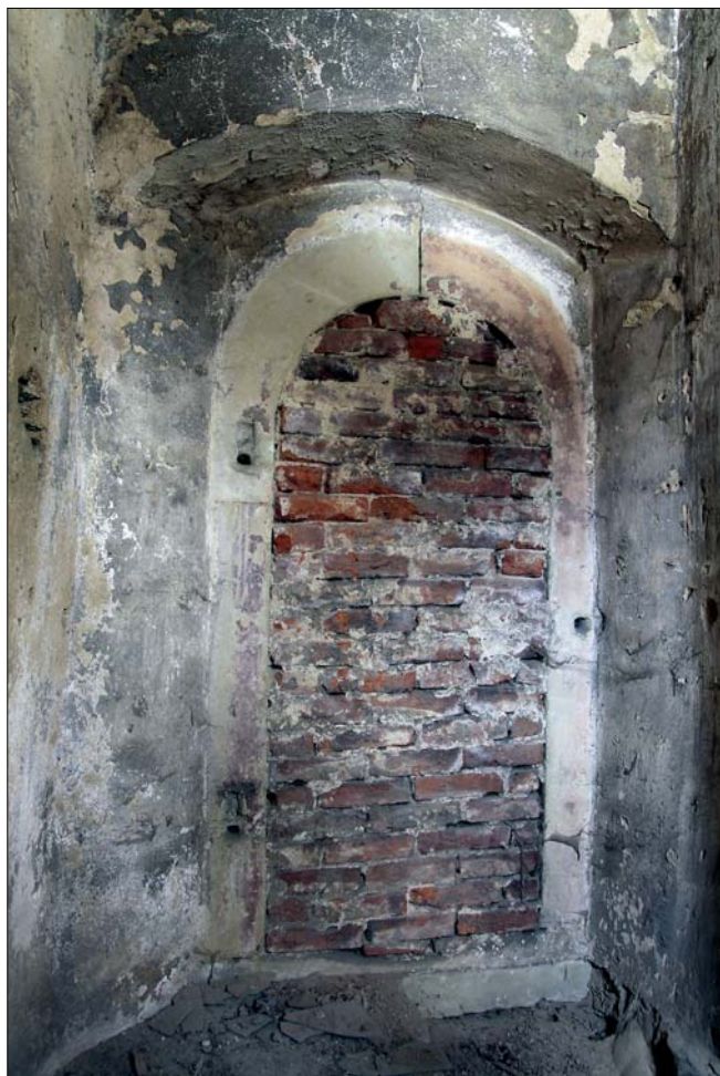
Obr. 11: Ústí nad Labem - Krásné Březno, kostel sv. Floriána, schodišťová věž při jižním průčelí, portál na panskou emporu z interiéru věže, na kamenní patrně zbytky červené polychromie (foto M. Pavlíková, 2010).
