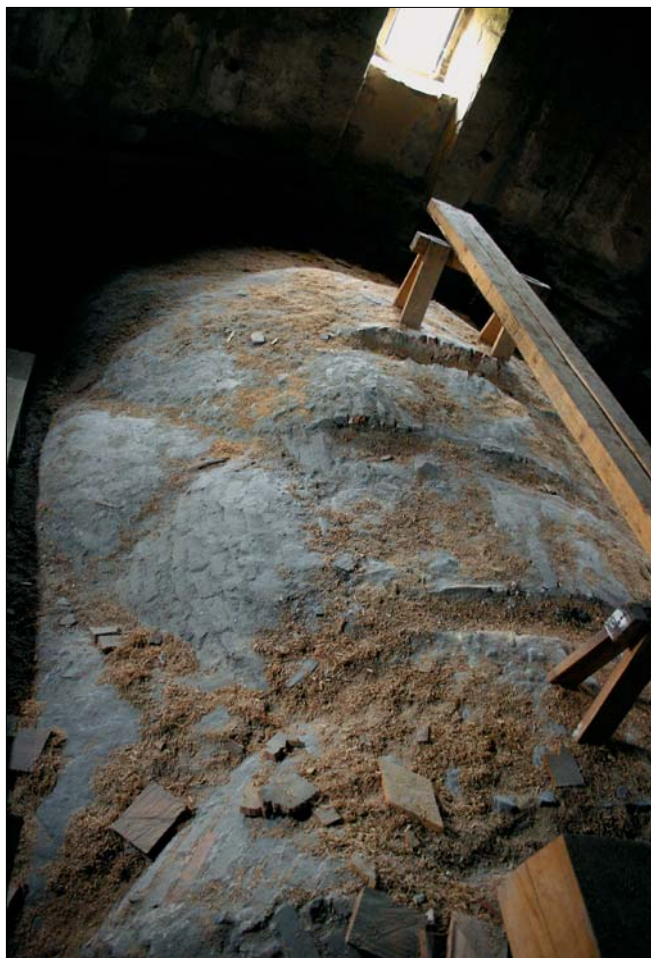
Obr. 12: Ústí nad Labem - Krásné Březno, kostel sv. Floriána, prostor v podstřeší kostela, pohled na rub klenby presbytáře s drážemi po uložení trámů podlah (foto K. Podroužek, 2009).
