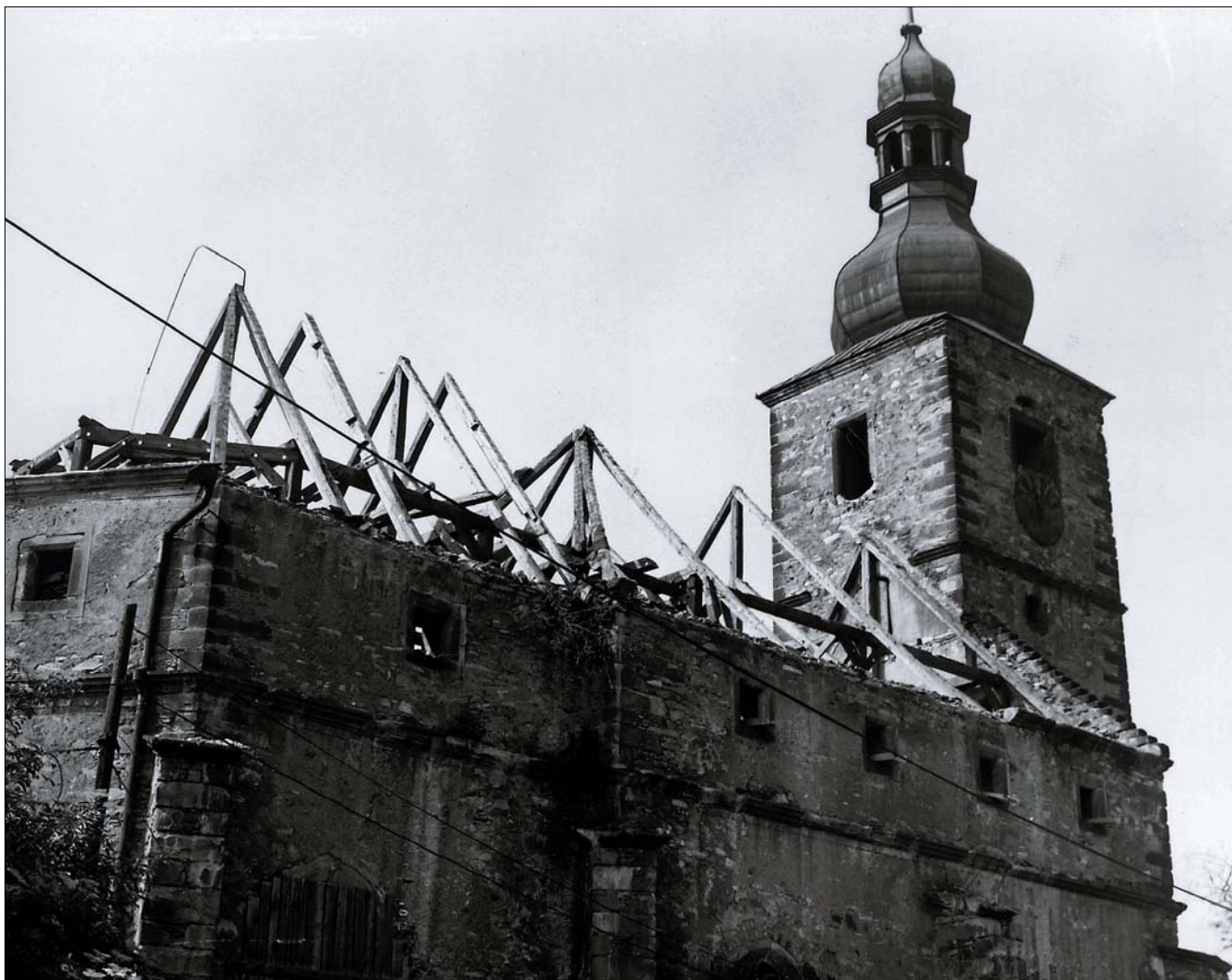
Obr. 15: Ústí nad Labem - Krásné Březno, kostel sv. Floriána, pohled od severovýchodu, situace odkrytého původního krovu v roce 1986. Krov, pocházející zřejmě z druhé poloviny 18. století, byl nahrazen novodobou provizorní konstrukcí nevysoké kvality (NPÚ ÚOP v Ústí nad Labem, sbírka fotodokumentace, Krásné Březno – kostel 1986).
