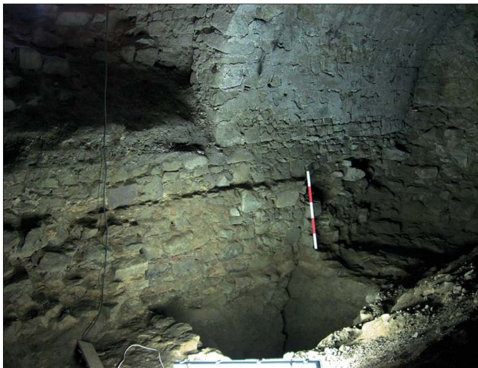
Obr. 10: Lukov, hrad, pohled na spodní část severní partie západní zdi místnosti; napravo (pod výtyčkou) torzo severní zdi, vlevo torzo zdi jižní, mezi nimi se nachází mladší zdivo, založené na násypu (srov. obr. 6/B).
