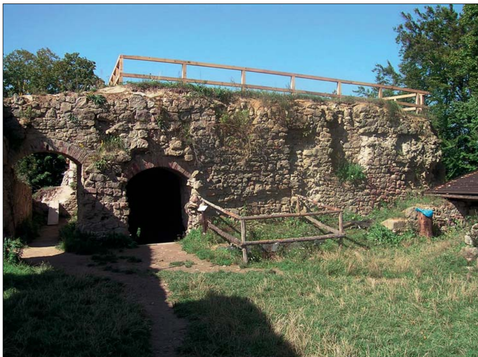
Obr. 3: Lukov (okres Zlín), hrad, nádvoří průčelí západního paláce, pohled od západu (2009).
