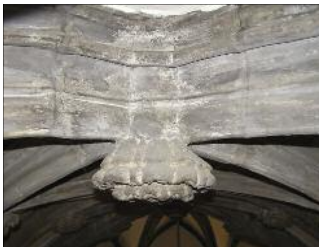
Obr. 13: Smečno, zámek. Detail růžice klenebního svorníku v kapli sv. Anny. Je zřejmé, že růžice jsou nedílnou součástí původní klenby z roku 1460 (foto R. Šimůnek, 2012).
