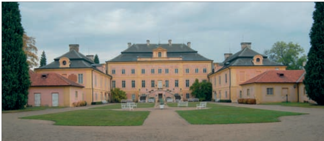
Obr. 6: Krásný Dvůr, pohled od jihu na hlavní budovu zámku s bočními patrovými křídly (všechny snímky J. Záhorka, pokud není uvedeno jinak, foto 10/2009).
