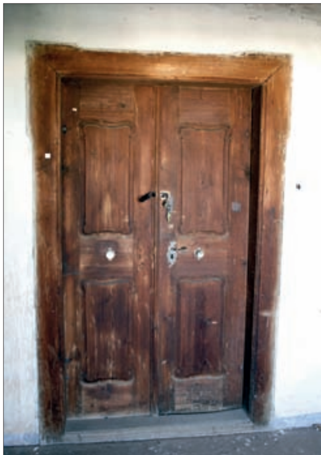
Obr. 14: Krásný Dvůr, západní křídlo, 2. patro, vestavba do podkroví. Detail dvoukřídlých dveří rámové konstrukce, upadlá pole obsahují vyřezávané okraje boltcového tvaru. Vnější závěsy jsou z pocínovaného plechu, esovitěho tvaru. Zámek je krabicový, s krytem zdobeným rytým ornamentem (foto 05/2008).
