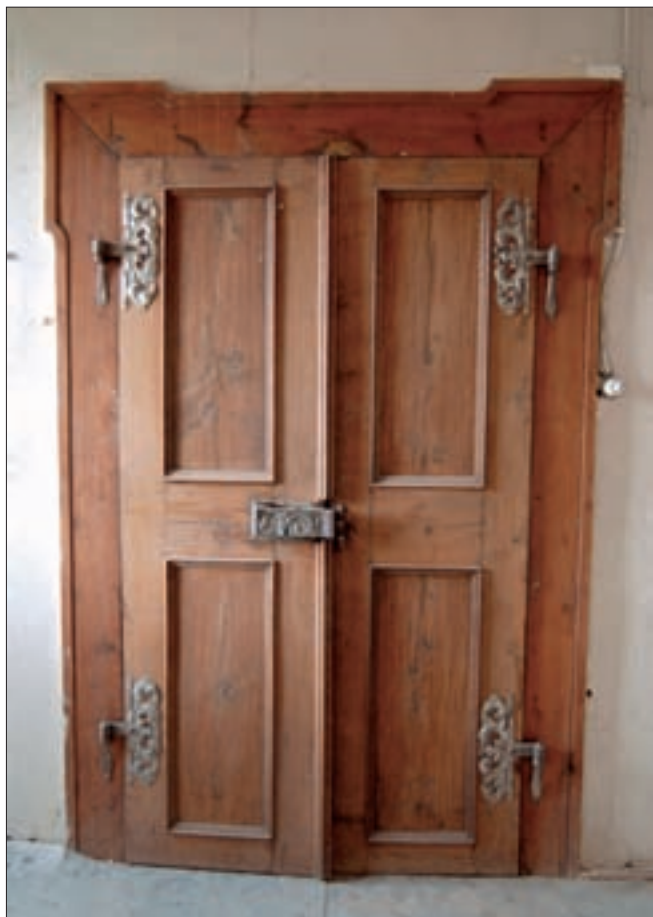
Obr. 12: Krásný Dvůr, hlavní budova, 2. patro. Dvoukřídle dřevěné dveře rámové konstrukce se dvěma vpadlými obdélnými výplněmi na každém křídle. Vnější závěsy jsou z tepaného pocínovaného plechu stylizované do tvaru akantu. Zámek je krabíkový s vystouplým reliéfem akantu (foto 05/2008).
