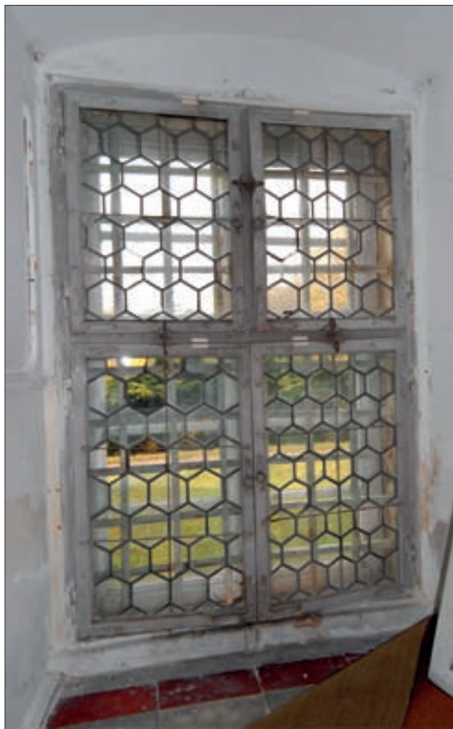
Obr. 18: Krásný Dvůr, západní patrové křídlo, mezipatro při podestě schodiště z přízemí do patra. Detail jediného dochovaného okna pocházejícího z první barokní fáze (1720–1727). Jednoduché čtyřkřídlové okno s pevným křížovým dělením je zasklené skleněnými šestiúhelníky do olova, zpevněného kovanými nosníky. Rámy mají rohové pásky, závěsy jsou vnější. Křídla jsou přichycena třemi oboustrannými obrtlíky (foto 05/2008).
