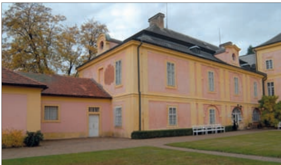
Obr. 8: Krásný Dvůr, pohled na dvorní fasádu západního patrového bočního křídla. Na jižním konci vidíme bývalý altán navrhovaný původně s pochozí terasou, později zastřešený sedlovou střechou. Zaslepený otvor v patře sloužil jako vstup na terasu. V přízemí bočního křídla vidíme trojici, původně otevřených půlkruhových arkád (foto 10/2009).
