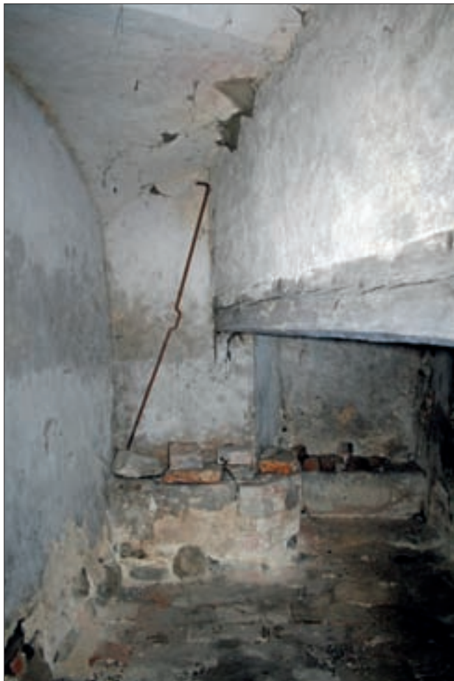
Obr. 11: Krásný Dvůr, západní křídlo, klenutý prostor pod schodištěm sloužící původně nejspíše jako pekárna. Trám vynáší zděný dymník, podlaha je cihelná. Dnes je vstup z drobného prostoru vedle schodiště. Později byl tento prostor přestavěn (foto 05/2008).
