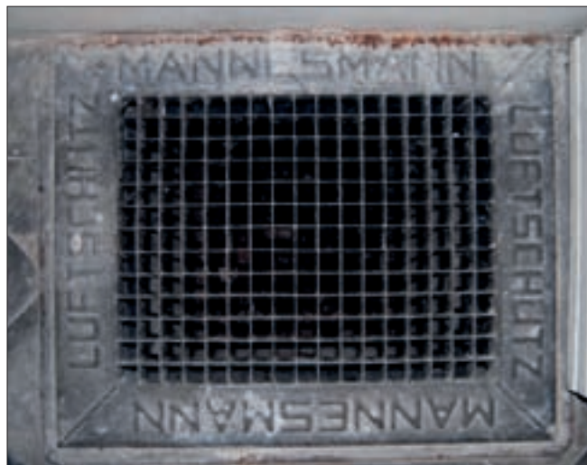
Obr. 19: Krásný Dvůr, západní křídlo, přízemí. Detail mřížky z pozinkovaného plechu, kryjící výdech ventilace protiletického krytu umístěného ve sklepení. Systém vyrobila německá firma Mannesmann ve 30. letech 20. stol. (foto 05/2008).
