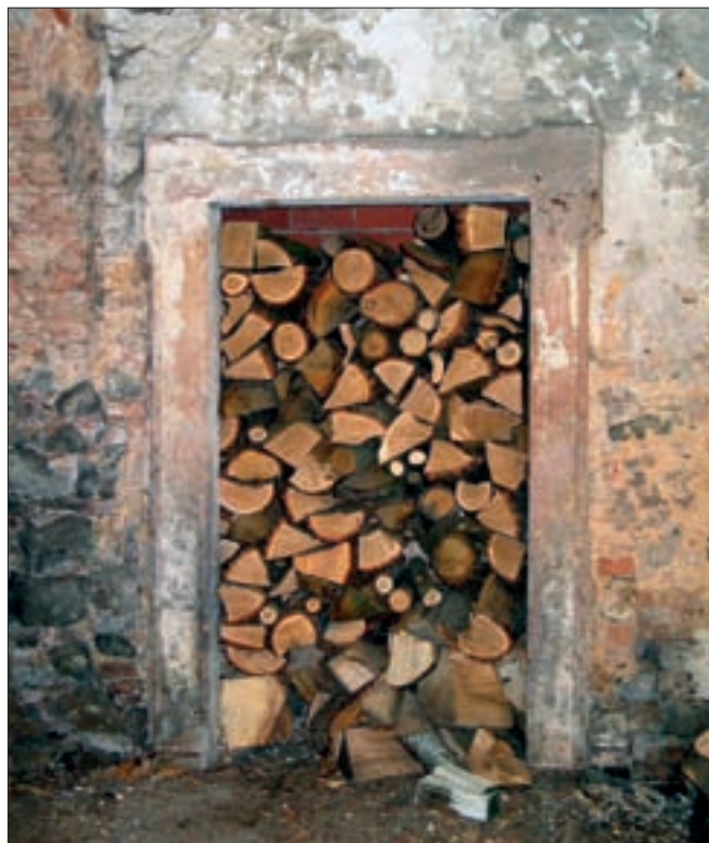
Obr. 13: Krásný Dvůr, západní přízemní křídlo, detail druhotně zazděného vstupu mezi oběma stájemi. Kamenné ostění s horními uchy, lemované vystouplým páskem, pochází z barokní etapy a objevuje se u všech vstupů z této etapy, včetně profilace dřevěných zárubní (foto 05/2008).
