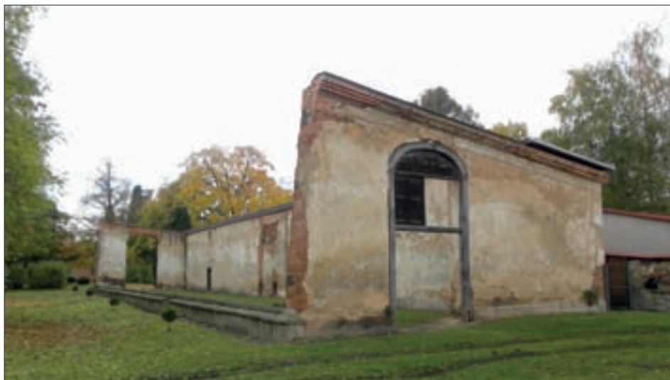
Obr. 27: Krásný Dvůr, oranžerie, celkový pohled od jihovýchodu. Na fotografii vidíme prostor pro pěstování exotického ovoce bez horizontálních konstrukcí. Z čelní prosklené stěny zbyl pouze kamenný sokl, sloužící pro uchycení dřevěného rámu, v kterém byly umístěny skleněné tabule (foto 10/2010).
