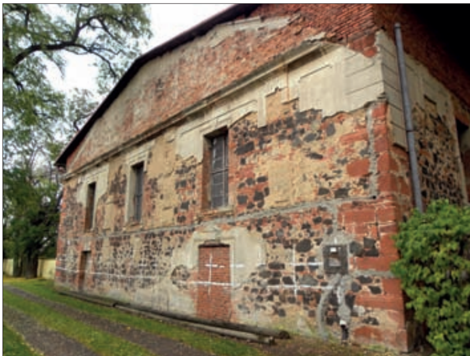
Obr. 29: Krásný Dvůr, jízdárna, pohled na severní průčelí. Na fasádě vidíme zbytky novorenesančního členění z přestavby, podle návrhu Achilla Wolfa (foto 10/2010).
