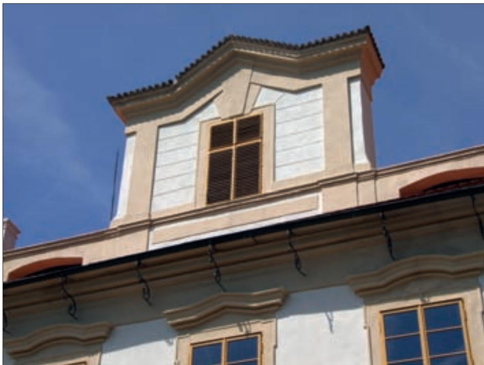
Obr. 2: Loučeň, zámek. F. M. Kaňka doložen od roku 1720. Detail střešního štítu s provázáním klenáku a lesenového rámu (2009).
