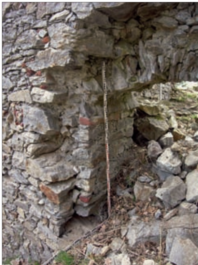
Obr. 15: Dívčí Kámen, hrad, obytná stavba v parkánu. Jižní strana torza vstupu do suterénu, pohled od severovýchodu, srov. obr. 14. U paty měřítka patrný otvor závory, pod patou dochovaného záklenku vyčnívá řada šikmo ložených kamenů, které patrně dokládají existenci spodní, dnes zborcené vrstvy základů (foto J. Veselý, 2012).
