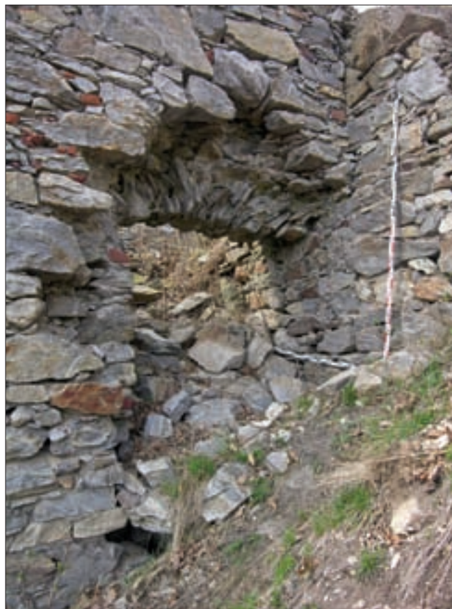
Obr. 16: Dívčí Kámen, hrad, obytná stavba v parkánu. Severní strana torza vstupu do suterénu, pohled od jihovýchodu, srov. obr. 14. Záklenek je dodatečně zavázán do vnějšího lince jižní parkánové hradby (foto J. Veselý, 2012).
