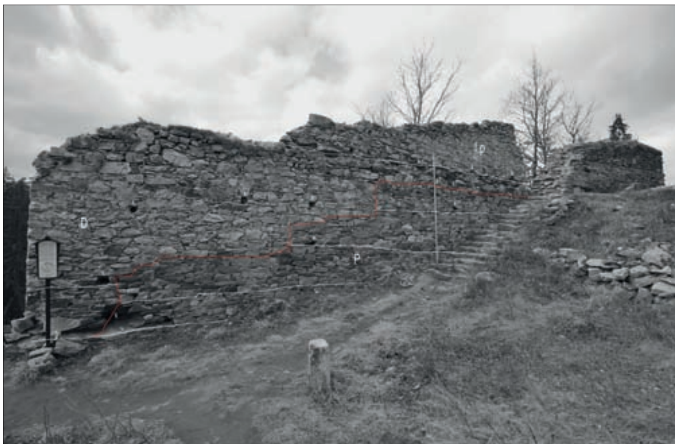
Obr. 21: Divčův Kámen, hrad, obytná stavba v parkánu. Celkový pohled na vnitřní líc západní obvodové zdi. Červeně vyznačeny vývojové stavební spáry, bíle technologické spáry s negativy lešeňových nosníků (lk). Odlišeno zdivo původní parkánové hradby (P) a obytné budovy (D) s nadezdívkou prvního patra (I. p) (foto Z. Neustupný, 2008, zakres J. Veselý).
