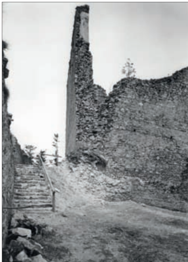
Obr. 10: Dívčí Kámen, hrad, obytná stavba v parkánu. Pohled do severo-východního koutu, na povrchu východní zdi jsou dobře patrné otisky výdřevy sestavené z fošen, v pozadí zborcené torzo nároží západního paláce (fotobírka NPÚ ÚP, foto V. Hyhlík, 1962).
