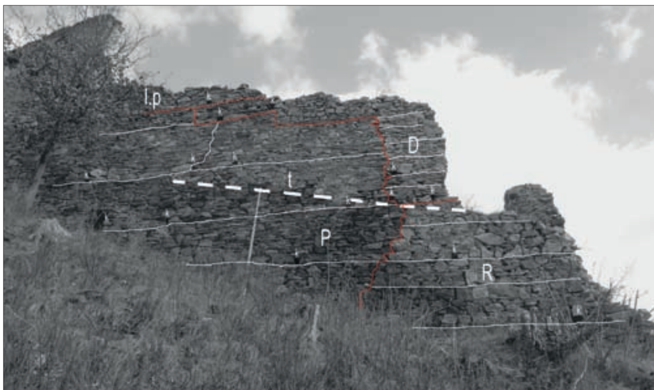
Obr. 20: Dívčí Kámen, hrad, obytná stavba v parkánu. Celkový pohled na vnější líc západní obvodové zdi. Červeně vyznačený vývojové stavební spáry, bíle technologické spáry s negativy lešeňových nosníků (lk). Odlišeno zdivo původní parkánové hradby (P), rizalitu (R) a obytné budovy (D) s nadezdívkou prvního patra (I. p). Přerušovaná čára (t) udává povrch terénu v interiéru (foto J. Kypta, 2008, zákres J. Veselý).
