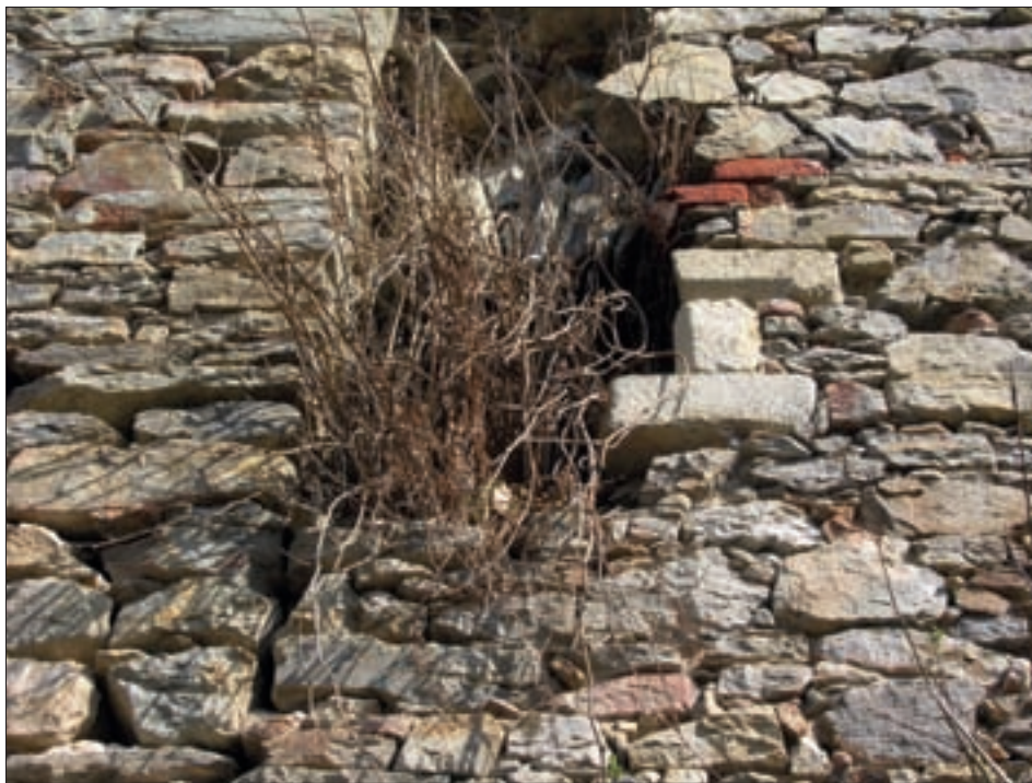
Obr. 19: Dívčí Kámen, hrad, obytná stavba v parkánu. Detail jižního průčelí s torzem ostění okénka suterénu, srov. obr. 17 (foto J. Veselý, 2012).
