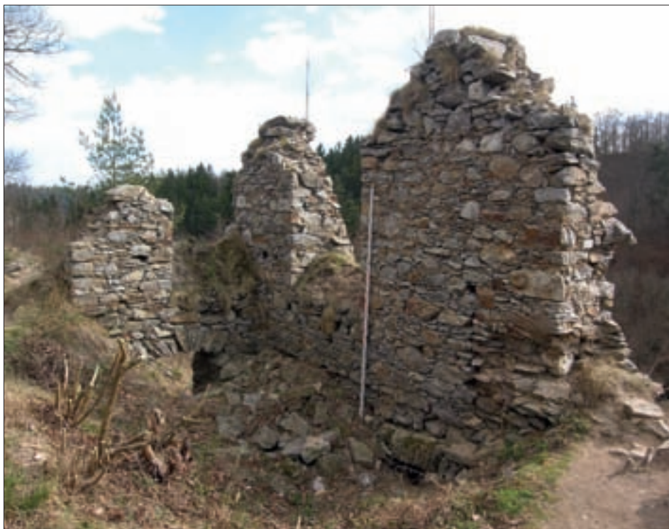
Obr. 12: Dívčí Kámen, hrad, obytná stavba v parkánu. Celkový pohled do jihovýchodního koutu, v pravém dolním rohu snímku je patrná ubouraná zeď nárožního rizalitu, srov. obr. 11 (foto J. Veselý, 2012).
