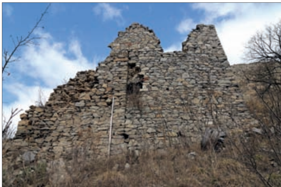
Obr. 17: Dívčí Kámen, hrad, obytná stavba v parkánu. Jižní průčelí, vlevo od výrazné svislé spáry čelo staršího rizalitu (foto Z. Neustupný, 2008).
