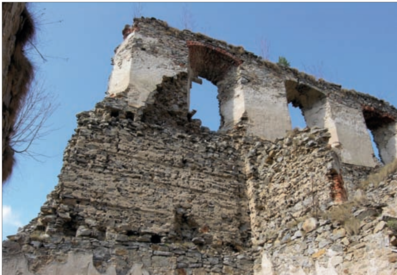
Obr. 22: Dívčí Kámen, hrad, západní palác. Uprostřed obytná místnost ve druhém patře. Podle otisků je dobře patrné, že byla vyložena fošnami zasunutými do drážek koutových sloupků (foto J. Kypta, 2012).
