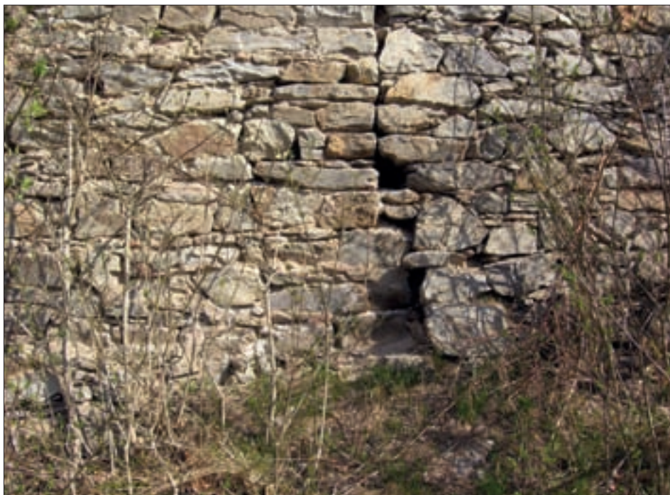
Obr. 18: Dívčí Kámen, hrad, obytná stavba v parkánu. Detail jižního průčelí se svislým rozhraním v úrovni soklu, vlevo od spáry zdivo staršího rizalitu (foto J. Veselý, 2012).
