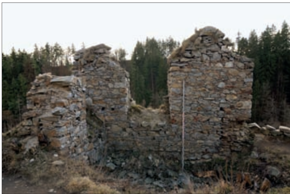
Obr. 11: Dívčí Kámen, hrad, obytná stavba v parkánu. Pohled od severu na jižní obvodovou zeď; upravo od paty měřítka vystupuje záklenek níky okénka suterénu, zcela upravo nad patou záklenku je zřetelný blok nelicovaného zdíva – jádro ubourané východní zdi nárožního rizalitu. Vlevo od paty měřítka běží upadlý vodorovný pás lice – lůžko klenby suterénu. V levé části snímku zachycena část východní obvodové zdi s jižní špaletou vstupu z parkánu, špaleta je protnuta svislou spárou (foto Z. Neustupný, 2008).
