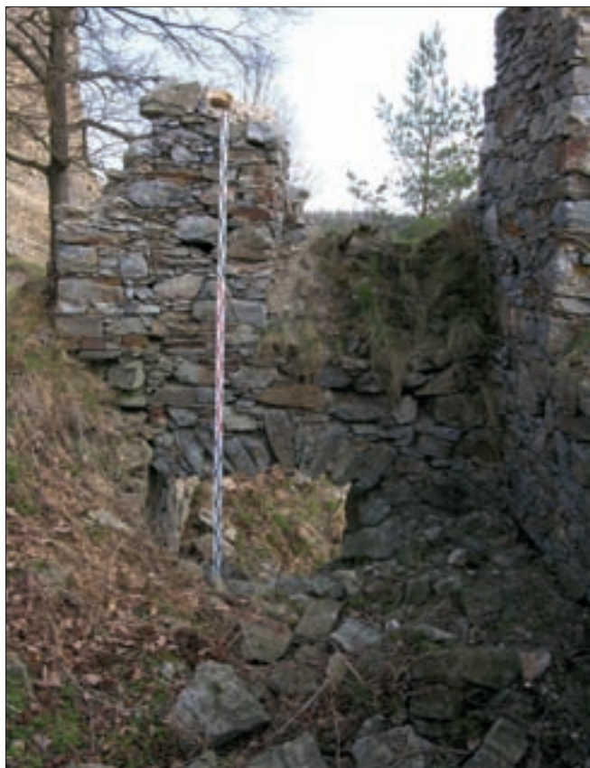
Obr. 13: Dívčí Kámen, hrad, obytná stavba v parkánu. Detail západní stěny východní obvodové zdi, dole vstup do suterénu, nahoře okenní nika v přízemí, srov. obr. 12 (foto J. Kypta, 2008).
