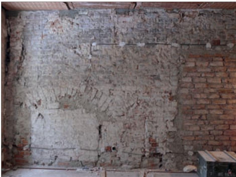
Obr. 14: Hradec Králové, Velké náměstí, dům čp. 41. Severní část východní stěny 1. patra se zazděnými výklenky. Pod stropem dvě úrovně kapes stropních trámů.
