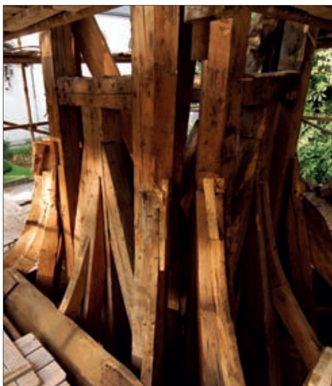
Obr. 19: Vranov, kostel Narození Panny Marie. Přechod mezi bání a tubusem věže.
