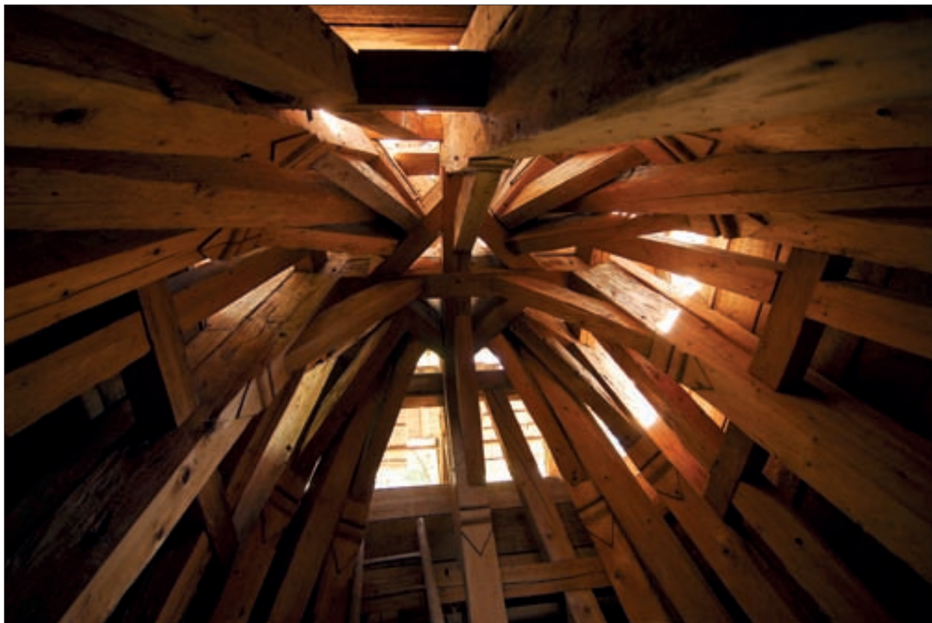
Obr. 18: Vranov, kostel Narození Panny Marie. Pohled na uspořádání ležatých stolic a jejich spojení.
