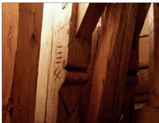
Obr. 16: Vranov, kostel Narození Panny Marie. Detail tesařského značení na sloupku ležaté stolice.
