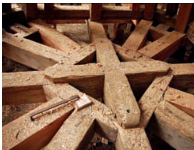
Obr. 14: Vranov, kostel Narození Panny Marie. Detail základového roštu.
