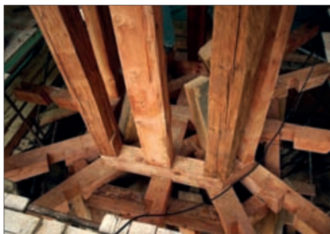
Obr. 17: Detail uložení sloupků tubusu a lžinového věnce po výměně vadných částí roštu báně.
