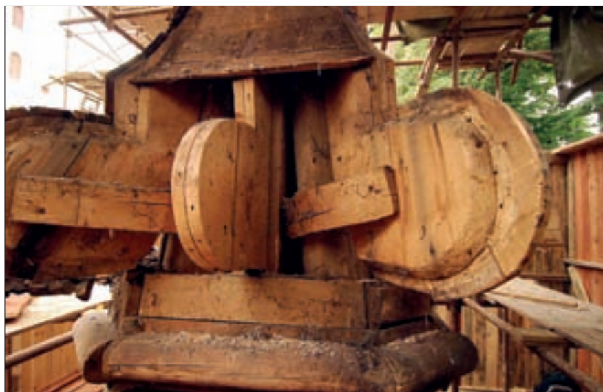
Obr. 21: Vranov, kostel Narození Panny Marie. Detail bednění pod oknem lucerny.
