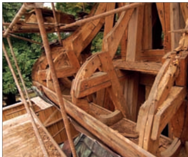
Obr. 20: Vranov, kostel Narození Panny Marie. Pohled na konstrukci ramenátů spodní bane.
