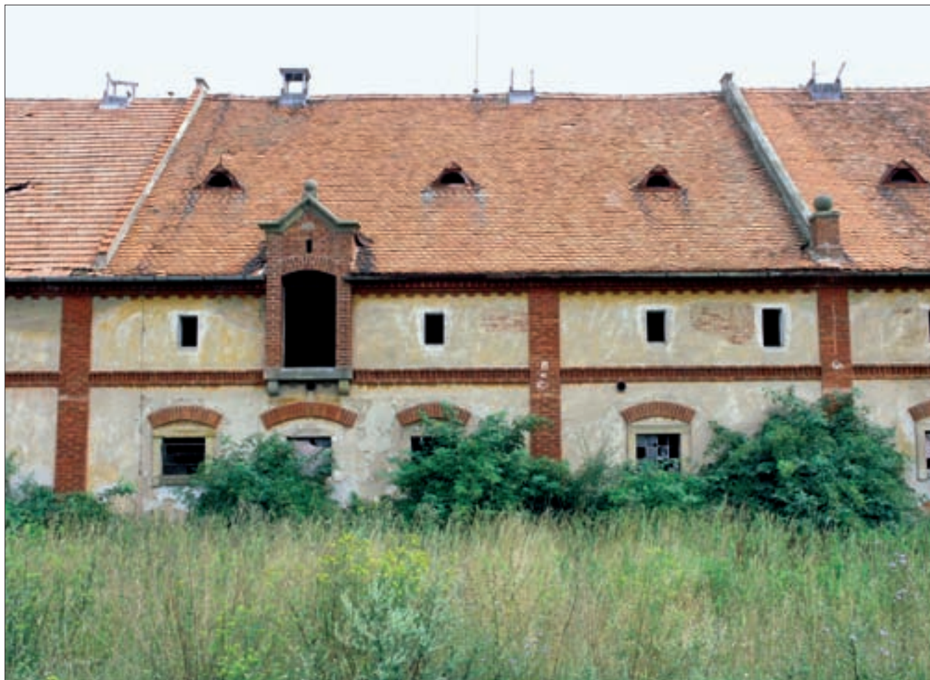
Obr. 3: Nový Dvůr u Dětenic (okres Jičín), bývalé panství Dětenice, část fasády budovy chlévů z konce 19. století. Příklad velké budovy chlévů, jejíž fasády člení režné cihelné články, rytmem reagující na funkční uspořádání budovy. Nakládací otvory jsou umístěny v arkýřích, vysazených na krajkách, dobře se dochoval větrací systém včetně parníků na hřebeni střechy (foto autor).
