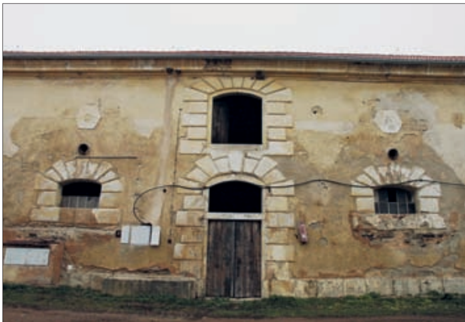
Obr. 2: Horšov (okres Domažlice, bývalé panství Horšovský Týn), detail průčelí chléva. Příklad náročně řešené fasády chléva s polopatrem pícničku (foto autor).
