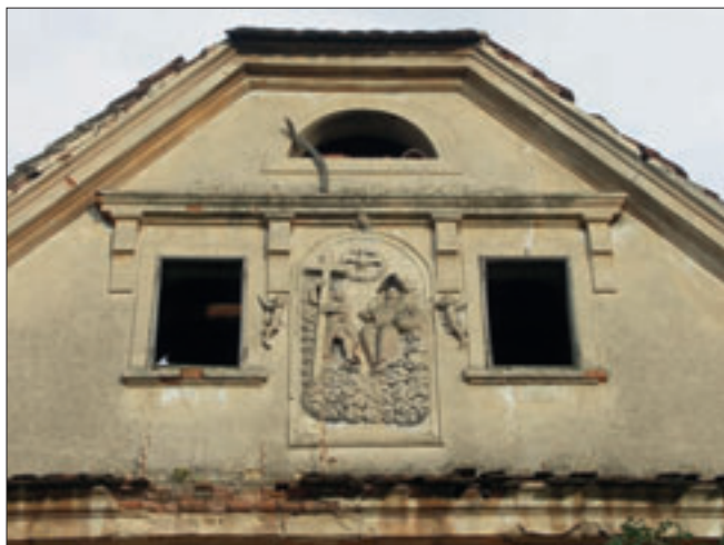
Obr. 37: Pavlovice, detail velmi cenného štítu u bývalého výměnku usedlosti čp. 37 s reliéfem Svaté Trojice s dvojicí andlíků po stranách. Štít je pojednán velmi zdobně a honosně, svým provedením s polovalbičkou a masivními římsami patří mezi starší typ z období první poloviny 19. století. Bohužel je ohrožen havarijním stavem objektu (NPÚ ÚOP v Liberci, foto M. Panáček, srpen 2007).
