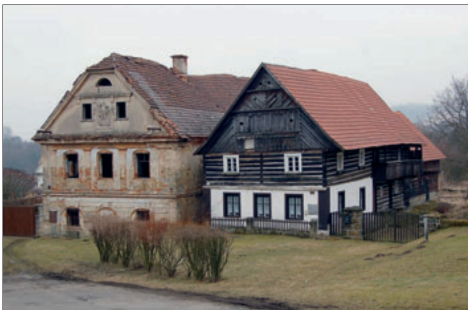
Obr. 31: Pavlovce, současný pohled na domy čp. 37 a 38 zachycuje značně neutěšený stav bývalého výměnku usedlosti čp. 37. Tento mimořádně cenný dům zůstal z usedlosti jako jediný dochován. Zdobí ho náročně pojednaná fasáda s rustikou a slepými arkádami v přízemí, pilastry s hlavicemi v patře a výrazným reliéfem Svaté Trojice ve štítu. Dispozice výměnku odpovídá ostatním zděným stavbám ve vsi, včetně vstupní zapuštěné lodžie. Vedle stojící původně celoroubený dům čp. 38 je dochován ve velmi autentickém stavu exteriéru i interiéru. Vnější podobu umocňuje náročně pojednaná štítová lomenice s obdobným řešením jako u protějšího čp. 10. Při porovnání se snímek Obr. 1 je zřejmá změna urbanistického konceptu této části návsi, která značně prořídla po zbourání původních hospodářských staveb, ale hlavně zánikem hlavního domu usedlosti čp. 37 (NPÚ ÚOP v Liberci, foto M. Kolka, březen 2012).
