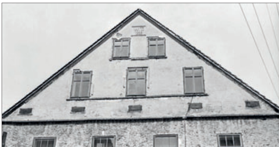
Obr. 38: Pavlovice, historický pohled na detail štítu domu čp. 13, v jeho vrcholu je umístěna datace výstavby 1885 a iniciály stavebníka „WT“ (Wenzel Tamme). Při srovnání s předchozím snímkem je jasně patrná odlišná typologie členění a zdobných prvků mladší zástavby z druhé poloviny 19. století se subtilnějšími římsami, jemnějším dekorem, tenkými linkami, striktně pravidelnou rytmizací či charakteristickým užitím podélných větracích otvorů (fotografická sbírka Severočeského muzea v Liberci, foto J. Kabíček, 1968).
