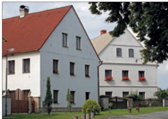
Obr. 8: Pavlovice, současný snímek jižní strany návsi zachycuje domy čp. 3 a čp. 4. z druhé poloviny 19. století, které jsou dochovány v původní hmotě a typické štítové orientaci. Vzhled domu čp. 3 je výsledkem novodobých úprav fasády, okenních výplní a střešní krytiny, u čp. 4 zůstaly patrné zbytky štukové výzdoby při nárožích, římsách a pískovcové sloupky historické brány (NPÚ ÚOP v Liberci, foto Petra Šternová, srpen 2011).
