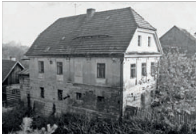
Obr. 23: Pavlovice, zděný dům čp. 27, situovaný na vysoké kamenné podezdívce na ostrohu nad dlážděnou cestou do údolí Svábšského potoka. Stavbu lze řadit ke starší zděné zástavbě vesnice, což opět dokládá užití polovalby u sedlové střechy, masivní římsy či čistě klasicistní tvarosloví mimořádně hodnotné fasády. Dnešní vzhled je v podstatě shodný s tímto historickým snímek, dům je dochován ve velmi autentické podobě exteriéru. Na záběru lze v levé části vidět i patrový roubený dům čp. 28, také dochován bez výraznějších změn dodnes a vpravo přízemní objekt na hranici bývalých usedlostí čp. 32 a 33 – jediný přízemní roubený dům ve vesnici (foto archiv NPU ÚOP v Liberci, autor snímku neznámý, 1976).
