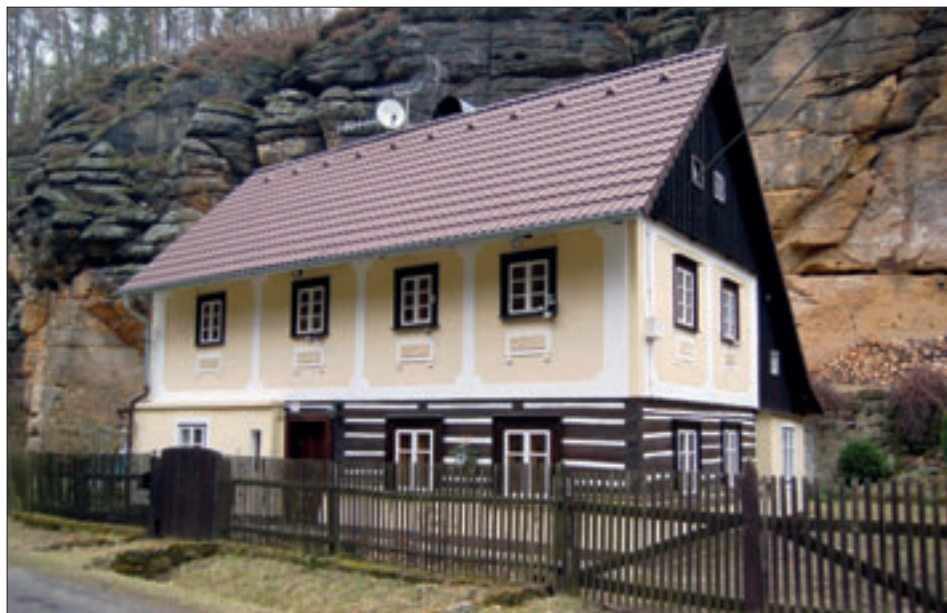
Obr. 29: Pavlovice, současný vzhled domu čp. 53, který je součástí domkářské zástavby údolí Švábského potoka, situované v úzkém prostoru rokle mezi pískovcovými skalami, komunikací a vodním tokem. Značné množství této zástavby již zaniklo, či bylo přestavěno na novodobé rekreační chatky, tento dům zůstal zachován v poměrně autentickém stavu jako patrový převážně roubený, s omítaným patrem se zdobně členěnou fasádou (NPÚ ÚOP v Liberci, foto M. Kolka, březen 2012).
