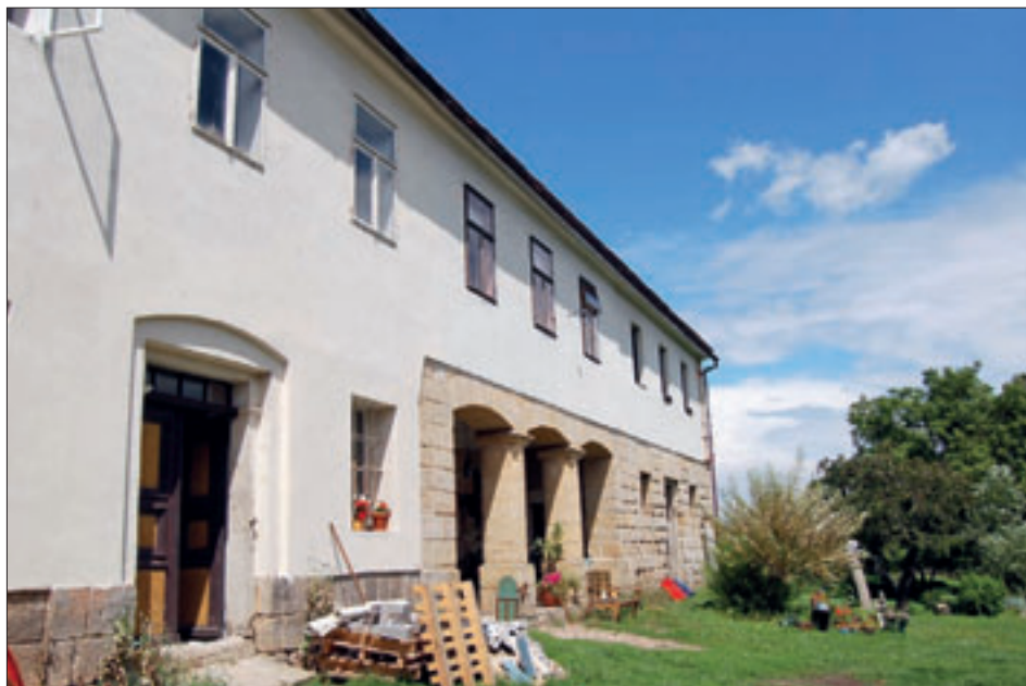
Obr. 34: Pavlovice, hlavní okapové průčelí domu čp. 22 s detailem charakteristické zapuštěné vstupní lodžie o třech polích na masivních profilovaných pískovcových sloupech (NPÚ ÚOP v Liberci, foto T. Konvalinková, červenec 2012).
