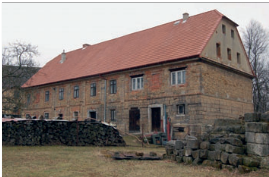
Obr. 19: Pavlovice, současný pohled ze dvora na hlavní dům usedlosti čp. 16, který velmi pravděpodobně patří mezi starší zděnou zástavbu z období kolem poloviny 19. století, k čemuž odkazuje užití polovalby v sedlové střechě, masivní římsy či starší klasicistní ornamentika fasády s řadou pilastrů kopírujících okenní osy. Dům je dochován v autentickém vzhledu exteriéru, včetně zdobných prvků, s odhaleným neomítnutým zdivem v kombinaci pískovce, opuky a cihel. Ostatní objekty usedlosti již nestojí (NPÚ ÚOP v Liberci, foto T. Konvalinková, březen 2012).
