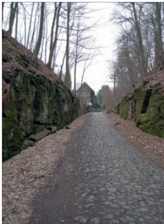
Obr. 40: Dlážděná cesta spojující náves s údolím Švábského potoka – původní hlavní komunikace do vsi, vytesaná ve skalním bloku s důmyslnými odvodňovacími postranními kanály. V pozadí zachycen dům čp. 28 (NPÚ ÚOP v Liberci, foto M. Kolka, březen 2012).
