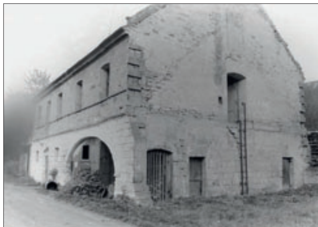
Obr. 11: Pavlovice, zděná zadní hospodářská část čp. 10 s výrazně klenutým příjezdem po odbourání předního roubeného dílu, po kterém je stále patrný otisk ve zdivu. Tento díl stál pravděpodobně o několik let déle než roubená část, ale v poslední čtvrtině 20. století také podlehl demolicí (foto archiv NPÚ ÚOP v Liberci, autor snímku neznámý, 1984).
