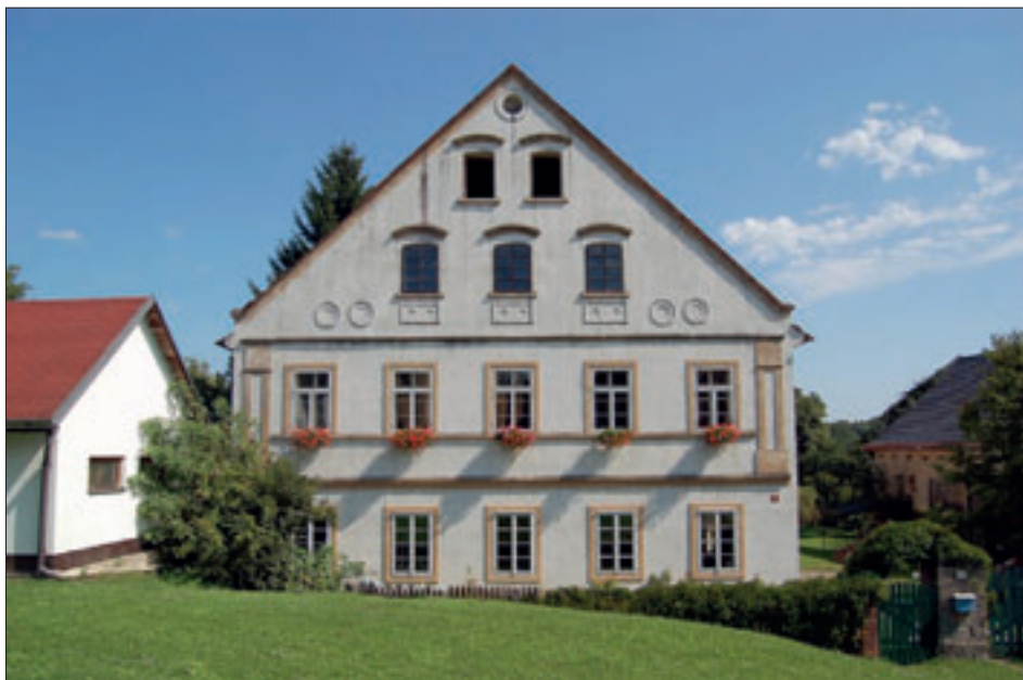
Obr. 21: Pavlovice, hlavní štítové průčelí obytného domu čp. 22. Ze snímku je jasně patrná mimořádná velikost domu o pěti okenních osách. Fasáda domu zůstala zachována včetně zdobných prvků, zvláště výrazných nárožních pilastrů, okenních šambrán a jednoduchých geometrických motivů ve štítu. I interiéru domu je dochován ve velmi autentickém stavu, v historické dispozici analogické ostatním zděným statkům, včetně chlebové pece, krovu a řady detailů (NPÚ ÚOP v Liberci, foto M. Kolka, srpen 2012).
