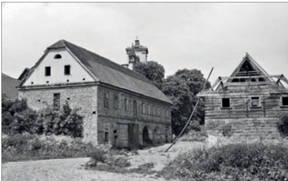
Obr. 25: Pavlovice, dobový pohled na zadní část usedlosti čp. 37 – vpravo situován hlavní dům, vlevo výměnek. Hlavní dům je zde zachycen již ve velmi špatném stavu, bez krytiny v zadní části. Odhalena je konstrukce krovu s ležatou stolicí v zadní části a pravděpodobně hambalkového u předního dílu. Zadní díl je atypicky řešen s patrem provedeným v roubené konstrukci oproti zděnému přednímu dílu. Objekt výměnku, nacházející se dnes v havarijním stavu, je zděný v obou podlažích. Přední díl je patrně starší, ve zdivu je patrně druhé napojení zadního dílu. Na snímku je dobře patrná zapuštěná vstupní lodžie a odhalené zdivo z pískovcových štuk v nárožích a opukovým kamenem a cihlami ve zbytku zdiva (fotografická sbírka Severočeského muzea v Liberci, foto J. Kabiček, 1968).
