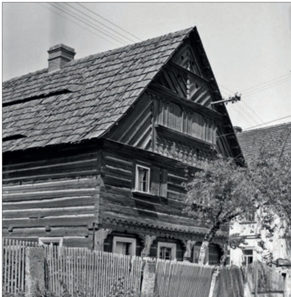
Obr. 12: Pavlovice, historická fotografie dnešního domu čp. 10 ze 40. let 20. století zachycuje jeho tehdejší podobu s původní šindelovou krytinou, s nízkými chmelařskými vikýři, s kompletně roubeným přízemím před pozdějším vyzdáním jeho jižní stěny a včetně dřevěných okenic v patře (fotografická sbírka Severočeského muzea v Liberci, autor snímku neznámý, cca 1945).
