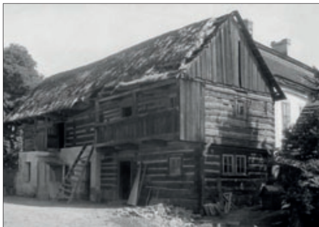
Obr. 7: Pavlovice, velmi cenný historický snímek zaniklého špýcharu s výměnkem při usedlosti čp. 2, který byl postaven nejspíš mezi lety 1807 a 1823. Jednalo se o patrový převážně roubený objekt se sedlovou střechou s doškovou krytinou. Při zadním štítu je patrná jednoduchá konstrukce podstávky, v patře byla situována předsazená pavlač. Přední zděný díl přízemí sloužil jako chlév, roubený jako obytná komora, výměnek byl umístěn v patře. Na fotografii z roku 1950 je patrný již jeho zhoršený stav s dožilou krytinou, cenný objekt byl následně v druhé polovině 20. století kompletně zbourán. Zadní plán snímku zachycuje budovu fary (archiv NPÚ ÚP, foto Vroňský, srpen 1950).
