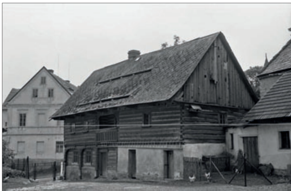
Obr. 13: Pavlovice, snímek ze dvora usedlosti čp. 11 na hlavní okapovou stranu jejího bývalého výměnku čp. 10. Výměnek byl postaven pravděpodobně ke konci 18. století jako patrová převážně roubená budova s obytným předním dílem a zadním dílem s chlévy v přízemí a komorou v patře. Patro vynášejí velmi bohatě profilovaná podstávka. Z typologického hlediska je velmi zajímavá zapuštěná krátká pavlač v patře, nacházející se v analogickém provedení i u mladších zděných usedlostí v Pavlovicích i okolí. Snímek zachycuje dále i dnes již zaniklou hospodářskou přístavbu, torzo zděné zadní části usedlosti bývalého čp. 10 a v levé části fotografie i patrovou budovu školy (fotografická sbírka Severočeského muzea v Liberci, foto J. Kabíček, 1968).
