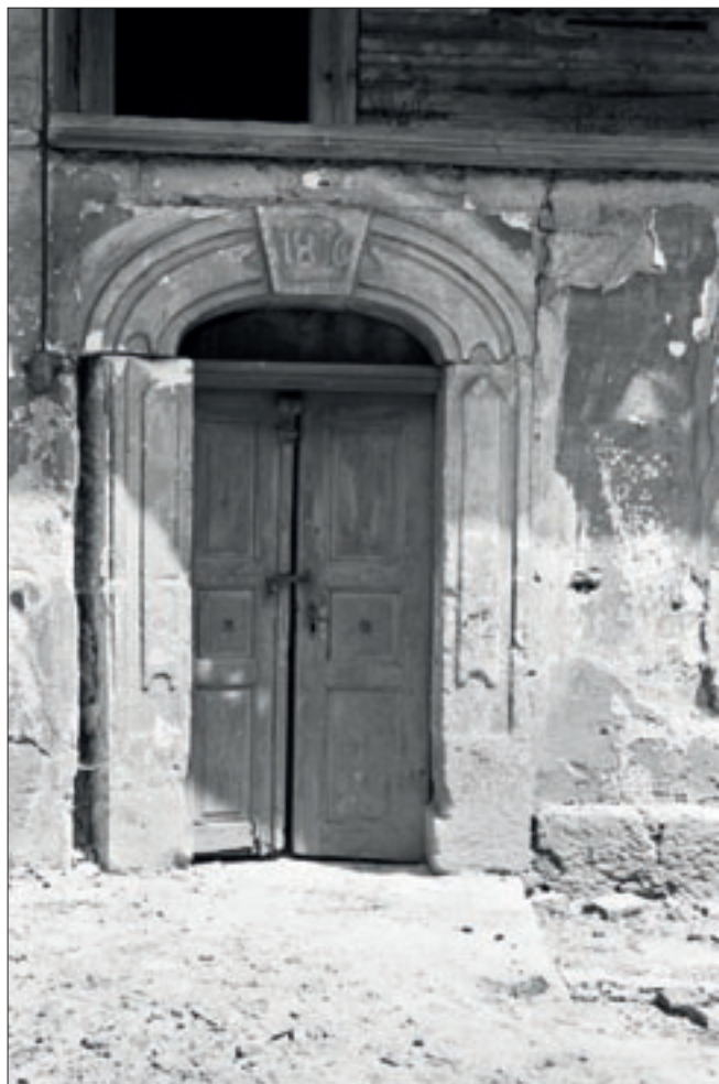
Obr. 36: Pavlovice, detail náročně pojednaného vstupního kamenného portálu zaniklého domu usedlosti čp. 37 s datací 1816. V portálu byly osazeny vstupní dvoukřídle kazetové dveře se zdobně pojednaným kováním. Nad portálem je zachycena i patrová roubená část zapuštěné pavlače (fotografická sbírka Severočeského muzea v Liberci, foto J. Kabíček, 1968).
