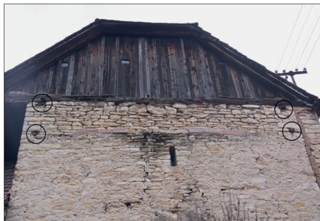
Obr. 13: Sedlec, pohled na zadní průčelí domu čp. 6. Kroužkem označené konce pozednic. Starší, spodní, pozednice byly dendrochronologicky datovány do roku 1780/1781, nad nimi vodorovná stavební spára. Po požáru v roce 1858 došlo k nadezdění koruny zdiva a vztyčení nového krovu. Po pravé straně domu je svislou stavební spárou oddělena mladší přízdívka, přízdívka k starší zdi při obnově domu v roce 1858.
