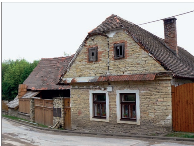
Obr. 19: Sedlec, pohled na dům čp. 20, který byl postaven po požáru v roce 1856.
