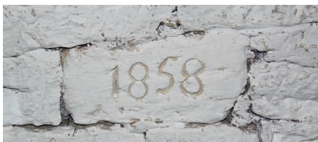
Obr. 14: Sedlec: a – pohled na kolmé hospodářské křídlo v usedlosti čp. 6; b – detail datace výstavby chlévů, potvrzující výstavbu ještě v téměř roce po požáru roku 1858.
