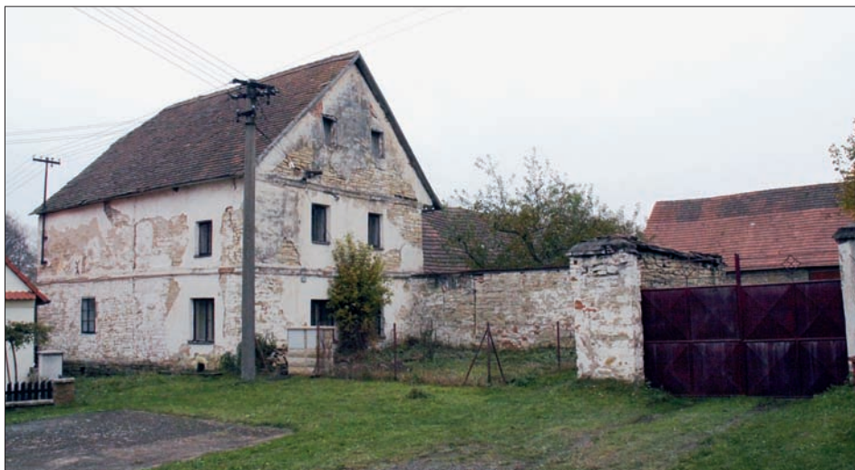
Obr. 12: Sedlec, pohled na severozápadní nároží domu v usedlosti čp. 6. Netypičnost domu byla dána jeho specifickou stavební adaptací z přelomu devatenáctého a dvacátého století, při níž byl odstraněn přední obytný díl a ke zbylé části domu byl přistavěn nový zděný štít a dům byl zkrácen. Nové obytné místnosti byly zřízeny v někdejší síni a komoře. Prostor po odstraněném předním dílu domu je vymezen ohradní zdí.
