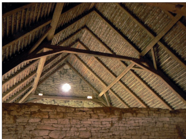
Obr. 10: Sedlec, Rankova konstrukce krovu ve stodole v usedlosti čp. 5. Stodola byla postavena po požáru usedlosti v roce 1857.
