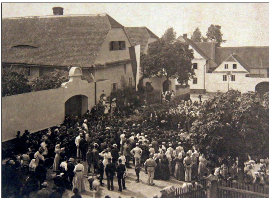
Obr. 4: Sedlec, historická fotografie návsi vesnice z počátku dvacátého století. Vlevo dům v usedlosti čp. 11 je nápadný roubeným předním dílem s navazující zděnou patrovou síní a zadními komorami. Toto uspořádání odpovídá stavební charakteristice pozdně středověkých vesnických domů. Dům byl zbořen v roce 1972. V zadní návesní frontě je zachycen patrový dům v usedlosti čp. 15 a výměnek v usedlosti čp. 16. (fotografie ze sbírek J. Táborského, uložena v čp. 33 Sedlec).
