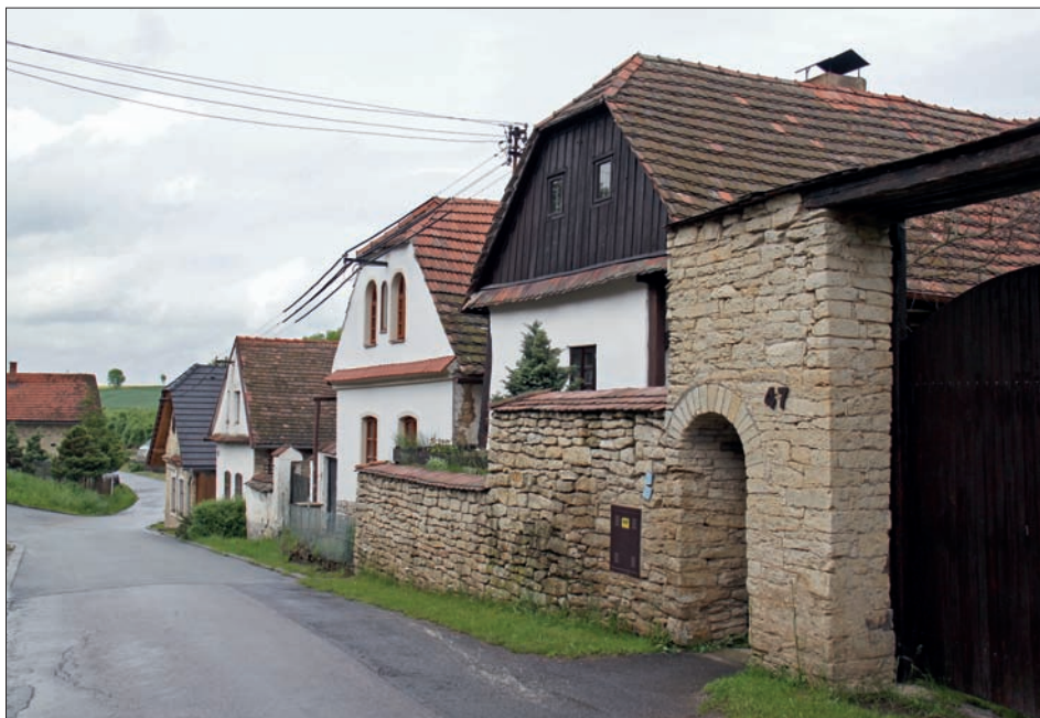
Obr. 3: Sedlec, pohled na domkářskou zástavbu v severní části vesnice, při komunikaci směrem do Vraclavi, zprava čp. 47, 22, 21, 20.
