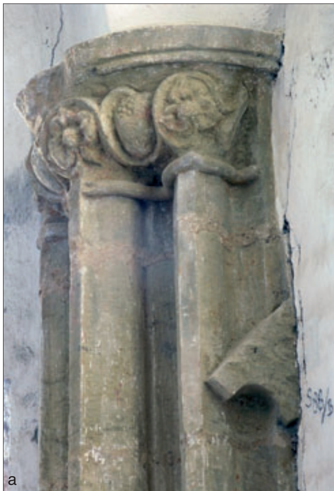
Obr. 12: Benátky nad Jizerou, kostel Narození Panny Marie, přípora, a – detail výběhu podokenní římsy pod konzolou přípory, b – sokl přípory.
