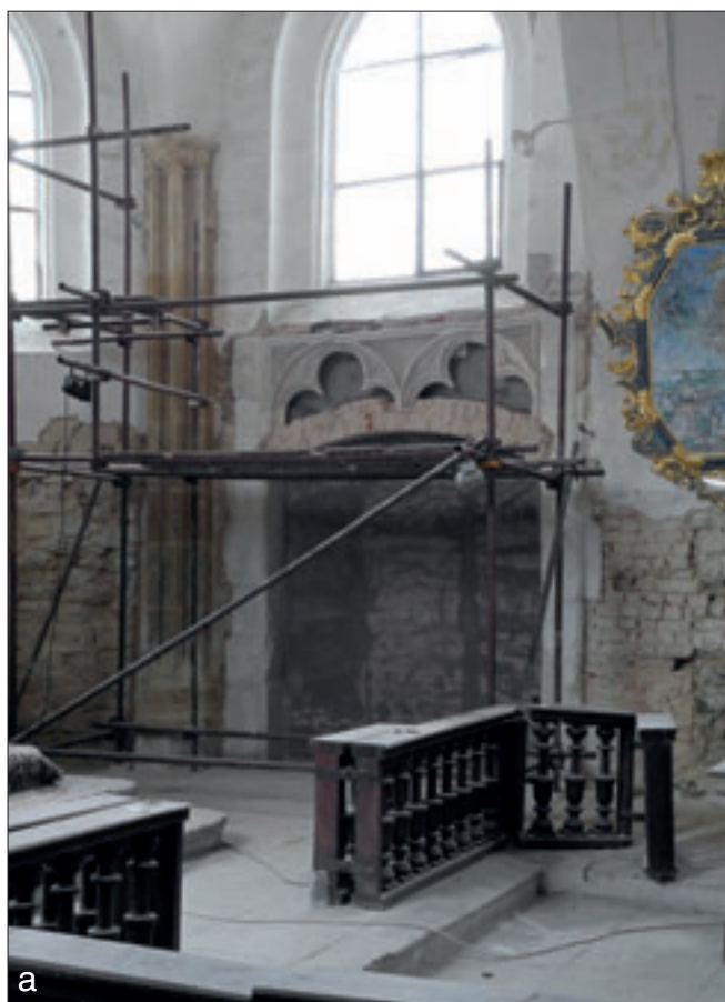
Obr. 13: Benátky nad Jizerou, kostel Narození Panny Marie: a – jižní stěna závěru s odkrytým výklenkem, pravděpodobně sedilí. Z původního gotického výklenku se zachovaly kvádry ostění. Kružba byla zřejmě při pozdější úpravě snesena níž, čemuž nasvědčují druhotně odsekané části horních kvádrů ostění pro její vložení. Výška původního výklenku by tak odpovídala výšce dochovaných výběhů původní podokenní římsy. K posunutí kružby mohlo dojít nejspíše v souvislosti se snížením parapetů oken závěru. V další fázi stavebních úprav byl vložen cihelný pas a došlo i k odsekání profilace ostění pod pasem. Při poslední úpravě byl výklenek ze strany interiéru zaslepen cihelnou zazdívkou o tloušťce 15 cm. Při současné obnově interiéru byla cihelná zazdívka odstraněna. Foto zachycuje stav v průběhu prací; b – Cihelná plenta o šířce 60 cm vpravo od ostění výklenku v místě předpokládané přípoje, která byla zřejmě odstraněna v souvislosti s vložení renesanční klenby.
