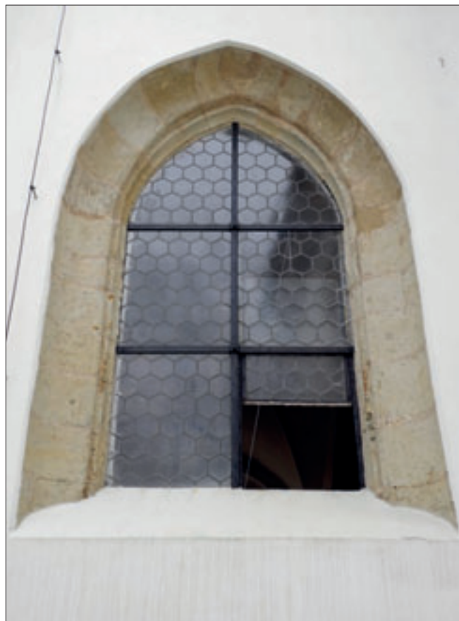
Obr. 27: Benátky nad Jizerou, kostel Narození Panny Marie, okno závěru s ostěním s hlubokým výžlabkem sesazené druhotně z původních gotických oken.
