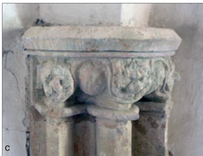
Obr. 11: Benátky nad Jizerou, kostel Narození Panny Marie, hlavice, původně konzoly přípor pro sochy: a, b – severní konzola s erbem pánů z Dražic, c – severovýchodní konzola, d – jihovýchodní konzola, e – jižní konzola, stav v průběhu restaurátorského průzkumu a snímání bílých nátěrů. Ve spodní vrstvě byly zjištěny zbytky oranžového okru (směs žlutých a červených okrů s příměsí černí) a v další vrstvě zbytky červené barevnosti (žluté a červené kysličníky železa), které však byly zachovány i na poškozených a druhotně odlámaných částech. Původní barevnost nebyla průzkumem prokázána. Hlavice restauroval ak. soch. M. Pokorný v listopadu 2012, mikroskopický rozbor odebraných vzorků D. Pechová, 2012.
