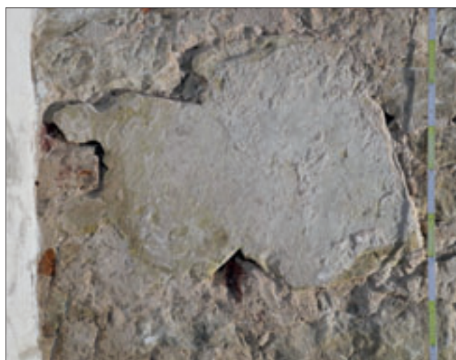
Obr. 20: Benátky nad Jizerou, kostel Narození Panny Marie, pískovcový článek s trojicí hruškových prutů (spodní zakryt omítkou) a rytými konstrukčními linkami ve směru příčné a podélné osy ukončené středním hruškovým profilem a dvou os symetricky pod úhlem 28 stupňů.
