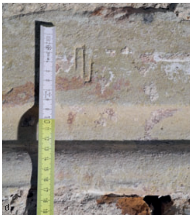
Obr. 18: Benátky nad Jizerou, kostel Narození Panny Marie: a – západní pole severní stěny se zazděným portálem; b – detail profilace v sondě horního rohu; c – detail sondy soklu; d – kamenická značka v nadpraží.
