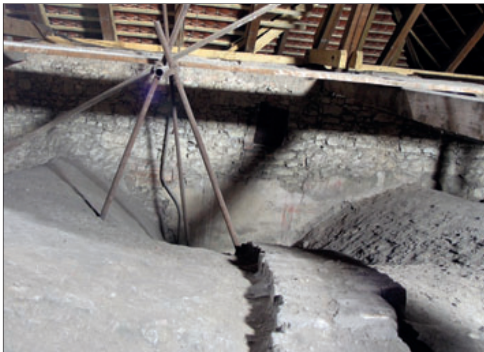
Obr. 25: Benátky nad Jizerou, kostel Narození Panny Marie, podkroví kostela, pohled na severní stěnu s omítkou s pozdně gotickou malbou nad rubem renesanční klenby.
