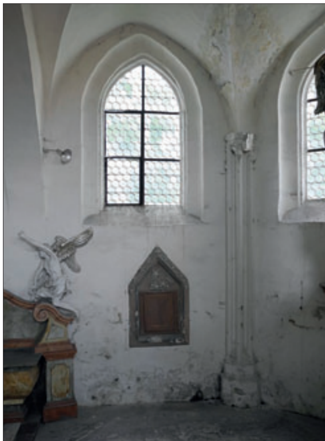
Obr. 9: Benátky nad Jizerou, kostel Narození Panny Marie, interiér kostela, severní stěna závěru se sanktuářem a příporou v nároží, jejíž hlavice byla zřejmě původně konzolou pro sochu. Erb pánů z Dražic je umístěn nejen na konzole přípor, ale také v tympanonu sanktuáře (stav před opravou, 2006).
