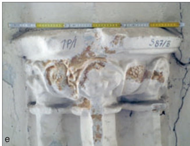
Obr. 11: Benátky nad Jizerou, kostel Narození Panny Marie, hlavice, původně konzoly přípor pro sochy: a, b – severní konzola s erbem pánů z Dražic, c – severovýchodní konzola, d – jihovýchodní konzola, e – jižní konzola, stav v průběhu restaurátorského průzkumu a snímání bílých nátěrů. Ve spodní vrstvě byly zjištěny zbytky oranžového okru (směs žlutých a červených okrů s příměsí černí) a v další vrstvě zbytky červené barevnosti (žluté a červené kysličníky železa), které však byly zachovány i na poškozených a druhotně odlámaných částech. Původní barevnost nebyla průzkumem prokázána. Hlavice restauroval ak. soch. M. Pokorný v listopadu 2012, mikroskopický rozbor odebraných vzorků D. Pechová, 2012.
