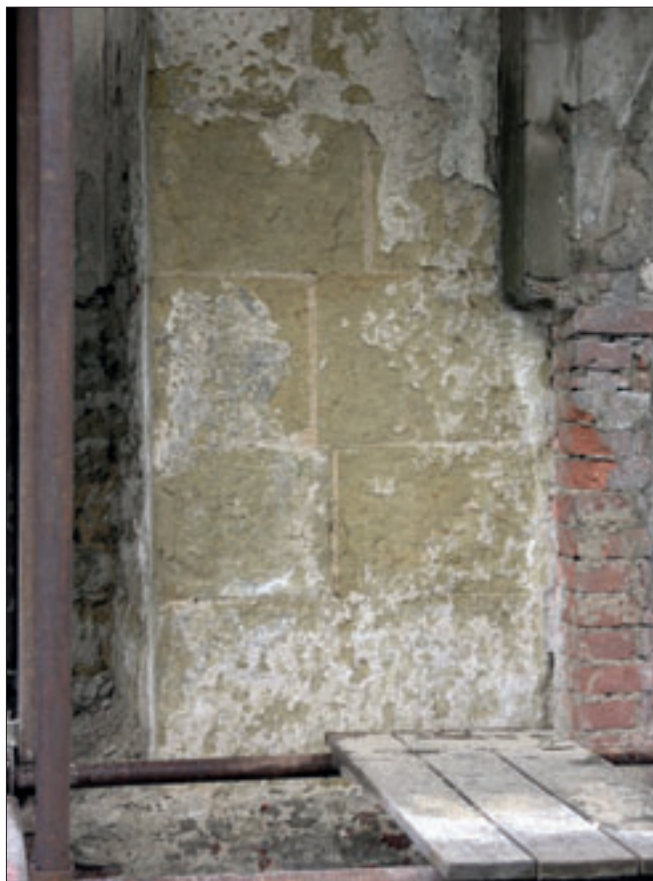
Obr. 26: Benátky nad Jizerou, kostel Narození Panny Marie, detail kvádrového zdiva původního opěráku (stav v průběhu opravy 2005).
