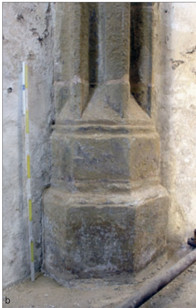
Obr. 12: Benátky nad Jizerou, kostel Narození Panny Marie, přípora, a – detail výběhu podokenní římsy pod konzolou přípory, b – sokl přípory.
