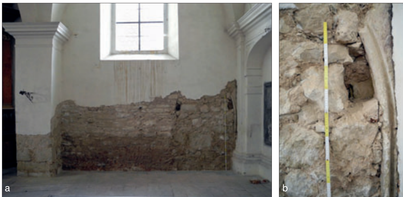
Obr. 21: Benátky nad Jizerou, kostel Narození Panny Marie: a – západní pole jižní stěny se zazděným vstupem v pravé třetině a částí ostění portálu v nároží; b – detail ostění.
