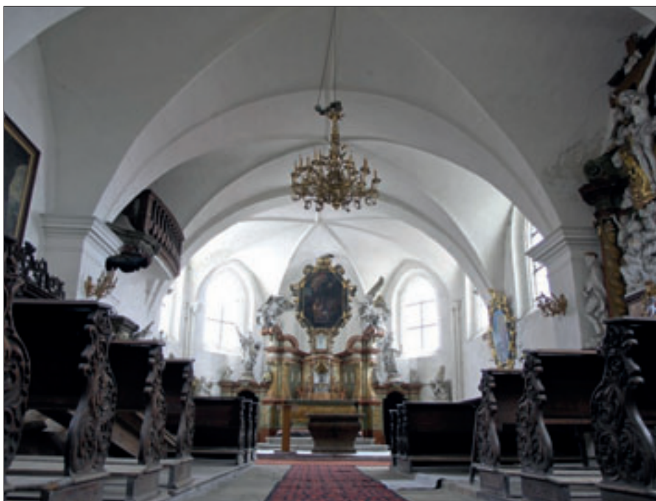
Obr. 5: Benátky nad Jizerou, kostel Narození Panny Marie, interiér kostela, pohled k závěru (stav před opravou 2006).
