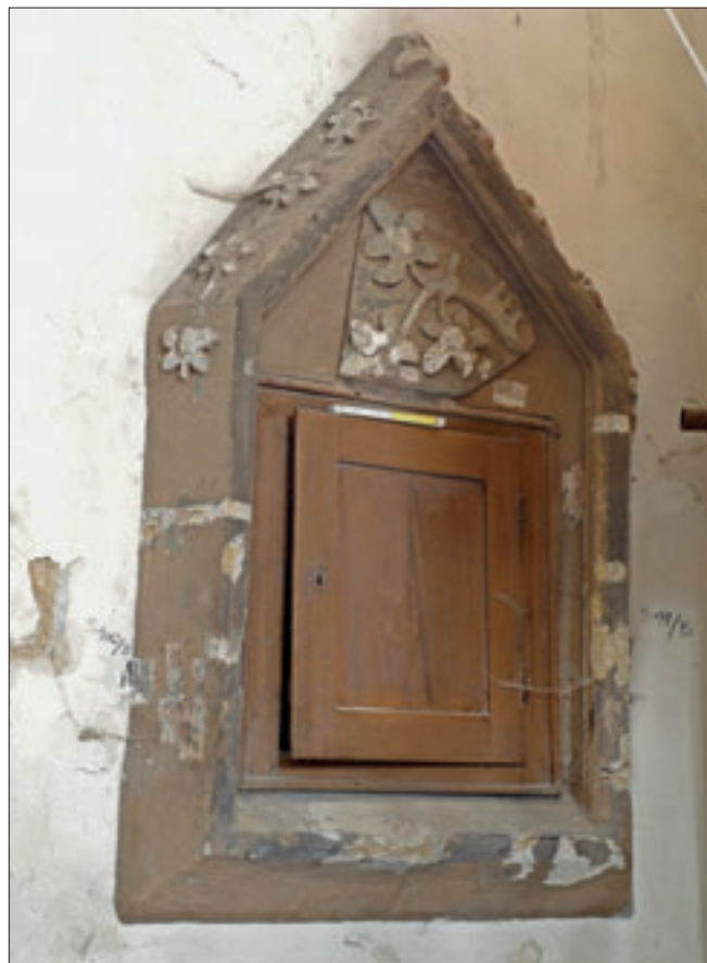
Obr. 10: Benátky nad Jizerou, kostel Narození Panny Marie, sanktuář v severní stěně závěru s erbem pánů z Dražic. Restaurátorským průzkumem byly zjištěny doplňky a překryvy štukem s náterý, u erbu pak doplňky modelace listů ze sádky.
