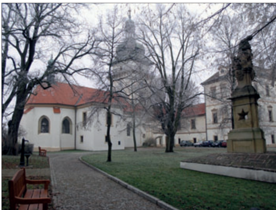
Obr. 4: Benátky nad Jizerou, kostel Narození Panny Marie, pohled na kostel od severovýchodu s navazující budovou zámku na západní straně.
