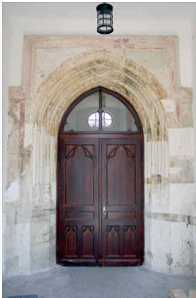
Obr. 21: Jedlka, kostel sv. Anny, jižní portál lodí v přízemí věže v pohledu od jihu.
