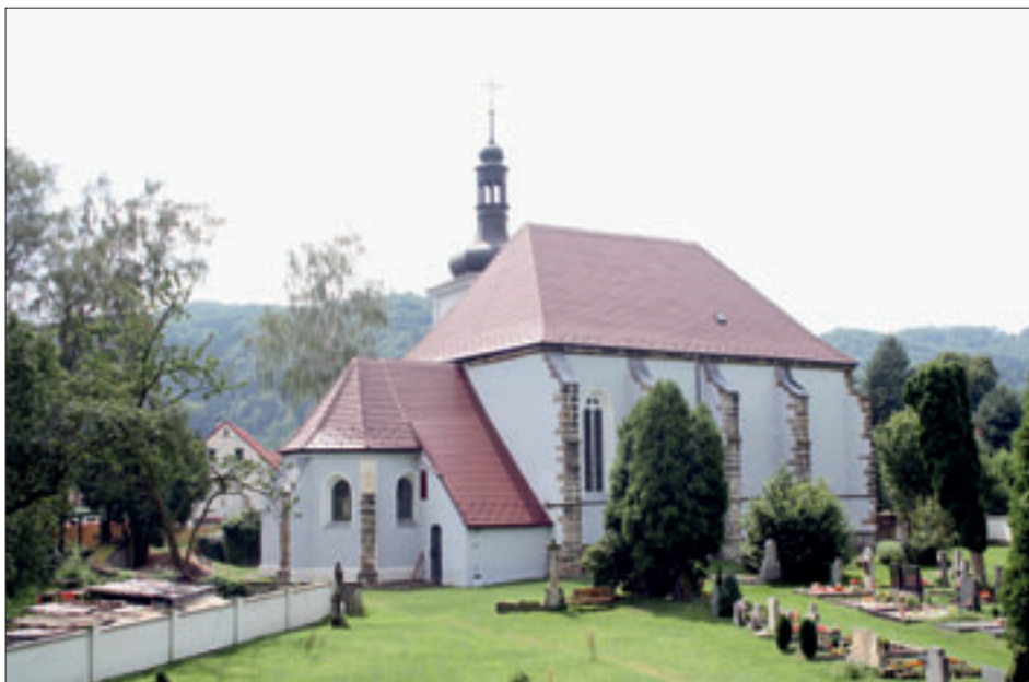
Obr. 2: Jedlka, kostel sv. Anny, celkový pohled od severovýchodu. Stav po opravě zakončené v roce 2012 (všechny snímky J. Skopec, 2012).
