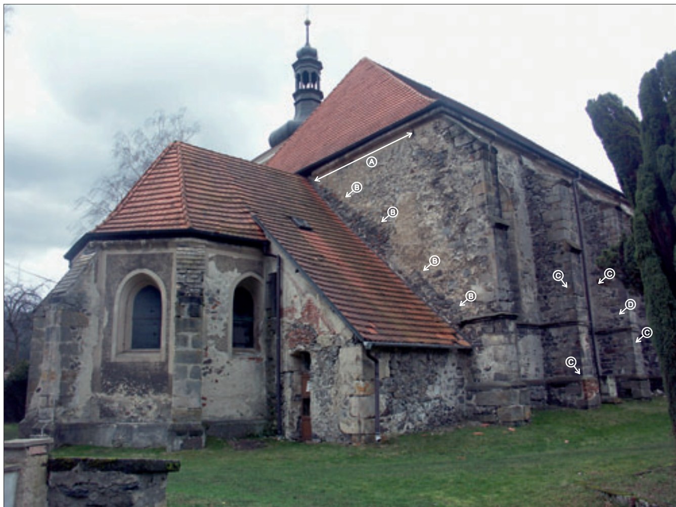
Obr. 33: Jedlka, kostel sv. Anny, pohled od severovýchodu. Stav před opravou započatou roku 2009. A – úsek korunní římsy s odlišnou profilací než zbytek římsy, B – negativní otisk po starší sedlové střeše, C – otisk střechy a stavební zásahy po zavázání zdiva bývalé kostnice, D – otisk po starší střeše kostnice. Opěrný pilír v nároží lodi má jako jediný přímou pultovou stříšku.
