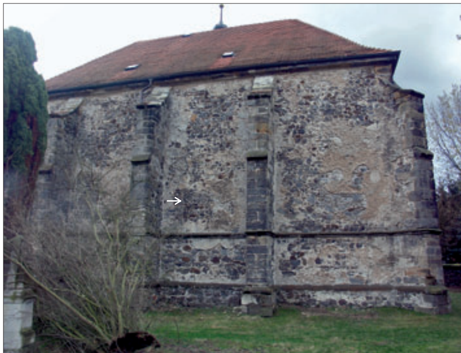
Obr. 32: Jedlka, kostel sv. Anny, severní stěna lodi v pohledu od severu. Stav před opravou započatou roku 2009. Zde se patrně nacházela okna shodná s oknem v západním poli. Šipka označuje vertikální spáru indikující jedno z nich.
