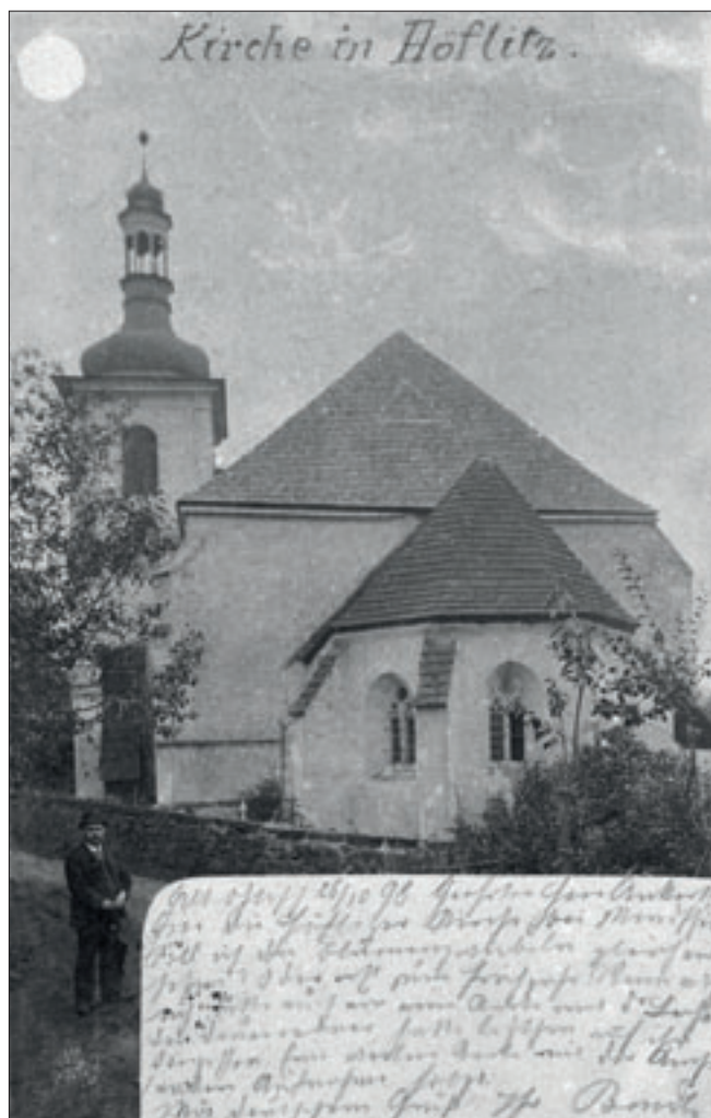
Obr. 31: Jedlka, kostel sv. Anny, celkový pohled od východu na fotografii prošlé poštou v roce 1898. V oknech jsou patrné kružby, které byly odstraněny při úpravách na počátku 20. století. V téže době došlo i k odstranění krytého schodiště do prvního patra věže. Na střeších je již položena bobrovka, která v roce 1894 nahradila původní dřevěný šindel (soukromá sbírka Petra Jozy).
