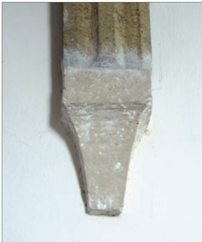
Obr. 25: Jedlka, kostel sv. Anny, severní klenební konzole v presbytáři. Tento typ se nachází pod všemi výběhy žeber obdélného klenebního pole
