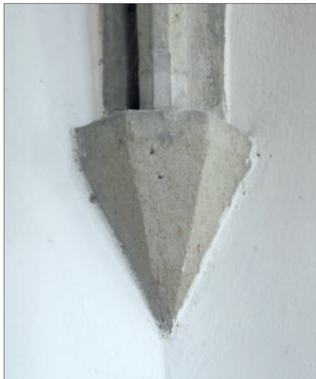
Obr. 26: Jedlka, kostel sv. Anny, severovýchodní klenební konzole v závěru presbytáře. Shodné konzole se nacházejí ve všech třech koutech závěru.
