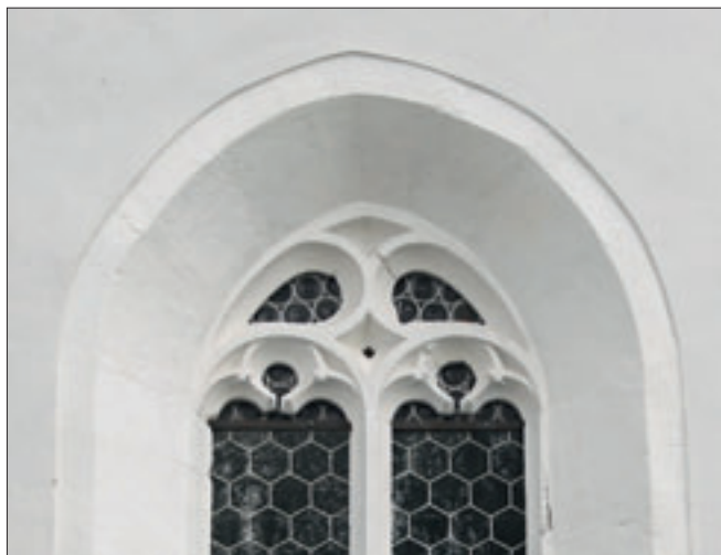
Obr. 17: Jedlka, kostel sv. Anny, detail kružby jihovýchodního okna lodi.
