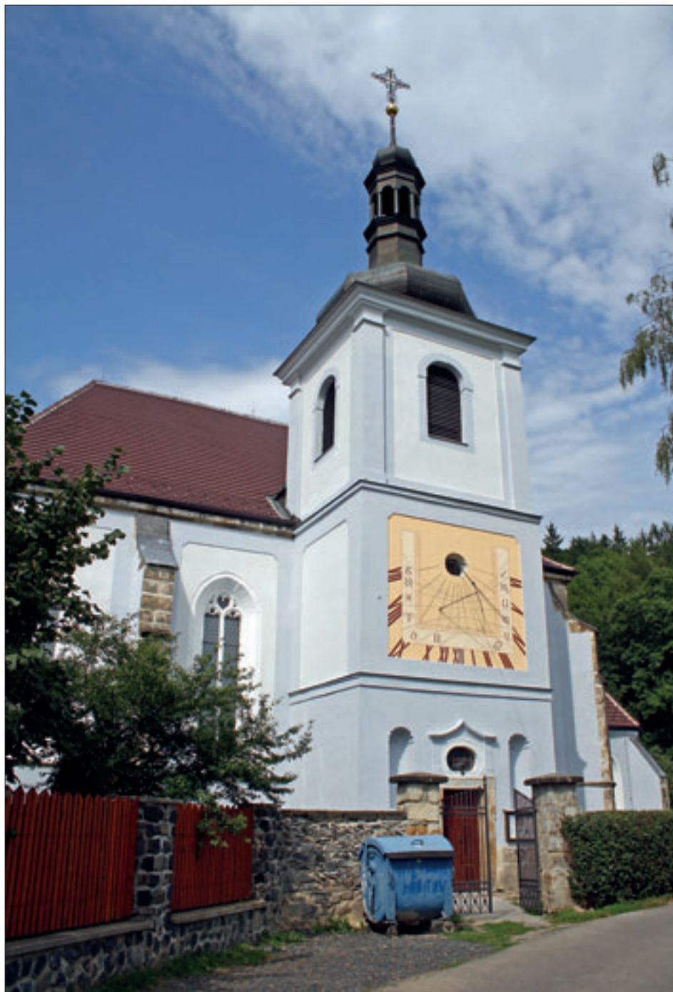
Obr. 27: Jedlka, kostel sv. Anny, loď s věží v pohledu od jihozápadu.
