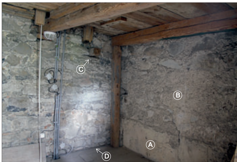
Obr. 28: Jedlka, kostel sv. Anny, interiér spodní etáže prvního patra věže. Pohled do severozápadního kouta. A – 2 cm silný a 60 cm vysoký pás utahované omítky s vápenným nátěrem, B – hrubá vápenná omítky, C – odříznutý trám původní podesty schodiště z první fáze vertikální komunikace věže, druhý trám byl osazen za sloupkem, kde se po něm nachází kapsa, D – jizva po prahovém trámu původního stropu přezemí věže.
