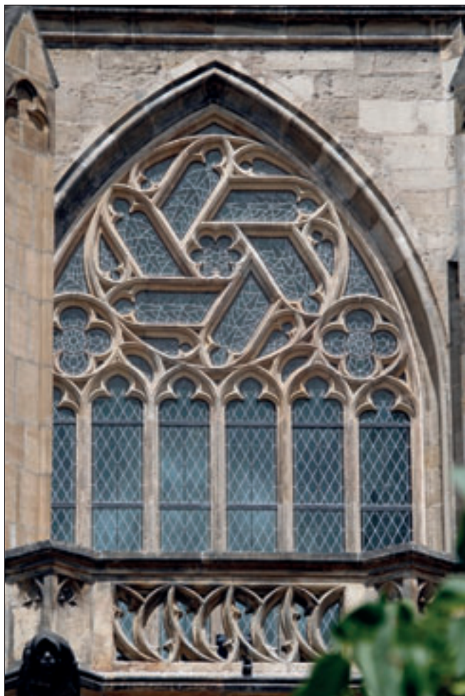
Obr. 16: Kolín, chrám sv. Bartoloměje, druhé okno (od západu) v jižní stěně vysokého chóru. Jeho kružba s rotujícími přímými jeptiškami se stala do značné míry jakousi „parléřovskou ikonou“, velmi často publikovanou i v zahraniční literatuře. Parléřovská huť, 70.–80. léta 14. století, v dnešní podobě přesná kopie Ludvíka Láblera z r. 1906.
