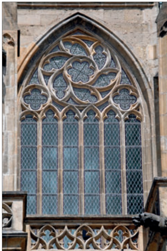
Obr. 17: Kolín, chrám sv. Bartoloměje, první okno (od západu) v jižní stěně vysokého chóru. Jeho původní kružba se nedochovala, zřejmě byla zničena při požáru r. 1796; stávající byla nově zhotovena dle návrhu Josefa Mockera r. 1883, na základě analogií s ostatními kružbami vysokého chóru. Žádnou z nich ovšem nekopíruje.
