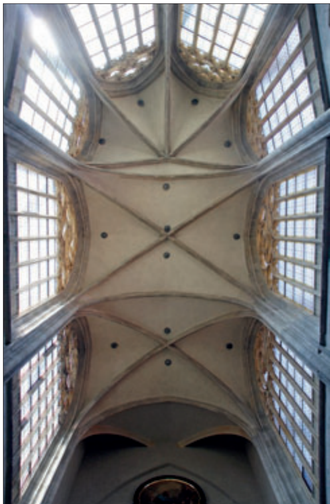
Obr. 10: Kolín, chrám sv. Bartoloměje, pohled do klenby vysokého chóru, dokončeno zřejmě před r. 1378. Nejzápadnější pole se žebry zabíhajícími do hmoty štítu doplněno až při rekonstrukci r. 1906.
