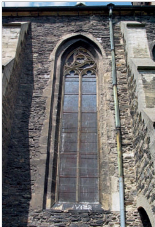
Obr. 21: Kolín, chrám sv. Bartoloměje, okno v pátém poli (od západu) jižní stěny lodi. Levá strana ostění patří původnímu raně gotickému oknu, při úpravách (zřejmě na počátku 15. století) bylo okno rozšířeno východním směrem, což naznačuje asymetrický základnek. Původní kružba nahrazena v letech 1906 – 7 kopií.
