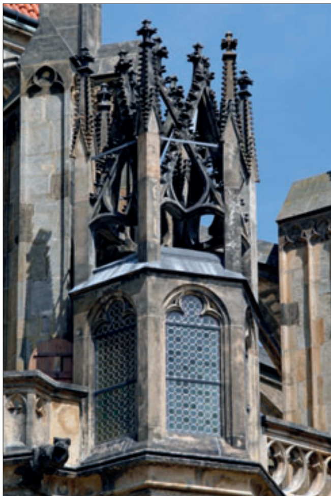
Obr. 14: Kolín, chrám sv. Bartoloměje, „Lucerna“ schodiště jižního ochozu s jedinečnou fialovou korunou. Původně parlářovská huť, 70.–80. léta 14. století, v dnešní podobě kopie (zřejmě velmi přesná) Josefa Mockera z r.1887.
