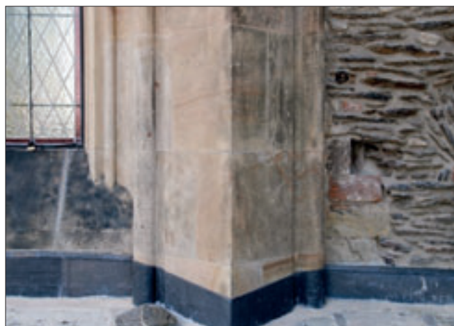
Obr. 24: Kolín, chrám sv. Bartoloměje, detail přípory nejzápadnějšího okna severní strany vysokého chóru. Sondou do zdiva, provedenou v létě 2012, bylo potvrzeno, že se zde nachází plně provedená profilace dalšího okna, připravovaná k pokračování stavby západním směrem.
