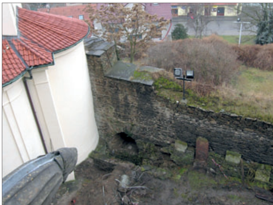
Obr. 6: Průchod hlavní hradbou v nadhledu z kostelního chóru. Vlevo kostnice. Před průchodem novodobá tarasní zídka s dočasně obnaženým severním lícem (snímek autor, leden 2008).
