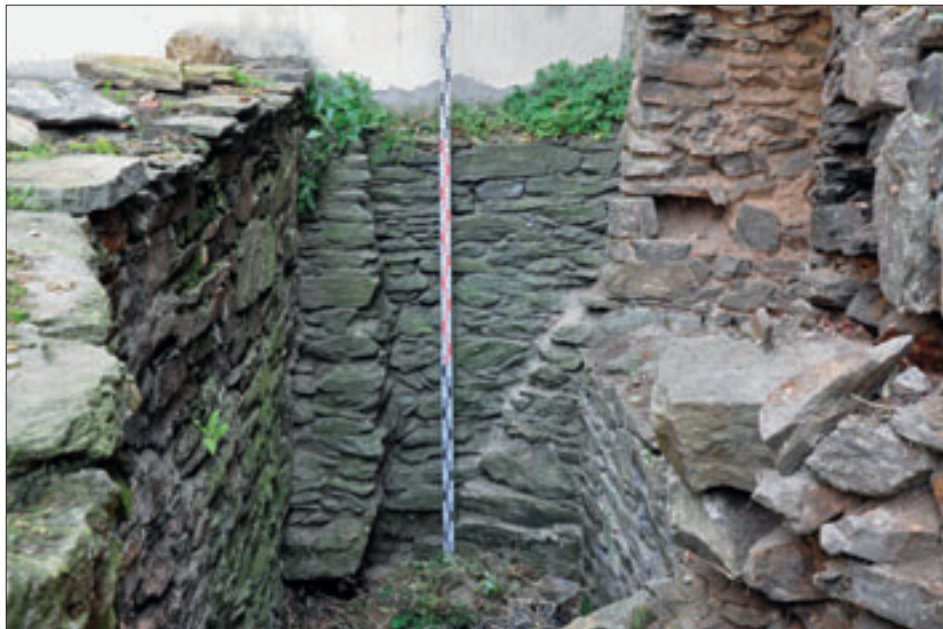
Obr. 11: Průhled sníženou partií terénu před průchodem směrem k východu (v pozadí nahoře kostnice). Vpravo vnitřek průchodu s jedním z otvorů pro nosníky bednění klenby, níže zadržka průchodu a fragment výběhu východní zdi šije (srov. obr. 10). Za měřickou latí líc zdiva, související snad se založením barokní kostnice (současný s ním je patrně také předstupující zdivo s nárožím vlevo). Zcela vlevo novodobá tarasní zídka (snímek autor, 2012).
