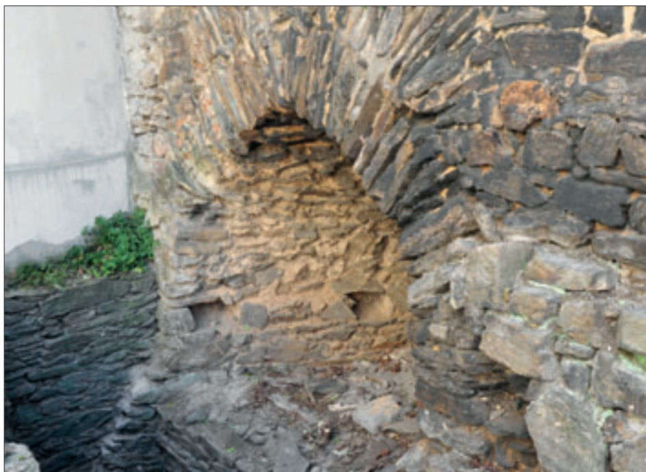
Obr. 12: Pohled na východní stěnu vnitřku průchodu (srov. obr. 11) se dvěma otvory pro nosníky bednění klenby (snímek autor, 2012).
