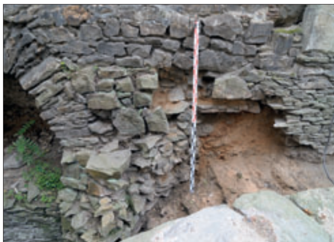
Obr. 9: Detail výběhu západní zdi šije (srov. obr. 4 a 8) v době záchranného archeologického výzkumu. Vpravo od měřické latě je za chybějícím lícem základové partie hradby obnaženo geologické podloží, které zde vystupuje do poněkud vyšší úrovně než bylo zjištěno v sondách dál směrem k západu od tohoto místa. Zcela vpravo zpevnění základového zdiva tenkými kusy lomového kamene z 19. století (snímek Z. Neustupný, 2009).
