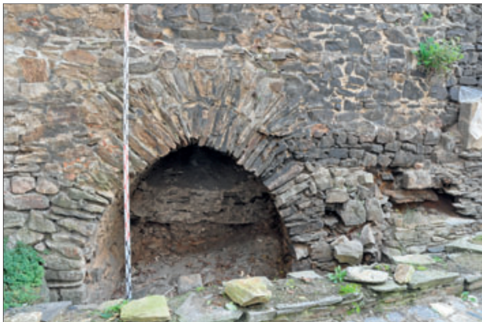
Obr. 7: Celkový pohled na průchod hlavní hradbou od severu (srov. obr. 4). V pozadí otvoru je dobře patrné souvrství, jež jej směrem do parkánu zaslepuje. V popředí koruna novodobé tarasní zidky (snímek autor, 2012).
