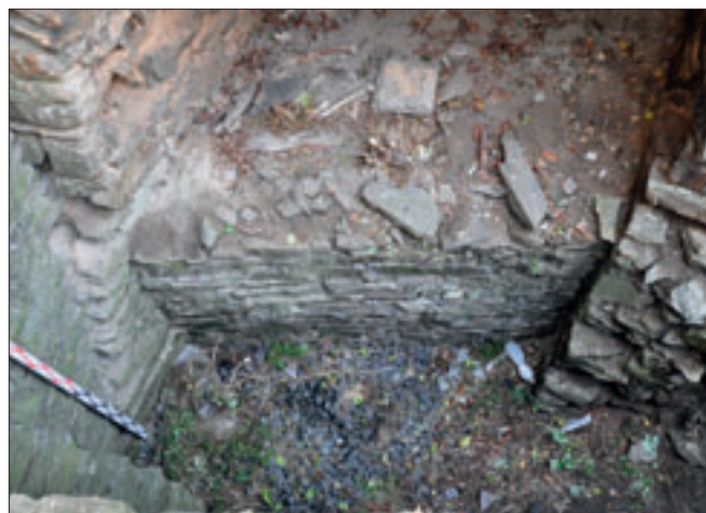
Obr. 10: Pohled z koruny tarasní zidky na dolní část průchodu. Uprostřed zazdívka dolní části průchodu, po obou jejích stranách fragmenty postranních zdi šije (snímek autor, 2012).
