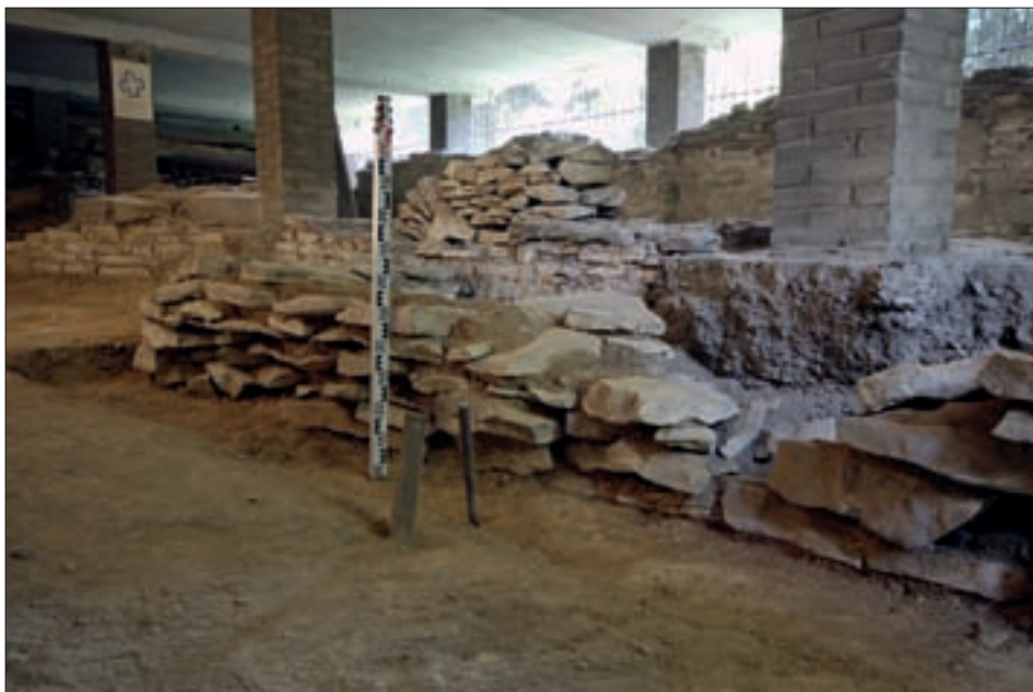
Obr. 4: Vyšehrad, areál sv. Vavřince. Pohled od severozápadu na líc základového zdiva nahrazeného bazilikou.
