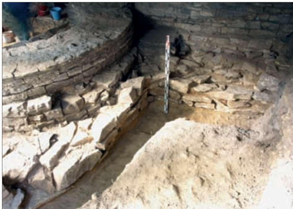
Obr. 9: Vyšehrad, areál sv. Vavřince. Pohled od jihovýchodu na základové zdivo stavby nahrazené bazilikou, které po zalomení směřuje k východu (doprava), mimo zkoumanou plochu.
