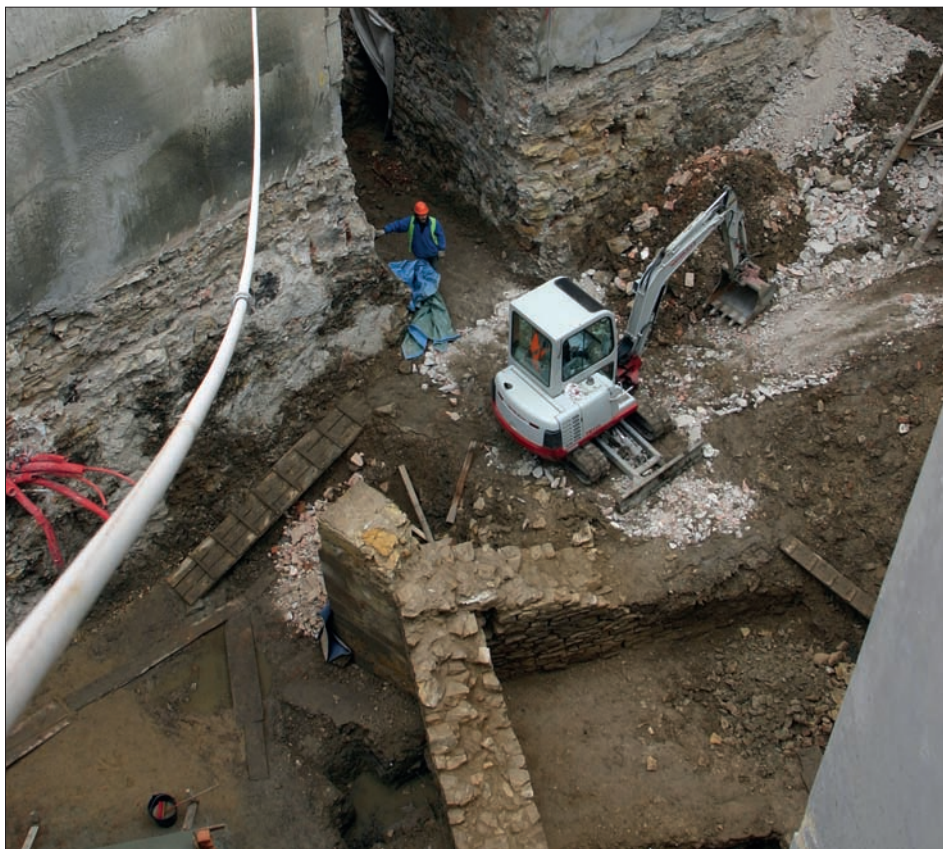
Obr. 4: Praha-Malá Strana, dvůr mezi čp. 28 a 33/III. Nárožní opěrák na JZ rohu východního traktu na ploše J. Opěrák byl vyzděn z lomového opukového kamene, který byl na nárožích zpevněn armovacími pískovcovými kameny. Pohled od S (foto M. Müller, 2007).
