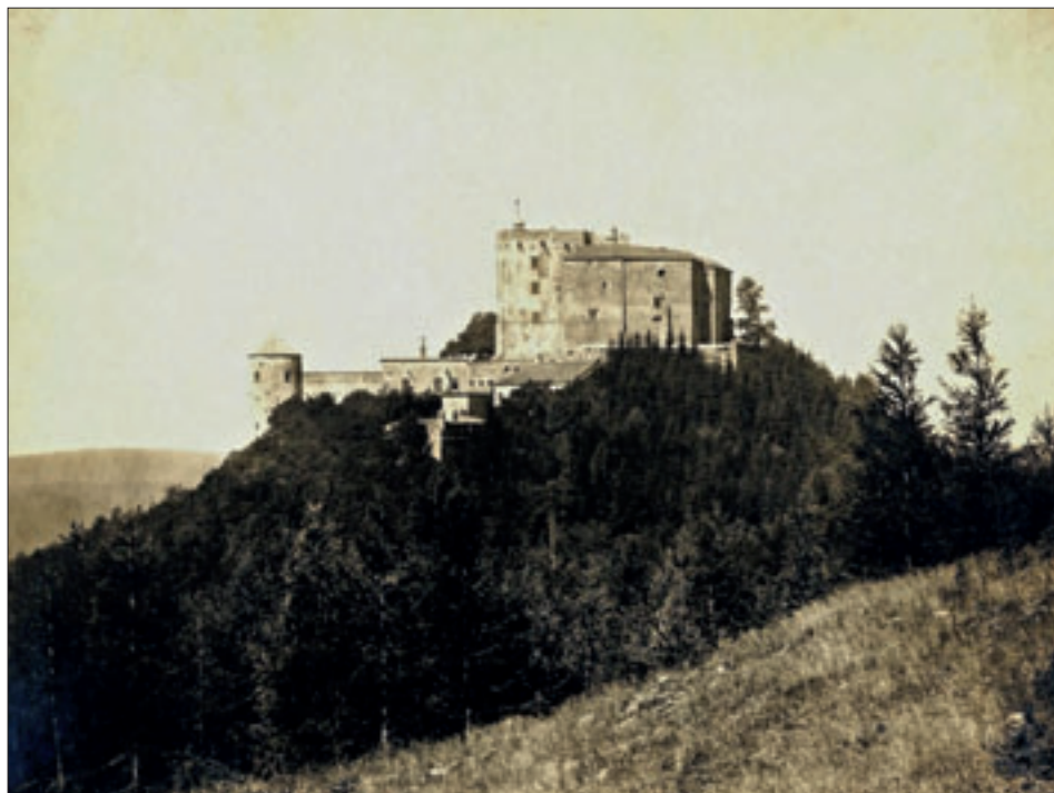
Obr. 1: Hrad Buchlov, celkový pohled od východu; vysoký blok budov v pravé části areálu tvoří hradní jádro. V levé části jádra, s fasádami, pokrytými z velké části omítkami, ční kaplová věž, která vznikla v 16. století, nástavbou raněgotického objektu s bránou a výstavnou kaplí v patře. Napravo, krytý nízkou stříškou, navazuje severní trakt s pozůstatky východní, pozdněrománské věže (srov. obr. 3/A), napravo pak vidíme východní průčelí severního traktu s arkýřem a sousední záchodovým rizalitem, odstraněným v 50. letech 20. století (srov. obr. 36). (Fotografie ze závěru 19. století, fotoarchív NPÚ ÚOP v Brně). Pokud není uvedeno jinak, kresby i foto Radim Vrla, 2012.
