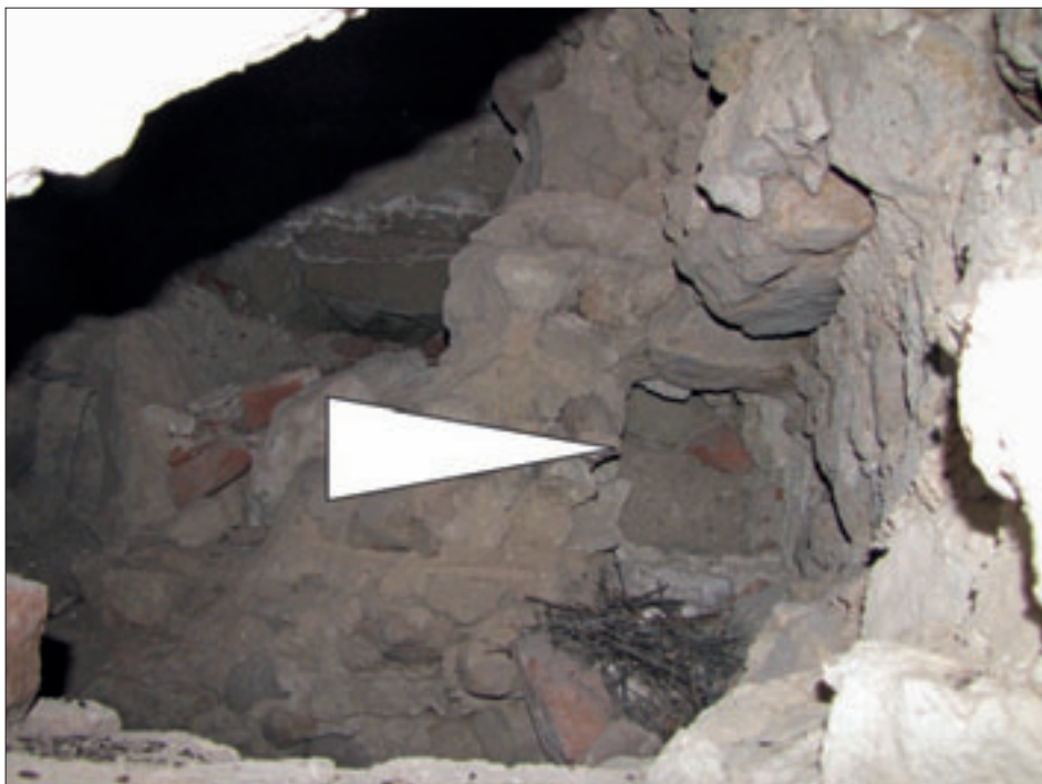
Obr. 21: Hrad Buchlov, místnost č. 13, detail průrazu v jižní stěně, šipka ukazuje na lůžko po stropním trámu, pohled od severu.
