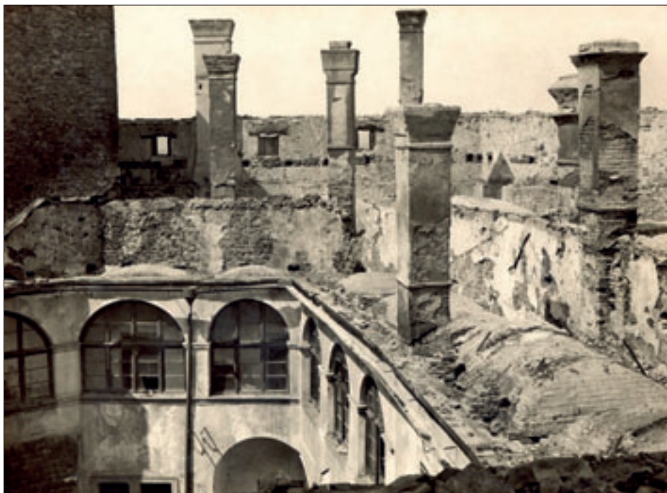
Obr. 34: Hrad Buchlov, půda severního křídla, pohled na severozápadní stranu nádvoří jádra, pohled od jihovýchodu; vlevo nahoře severovýchodní nároží západní věže, napravo na ni navazuje vnější zídka půdního prostoru. Pod okenními otvory horizontální pás neomítaného (?) zdiva s kapsami po příčných trámech. Zcela vpravo je líc téže zídky – beze stop těchto otvorů (!). (Snímek z r. 1931, fotoarchív NPÚ ÚOP v Brně).
