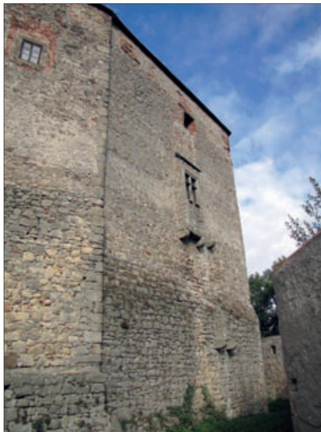
Obr. 6: Hrad Buchlov, pohled na severovýchodní fasádu traktu; nalevo je nároží východní věže, vpravo parkánová hradba; nad arkýřem se rýsuje plocha zazděného otvoru (?), dole konzoly dalšího, dnes odstraněného arkýře (srov. obr. 1), pohled od jihovýchodu.
