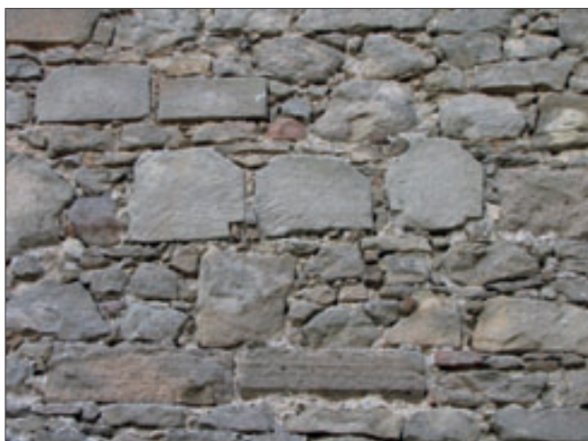
Obr. 12: Hrad Buchlov, hranolový rizalit, detail spodní části severního průčelí nad soklovou římsou, pohled na soubor druhotně použitých architektonických prvků, pohled od severu.
