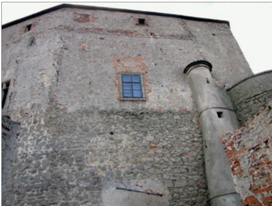
Obr. 14: Hrad Buchlov, pohled na severozápadní část průčelí traktu (obr. 3/D); dole, pod omítkovou plochou je mimo snímek vstup do parkánu; nad ním vodorovná spára, oddělující horní, mladší zdivo, nahoře anomálie líce pod zdivem s půdními okénky, napravo je patrná svislá spára (obr. 3/E), pod ní pak záchodová věžka a torzo oblého rizalitu (vpravo); pohled od severu.
