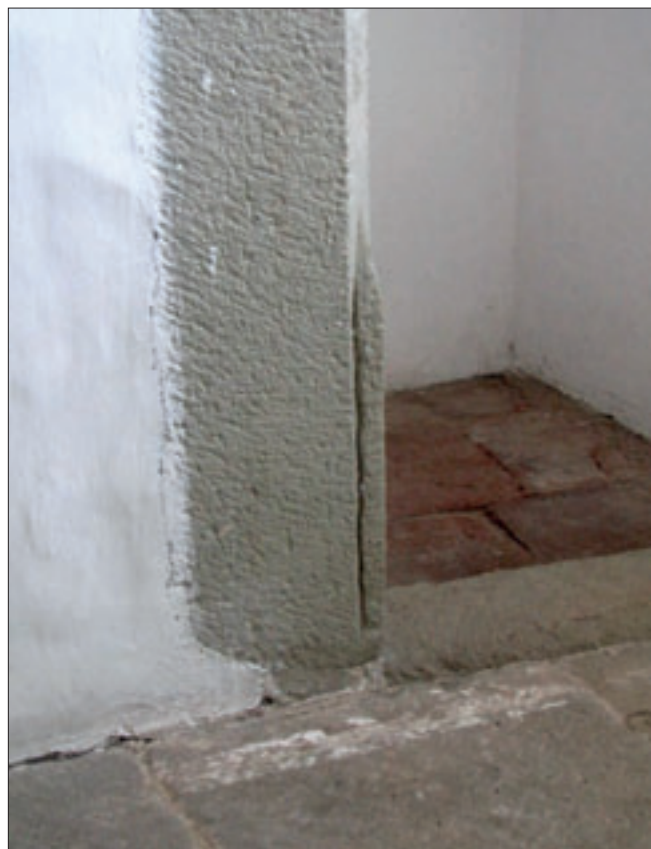
Obr. 25: Hrad Buchlov, místnost č. 22, detail levé trnože sedlového portálu vstupu do zrušeného záchodového arkýře; pod původním ukončením okosení probíhá svislá rýha, naznačující, že okosení mělo být později protaženo až k úrovni prahu.
