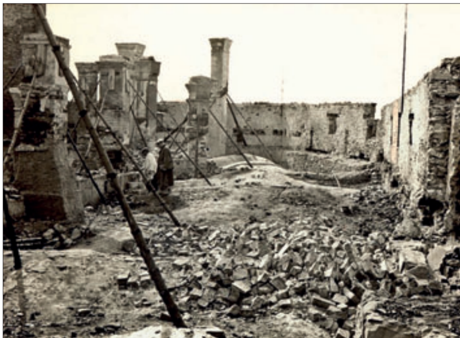
Obr. 32: Hrad Buchlov, historická fotografie půdy po požáru v roce 1931, pohled od jihu; napravo je z destruívané partie při západní zdi hranolového rizalitu je zde patrna sendvičová konstrukce zdiva, líc pravé části zdi je zřejmě opatřen omítkou. U paty levé části se rýsuje otisk po horizontálním trámu – průběh dřevěné konstrukce je dále vidět až téměř k severozápadnímu nároží v pozadí. Kolem okénka v průhledu (napravo od nároží) jsou patrné dva, symetricky situované svíslé, tmavší pásy (pravděpodobně opět jizvy po dřevěných konstrukcích). Dále vlevo je na vnější stěně patrná vodorovná, tmavá linie (zdivo bez omítek). V popředí, před vstupem do rizalitu, je zachycena hromada sutí ze zříceného zdiva, obsahujícího převážně vysoké cihly („prstovky“). (Snímek z r. 1931, fotoarchív NPÚ ÚOP v Brně).
