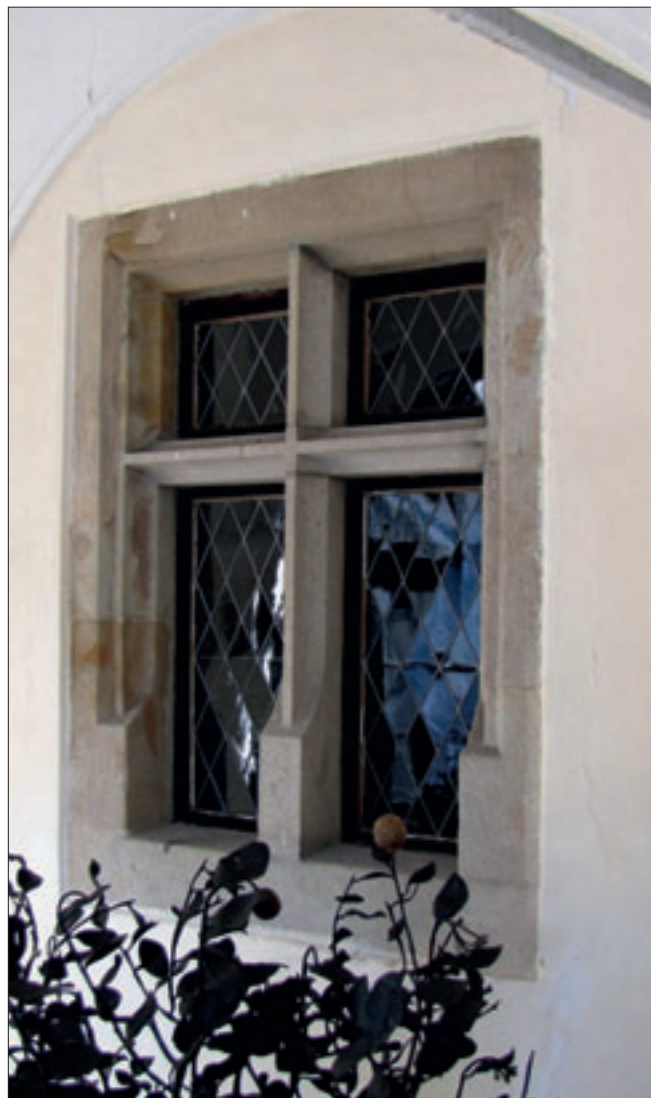
Obr. 28: Hrad Buchlov, pohled z dvorního traktu na ostění okna v jižní zdi místnosti č. 25, pohled od jihovýchodu.
