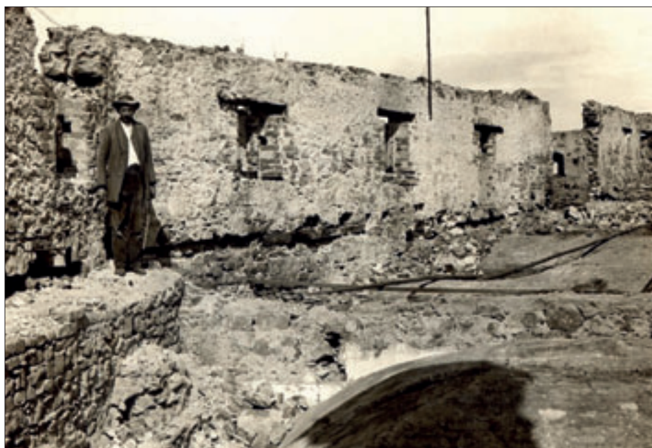
Obr. 33: Hrad Buchlov, půda severního křídla, pohled severovýchodní část obvodové zídky, pohled od západu; napravo průhled do interiéru rizalitu, dole příčka mezi partiemi C a D. Ve spodní partii zídky jsou patrné prohořelé zbytky a otisky horizontálně položených trámů, lícujících s vnitřní stěnou zídky. Nad trámy jsou místy patrné pravidelně rozmístěné otvory po příčně ložených trámcích. Obdobné jizvy po dřevěných konstrukcích jsou patrné i v partii blíže rizalitu; horizontální trám je zde položen níže. U překladů okének je vidět, že prohořely až do vnější fasády. (Snímek z r. 1931, fotoarchív NPÚ ÚOP v Brně).
