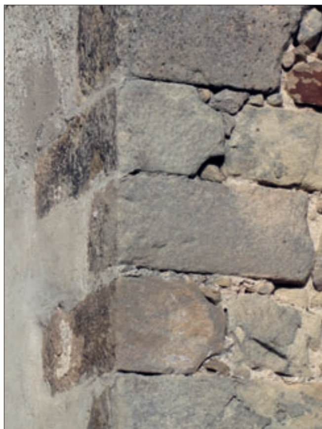
Obr. 4: Hrad Buchlov, druhotně použité architektonické detaily v armatuře jihovýchodního nároží východní věže, pohled od jihovýchodu (srov. obr. 3/1).
