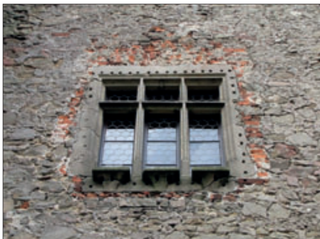
Obr. 13: Hrad Buchlov, detail východního okna rytířského sálu; nad překladem ostění je patrný starší, cihelný pas; pohled od severu.
