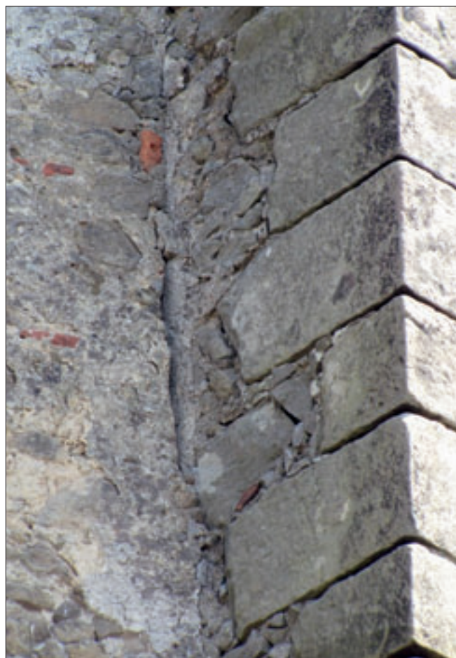
Obr. 35: Hrad Buchlov, detail styku severní stěny východní věže (vpravo) se stěnou severního traktu. Napravo je zachycena armatura severozápadního nároží věže, nalevo jsou pak zbytky omítky věže, zabíhající pod přiložené zdivo severního traktu (pohled od severozápadu).
