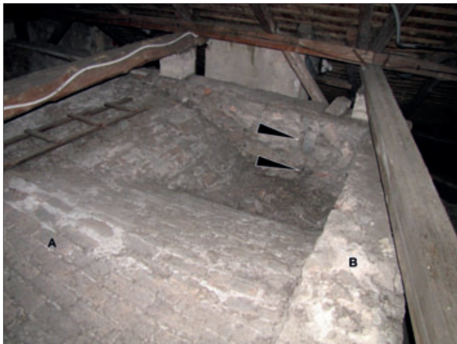
Obr. 29: Hrad Buchlov, půda, detail rubu klenby (A) nad místností č. 31, obklopeného subtilní zídka (B) s nelicovanou vnitřní stranou a s otisky dřevěných konstrukcí (označeno šipkami), pohled od severu do severozápadního koutu prostoru.
