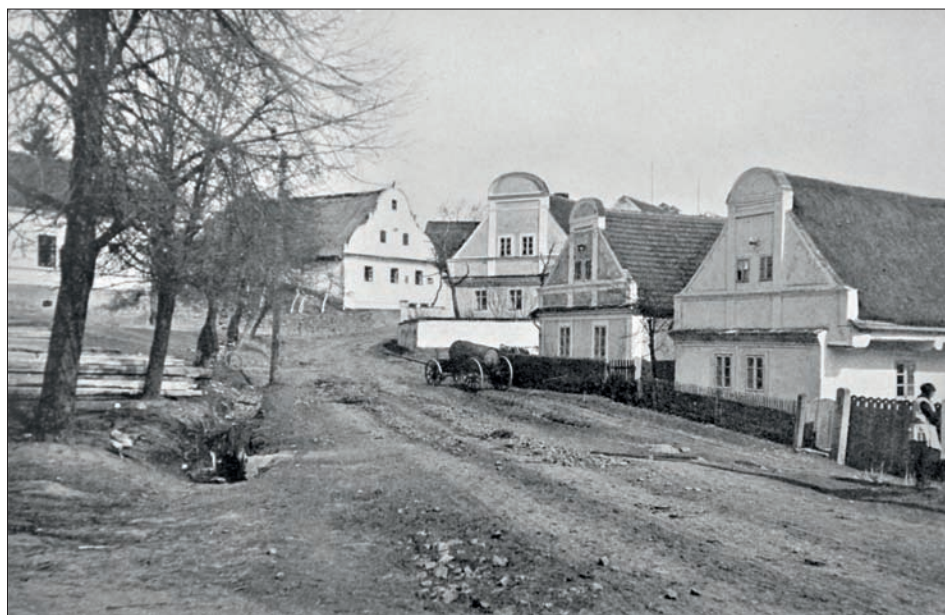
Obr. 1: Návěs v Nezabavěticích (okr. Plzeň-jih), velký dokumentační význam má v poznání venkova především fotodokumentace, a to historická i současná, neboť podoba vesnic se neustále proměňuje a tradiční stavby rychle podléhají novodobé stavební činnosti. Fotografie asi z 20. let 20. století (převzato z: F. Šváb – J. Tykač – J. Resl – J. Brož – L. Lábeč edd., Národopis lidu Československého. Díl IV. Plzeňsko. Praha 1934, obr. 46).
