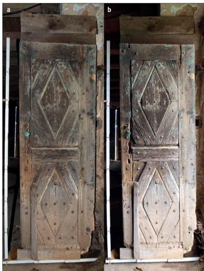
Obr. 1: Prohoř (okres Karlovy Vary), sýpka, v rámci přípravy metodiky jsou dokumentovány prvky na vybraných ohrožených stavbách. Jsou aplikovány různé metody dokumentace a přitom sledovány rozdíly, výhody a nevýhody. Na ukázkce jsou dva příklady fotodokumentace: a – s bleskem; b – při šikmém dopadajícím denním světle (všechny snímky autor, 2012).
