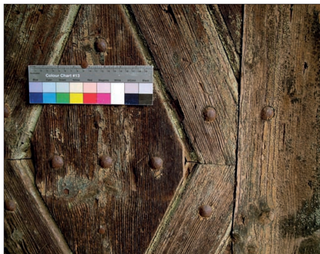
Obr. 2: Prohoř, sýpka, zbytky barevných povrchových úprav je vhodné fotografovat v detailu a s přiloženou fotografickou barevnou škálou. Důležité je spolu s fotodokumentací provést popis, neboť určení stratigrafie nátěrů může být z fotografie problematické.
