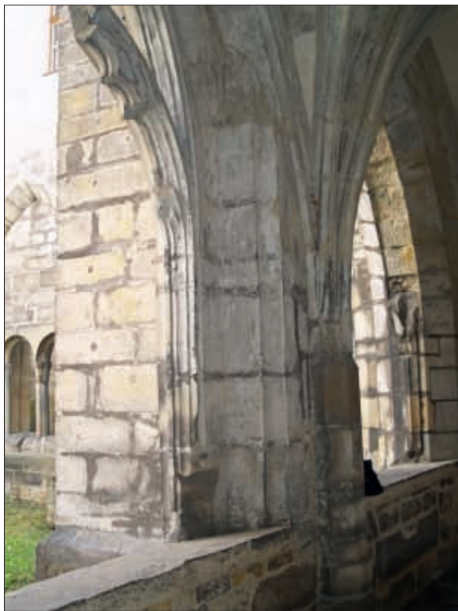
Obr. 19: Roudnice nad Labem, bývalý klášter augustiniánů kanovníků. Dvorní arkády jižního ramene ambitu. Stav 2012.
