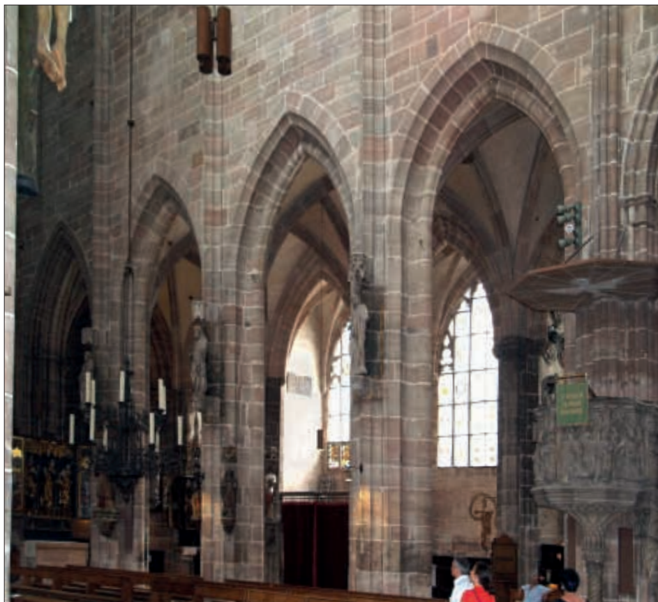
Obr. 46: Norimberk, kostel sv. Lorenze. Tři nejvyšší arkády mezi jižní boční lodí a lodí hlavní. Stav 2009.
