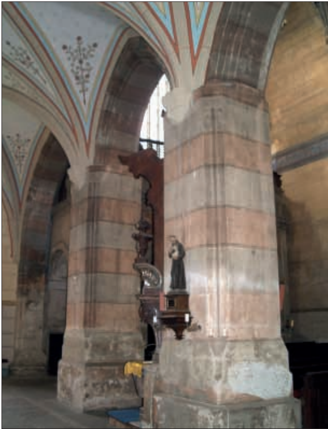
Obr. 17: Slaný (okres Kladno), kostel sv. Gotharda. Dva západní pilíře jižní arkády hlavní podí, pohled z jižní boční lodi. Zřetelná je profilace nároží pilířů a profilace mladších arkádových oblouků. Stav 2012.
