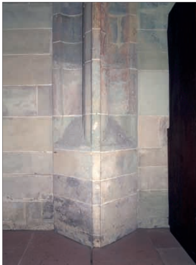
Obr. 42: Soest, kostel St. Maria zur Wiese. Přípory v boční lodi. Stav 2010.
