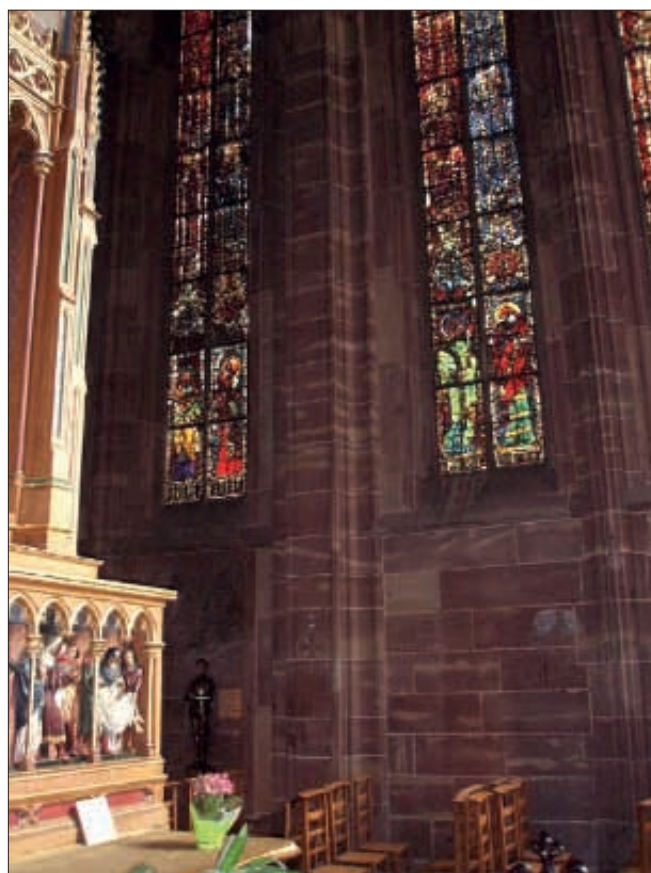
Obr. 32: Štrasburk (Francie), katedrála, kaple sv. Kateřiny při jižním boku. Pohled na jižní stěnu. Stav 2009.
