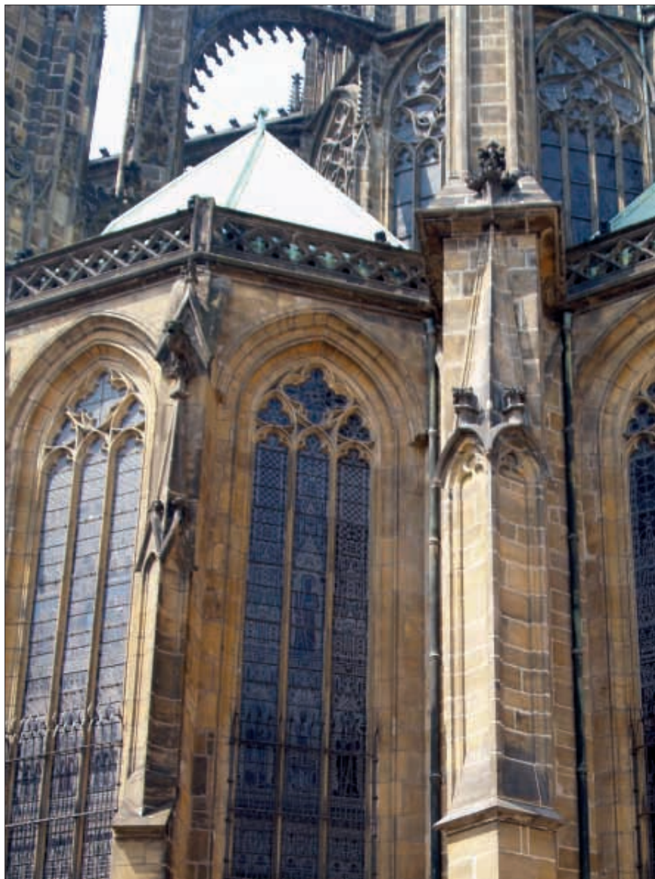
Obr. 31: Praha, katedrála sv. Víta. Východní závěr s opěrnými pilíři. Stav 2012.
