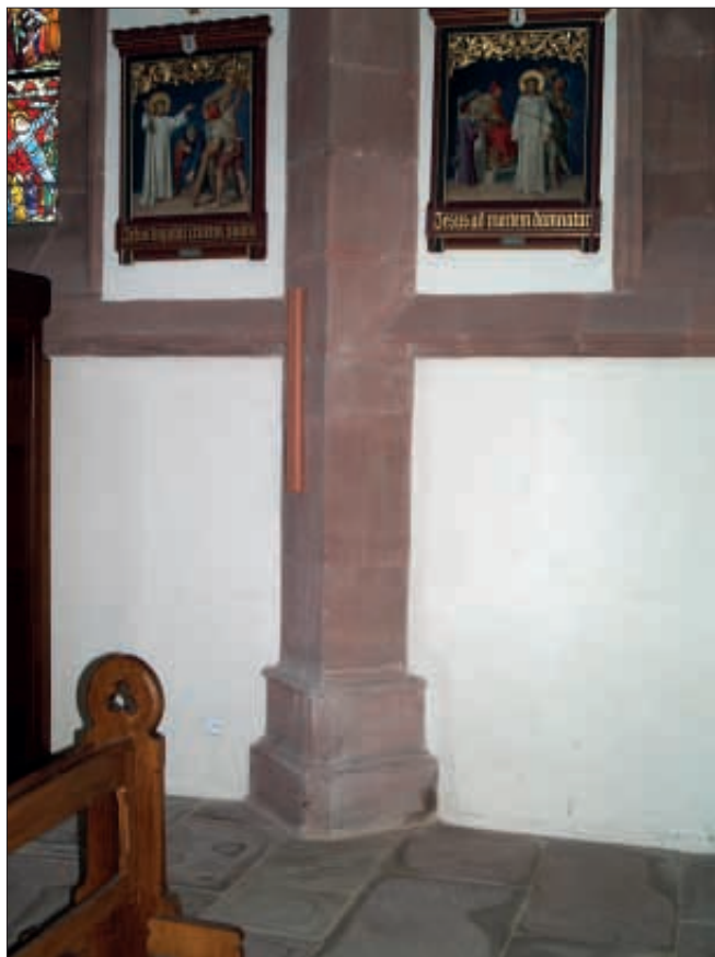
Obr. 36: Niederhaslach, kostel sv. Florentia. Přípora v boční lodi. Stav 2009.
