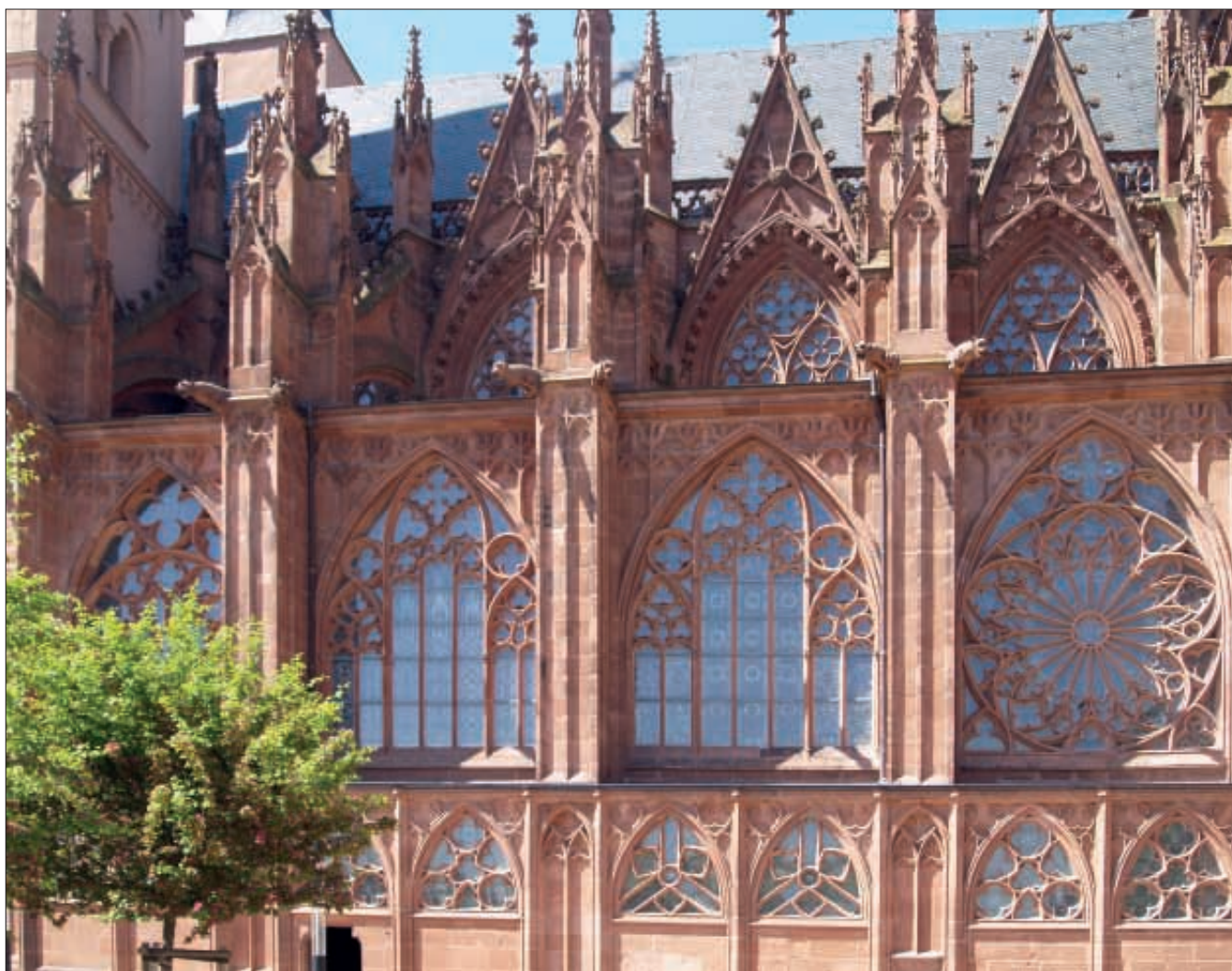
Obr. 12: Oppenheim (Německo), kostel sv. Kateřiny, jižní průčelí. Stav 2013.
