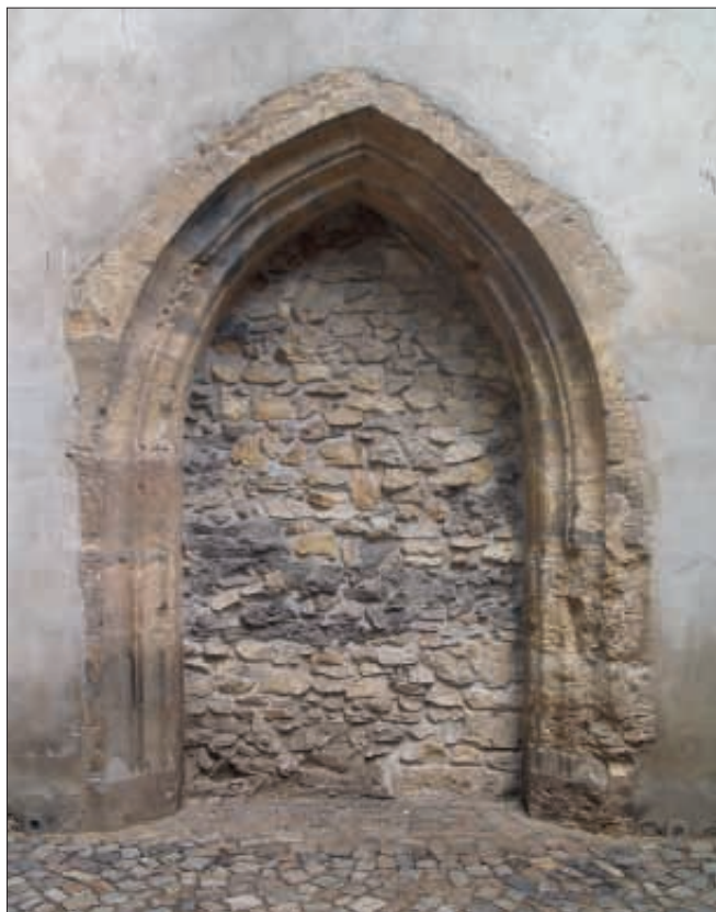
Obr. 8: Praha, ženský dominikánský klášterní kostel u sv. Anny. Jižní portál s dvojitě vyžlabeným ostěním. Stav 2011.
