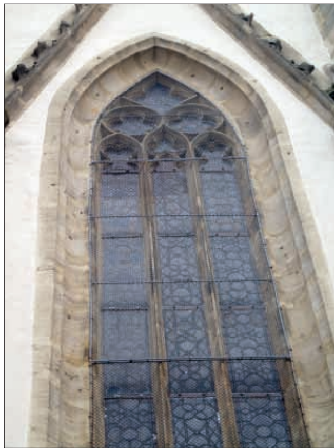
Obr. 23: Nabburg, kostel sv. Jana Křtitele, okno severozápadního pole západního chóru kostela. Stav 2012.
