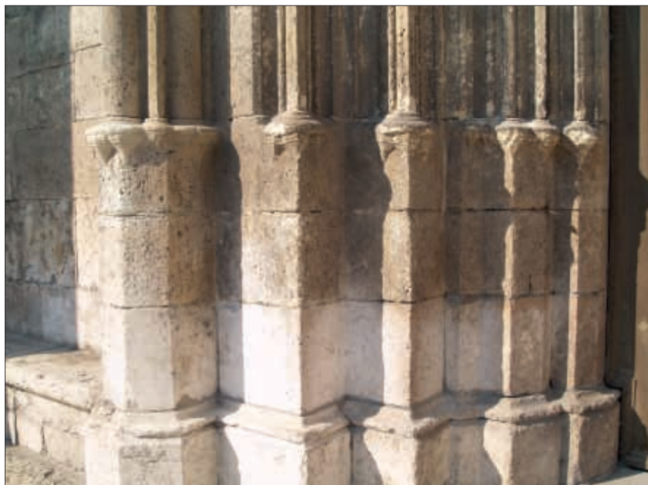
Obr. 39: Řezno, katedrála. Konzoly západního ostění jižního portálu. Stav 2011.
