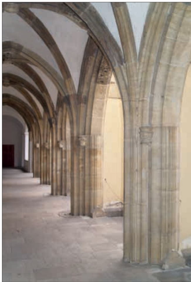
Obr. 9: Praha, klášter minoritů u kostela sv. Jakuba. Pohled do severního ramene ambitu na arkády do rajského dvora. Stav 2011.
