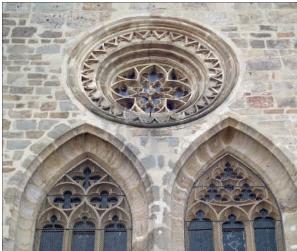
Obr. 21: Nabburg (Německo), kostel sv. Jana Křtitele, roseta jižního průčelí transeptu kostela. Stav 2012.
