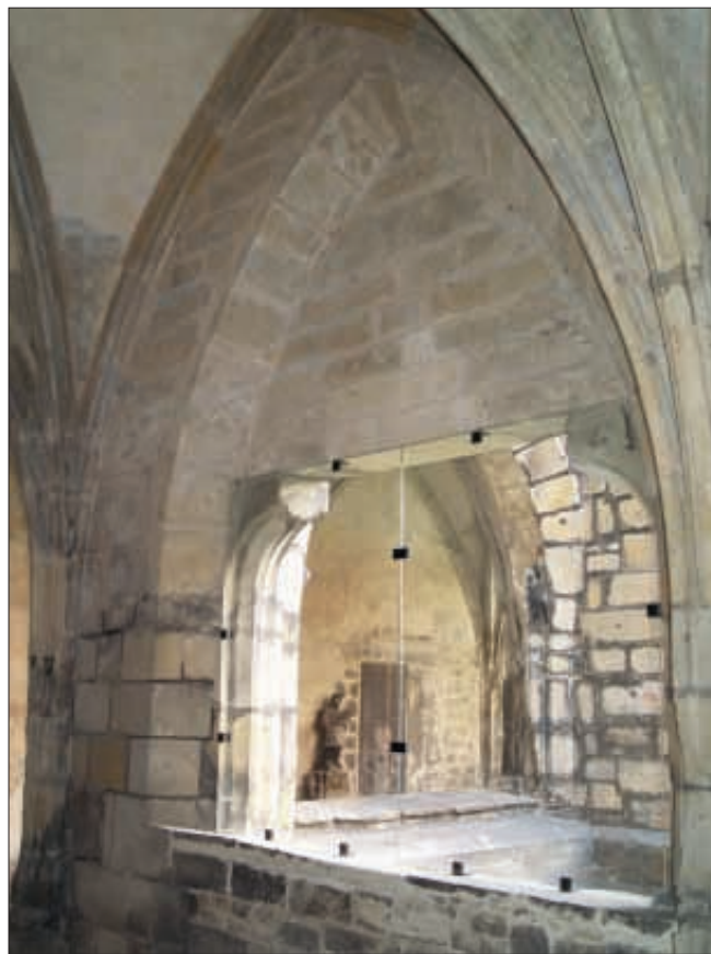
Obr. 18: Roudnice nad Labem (okres Litoměřice), bývalý klášter augustiniánů kanovníků. Dvorní arkáda východního ramene ambitu. Stav 2012.
