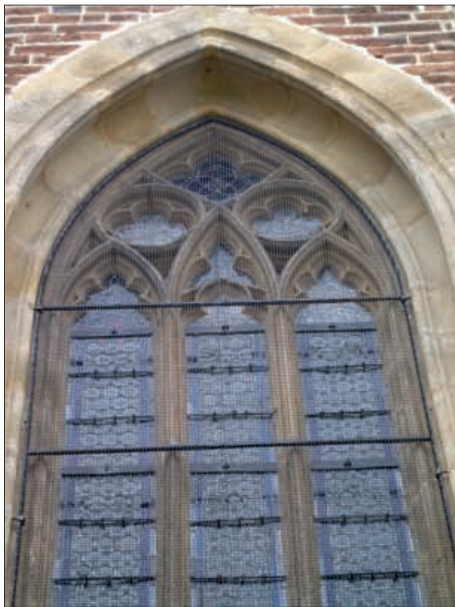
Obr. 22: Čechovice, kostel sv. Mikuláše, okno v ose prestáře. Stav 2012.
