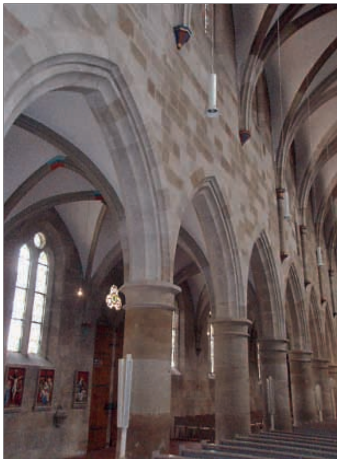
Obr. 7: Esslingen (Německo), dominikánský klášterní kostel. Pohled do basilikálního trojlodí. Stav 2008 (snímky P. Kroupa, není-li uvedeno jinak).
