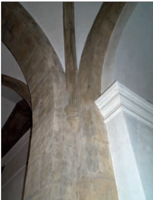
Obr. 15: Praha, kostel sv. Haštala. Jižní boční loď. Stav 2011.
