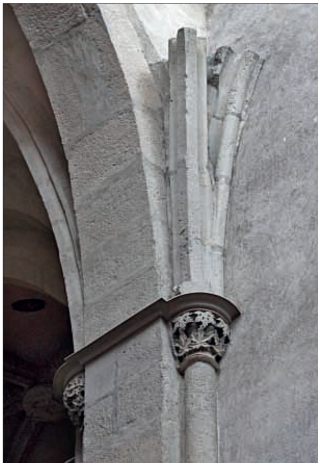
Obr. 8: Kolín, kostel sv. Bartoloměje. Detail zakončení přípory v severozápadním koutu raně gotického hlavního chóru. Na hlavici nasedají výběhy žebíř nedochované klenby. Patu vítězného oblouku přetíná římsa, která je ve stávající podobě výsledkem rekonstrukce z 1. desetiletí 20. století (foto J. Beránek, 2012).
