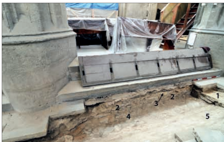
Obr. 14: Kolín, kostel sv. Bartoloměje. Sonda I od severovýchodu: 1 – zdivo severního raně gotického bočního chóru; 2 – zdivo hlavního raně gotického chóru; 3 – souvislá vrstva malty asi z doby vrcholné gotické přestavby; 4 – barokní lomové zdivo krypty; 5 – rub cihelné valené klenby krypty (foto Z. Neustupný, 2010).
