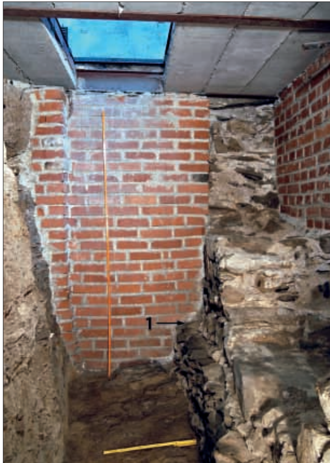
Obr. 32: Kolín, kostel sv. Bartoloměje. Severní konec výkopu z roku 1965 od jihu, vpravo zdivo východního boku hlavního raně gotického chóru: 1 – rozhraní lícovaného a nelícovaného zdiva (foto J. Beránek, 2012).
