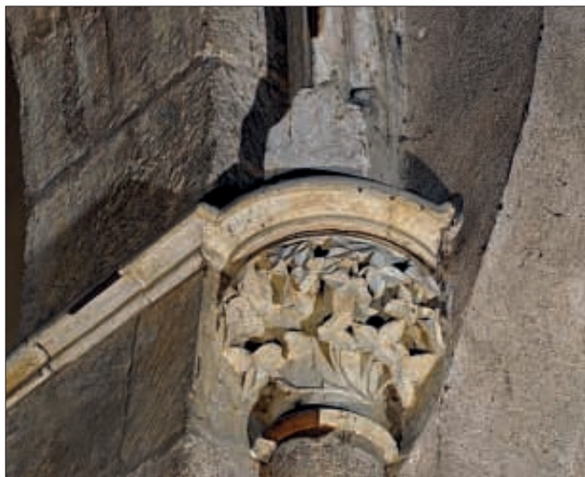
Obr. 12: Kolín, kostel sv. Bartoloměje. Hlavice přípory v severozápadním koutu zrušeného severního bočního chóru, krycí deska je novodobá (foto J. Beránek, 2012).
