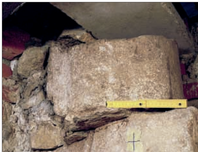
Obr. 34: Kolín, kostel sv. Bartoloměje. Torzo patky klenební přípory, srov. obr. 33 (foto J. Beránek, 2012).
