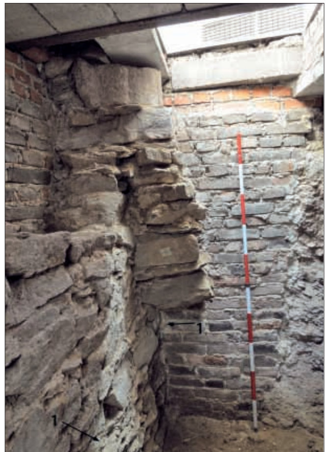
Obr. 33: Kolín, kostel sv. Bartoloměje. Jižní konec výkopu z roku 1965 od severu, vlevo zdivo východního boku hlavního raně gotického chóru, pod betonovým stropem patka klenební přípoje s předstupujícím základem: 1 – rozhraní lícovaného a nelícovaného zdiva (foto Z. Neustupný, 2012).
