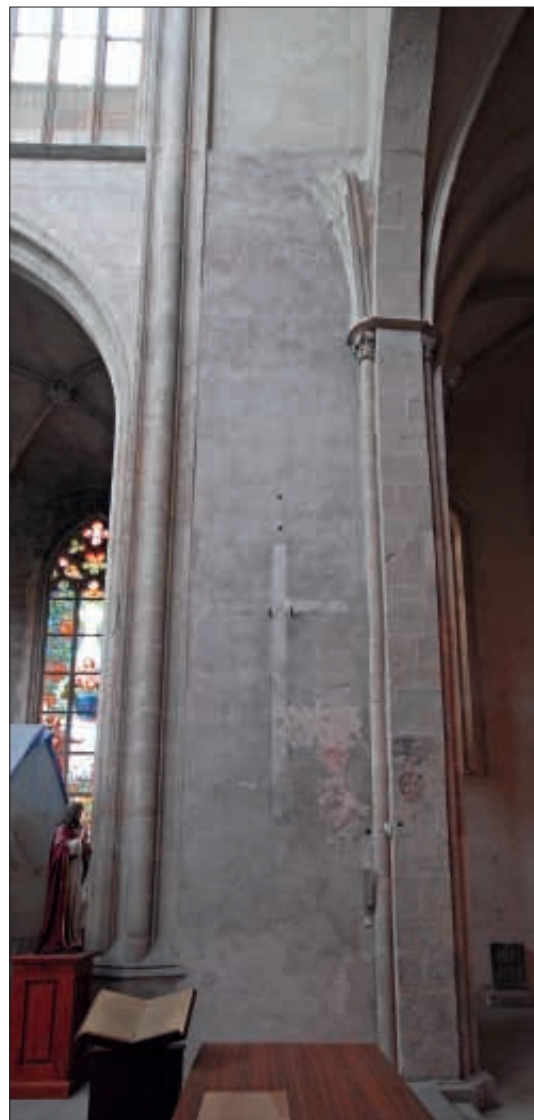
Obr. 7: Kolín, kostel sv. Bartoloměje. Pohled na západní část jižní stěny vysokého chóru. Z původního raně gotického hlavního chóru se dochoval jen úzký pás zdiva podél koutové příčiny s výběhy žeber (stavební rozhraní zvyrazňuje vodorovný ústupek). Ve spodní části stěny se dochovala původní omítka s fragmenty raně gotické výmalby, odhalené restaurátorskými sondami (foto J. Beránek, 2012).
