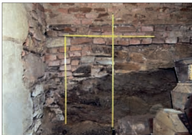
Obr. 42: Kolín, kostel sv. Bartoloměje. Jihovýchodní kout tzv. obecní hrobky od severu, na skále založené lomové zdivo patří k severnímu boku zrušeného hlavního raně gotického chóru (foto J. Beránek, 2011).
