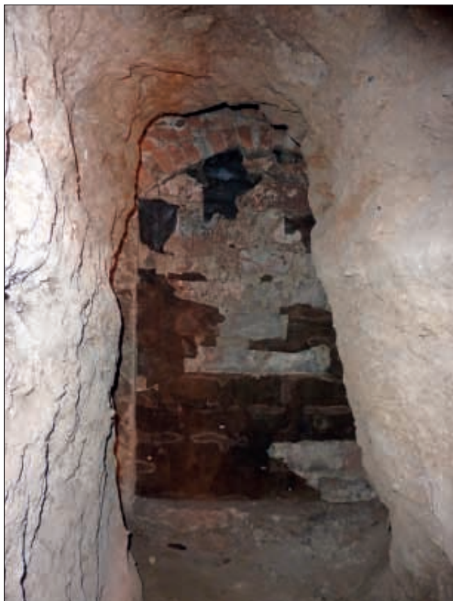
Obr. 37: Kolín, kostel sv. Bartoloměje. Výkop z roku 1960 od východu, v pozadí zazděný vstup do tzv. velké krypty (foto J. Beránek, 2012).
