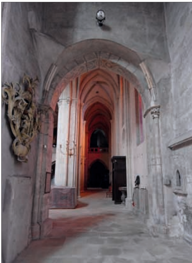
Obr. 10: Kolín, kostel sv. Bartoloměje. Pohled od východu na vítězný oblouk a zbytky klenby severního bočního chóru raně gotické etapy, nyní v severozápadní části chórového ochozu. Navazující část jižní zdi chóru (vlevo) je raně gotická, severní zeď (vpravo) patří k parléřovské přestavbě (foto J. Beránek, 2012).
