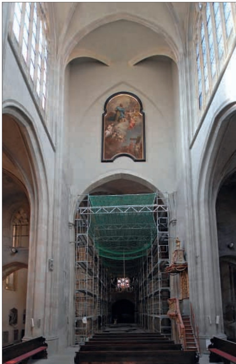
Obr. 6: Kolín, kostel sv. Bartoloměje. Pohled do vysokého chóru od východu. Parléřovská část stavby je zde uzavřena zdi nad raně gotickým vítězným obloukem. Při rekonstrukci chrámu na počátku 20. století bylo zdivo nad vítězným obloukem sneseno a znovu doplněno (foto J. Beránek, 2008).
