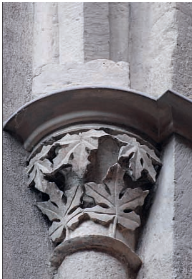
Obr. 9: Kolín, kostel sv. Bartoloměje. Detail hlavice jihozápadní koutové přípory raně gotického hlavního chóru. Krycí deska je novodobá, patrně ale odpovídá původnímu tvaru (foto J. Beránek, 2012).
