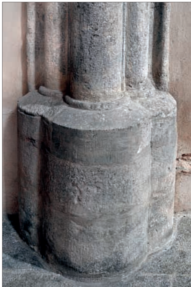
Obr. 35: Kolín, kostel sv. Bartoloměje. Patka svazkové klenební přípory na severní stěně trojlodí. Obdobnou podobu měla původně i přípora na závěrové stěně hlavního chóru, celkově však byla o něco menší (foto J. Beránek, 2012).
