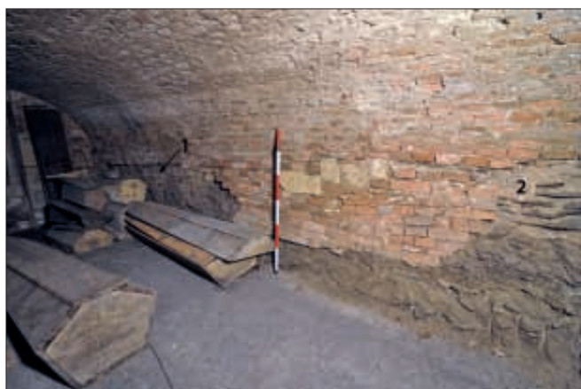
Obr. 41: Kolín, kostel sv. Bartoloměje. Jižní strana tzv. obecní hrobky od severozápadu: 1 – základové zdivo severního boku hlavního raně gotického chóru; 2 – lomové zdivo nejasného stáří (foto Z. Neustupný, 2011).
