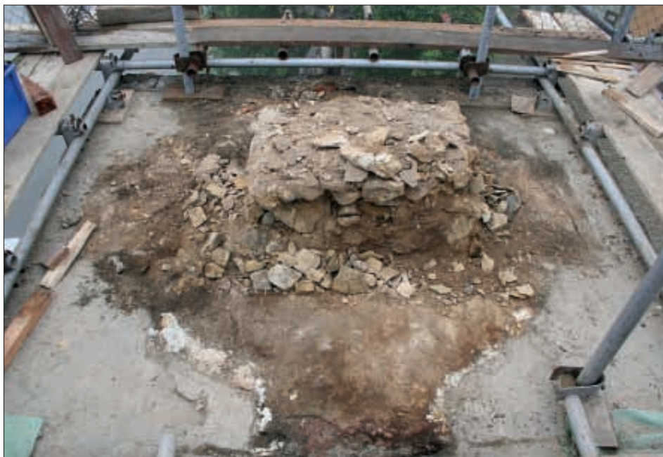
Obr. 15: Praha, Karlův most, sousoší sv. Vincence Ferrerského a sv. Prokopa, pohled na vyzdívkou nahrazující střední část patky soklu (foto J. Kačer, 2012).
