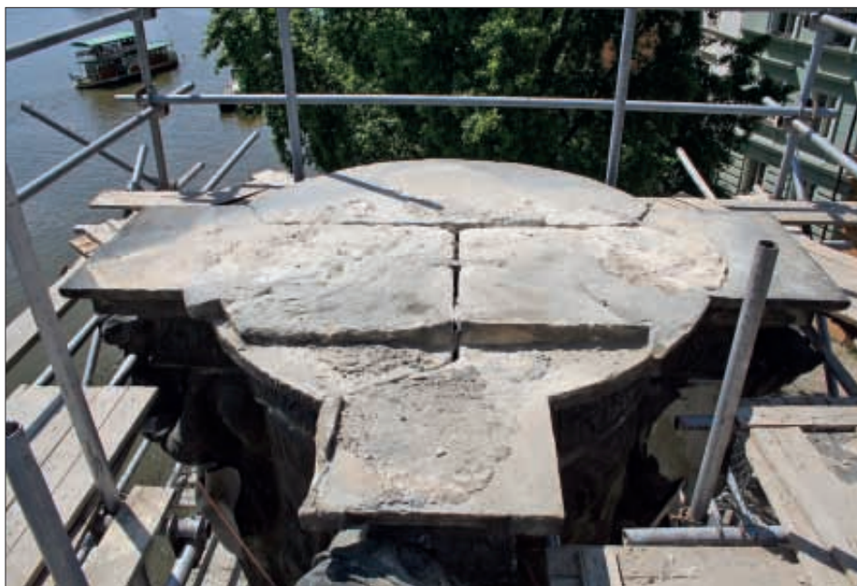
Obr. 11: Praha, Karlův most, sousoší sv. Vincence Ferrerského a sv. Prokopa, pohled na římsu soklu po sejmutí figur sousoší, detail mělké kapsy na čelní straně pro osazení skupiny Kajičníka, Uzdraveného nemocného a putto s votivním nápisem (foto J. Kačer 2012).
