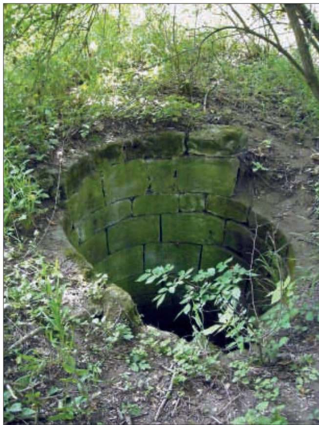
Obr. 10: Veltrusy, současný stav studně na hrázi tzv. Oválu (foto P. Načeradská, 2012).
