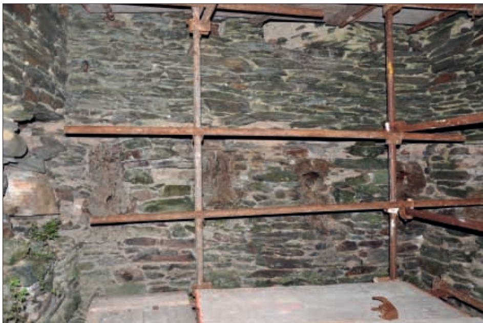
Obr. 19: Pozůstatky dřevěného roštu nad 2. patrem věže, celkový pohled na východní stěnu (snímek autor, 2011).
