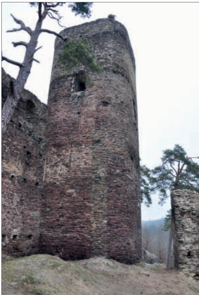
Obr. 6: Věž od jihozápadu, s druhotně vylámaným vstupem na západní straně (snímek autor, 2012).
