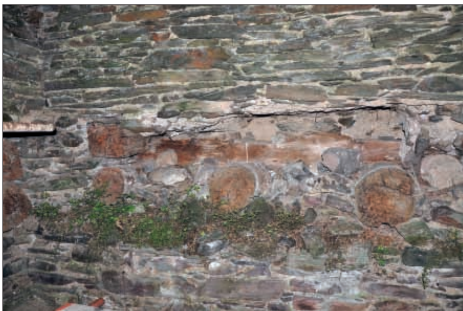
Obr. 20: Pozůstatky dřevěného roštu nad 2. patrem věže, částečný pohled na severní stěnu (snímek autor, 2011).
