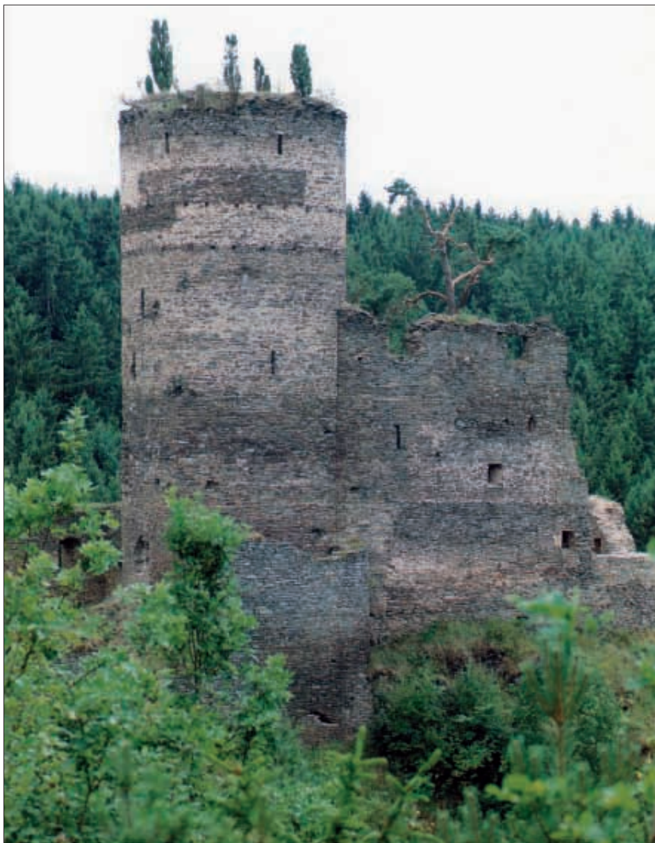
Obr. 5: Věž od severovýchodu. Dobře je patrný dodatečný vznik dvou posledních pater, se čtyřmi vodorovnými řadami dřevěných nosníků lešení (snímek z archivu NPÚ – ÚOP v Plzni, J. Gryc, asi 2002).
