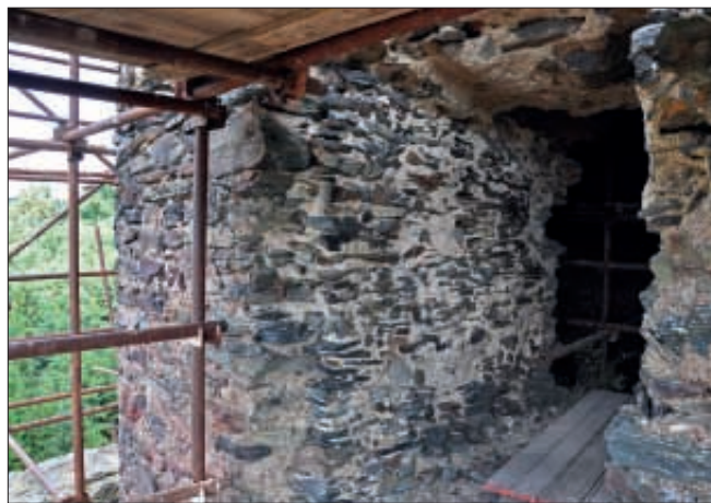
Obr. 11: Druhotně vylámaný vchod do věže od západu (srov. obr. 6). Pohled z exteriéru na severní stěnu vchodu, na hraně stopy zaniklé dřevěné zárubně dveří. V nadpraží průchodu otisk nosíku lešení (snímek autor, 2011).
