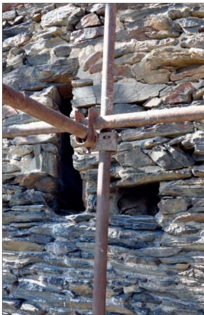
Obr. 12: Detail východního střílnového otvoru předposledního patra. Dolní část otvoru nese stopy druhotné úpravy (cihla na výšku uvnitř otvoru vpravo), upravo od otvoru silnější dřevěný nosník lešení, procházející celou masou zdiva (srov. obr. 24, zcela vlevo; snímek autor, 2011).
