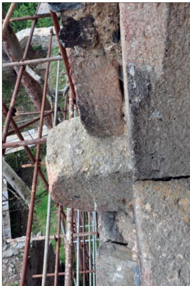
Obr. 17: Vstup do 2. patra věže v pohledu z interiéru (srov. obr. 15). Detail západní stojky portálku a prahu (vpravo), uprostřed konzola pro padací můstek, která však nevykazuje stopy jeho upevnění (snímek autor, 2011).
