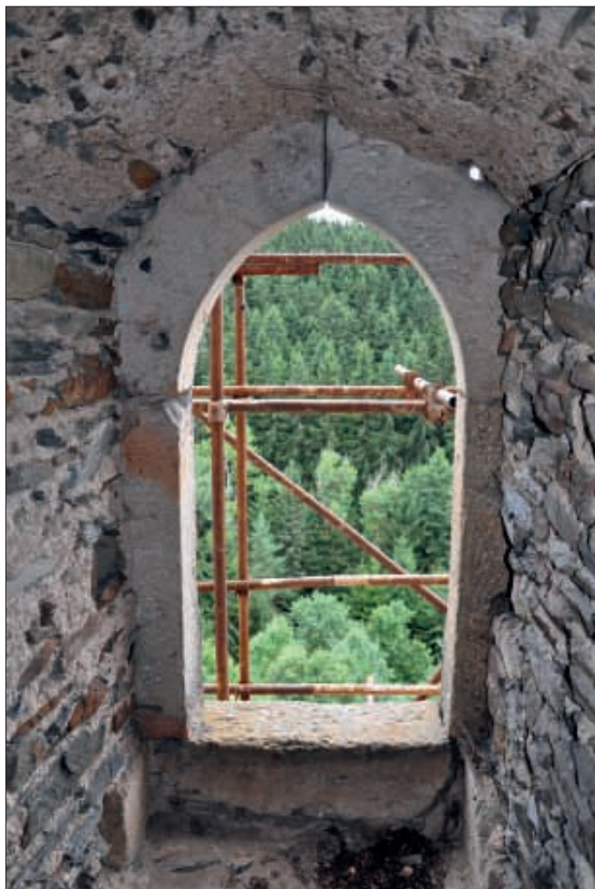
Obr. 15: Vstup do 2. patra věže v pohledu z interiéru (srov. obr. 10). Po stranách portálku jsou kapsy zasouvací závory, vpravo nahoře nad ostěním otvor určený k protahování provazu padacího můstku. Na levé straně ostění stopy upevnění dveří (snímek autor, 2011).
