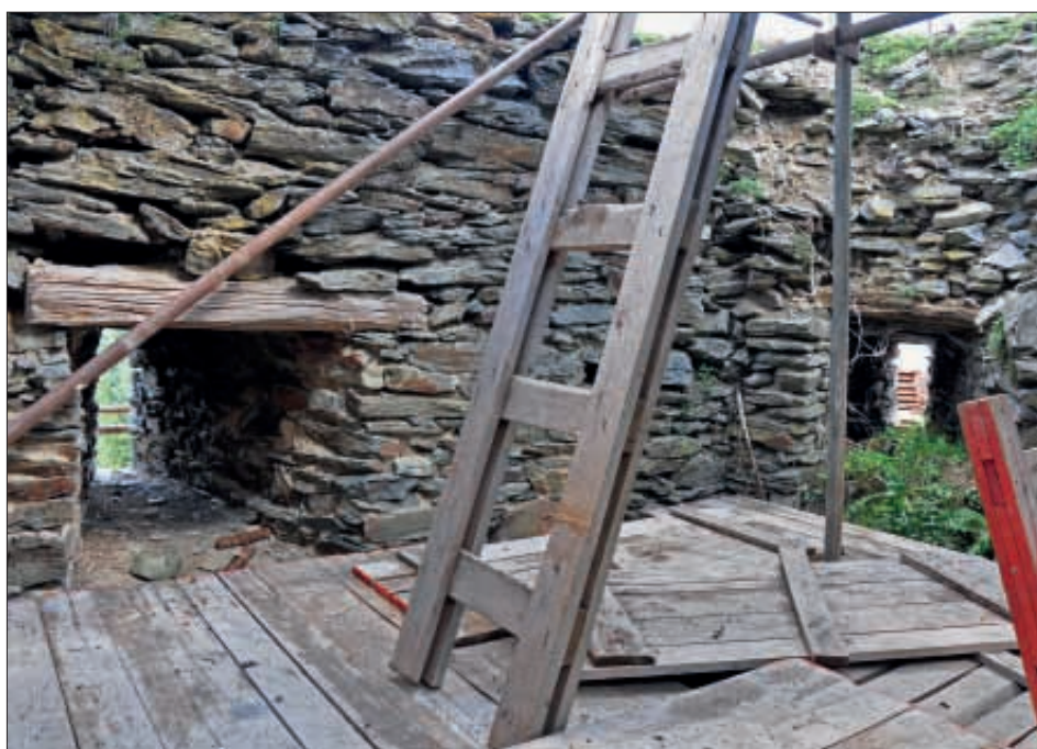
Obr. 26: Interiér 4. patra věže, pohled k severovýchodnímu koutu, se dvěma střílnovými otvory (snímek autor, 2011).
