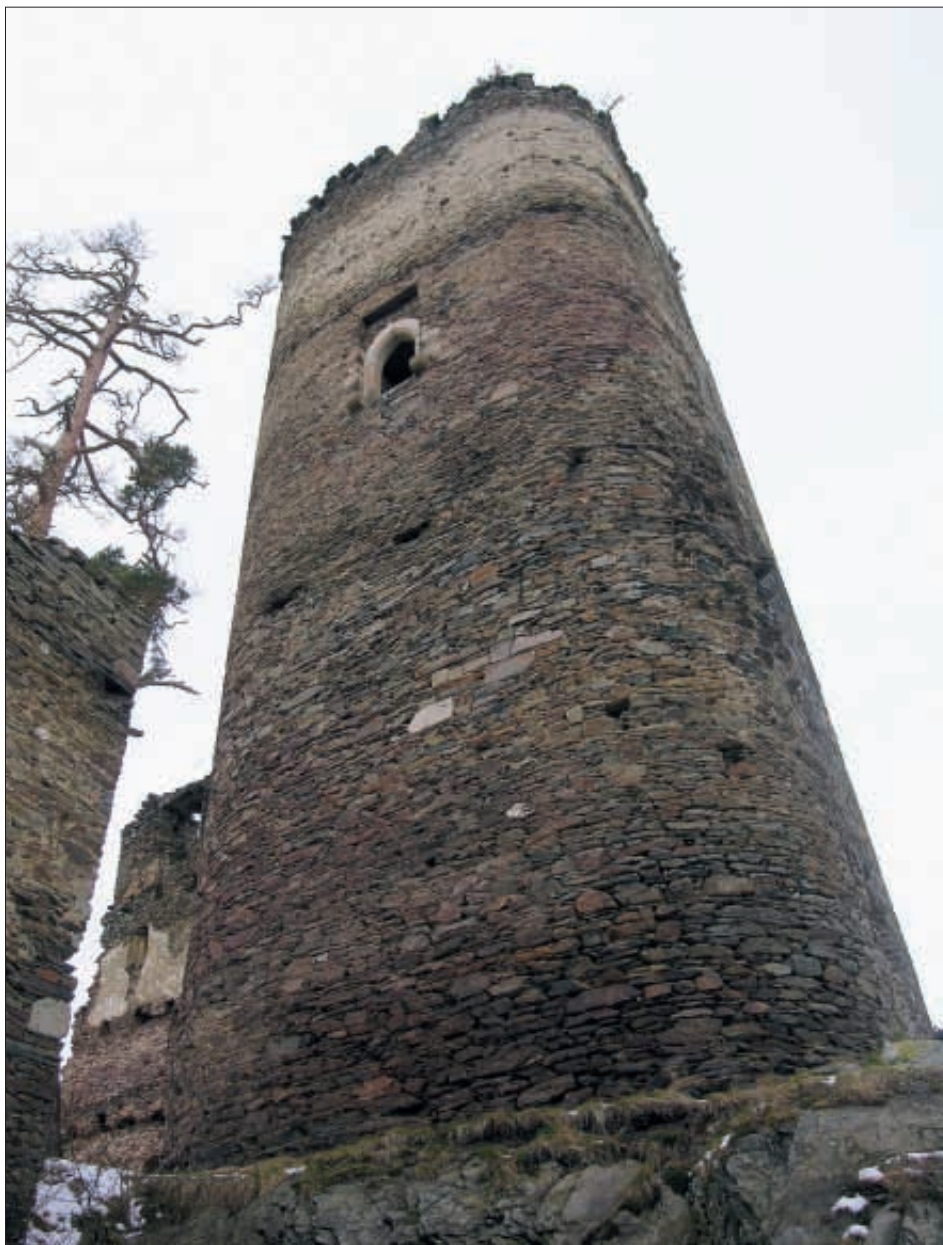
Obr. 7: Jižní průčelí věže s druhotně použitými kamenickými prvky na rozhraní přízemí a 1. patra a se vstupem do 2. patra (snímek autor, 2008).
