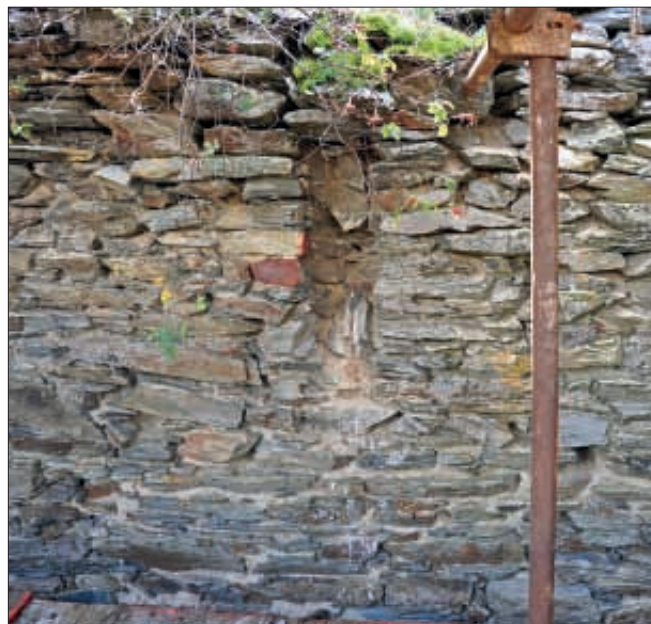
Obr. 27: Interiér 4. patra věže, detailní pohled na negativ svislého prvku v jižní stěně (snímek autor, 2011).
