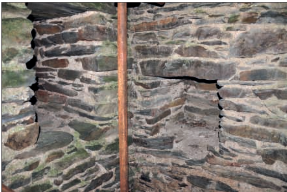
Obr. 14: Střílnový otvor (vlevo) a odkládací výklenek v 1. patře věže (srov. obr. 13, snímek autor, 2011).
