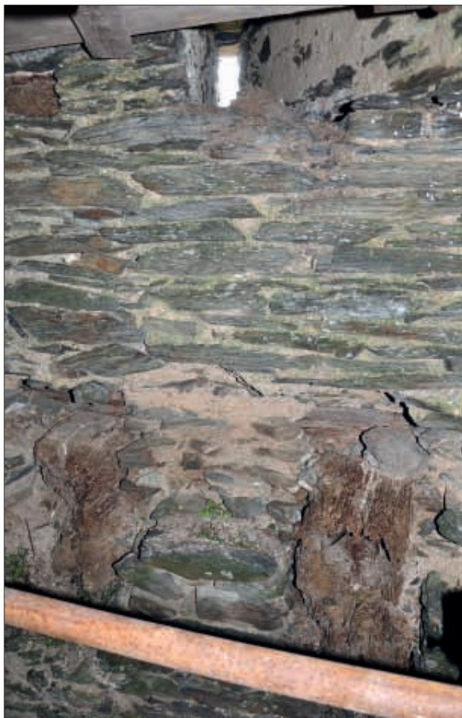
Obr. 24: Interiér 3. patra věže, detail východní stěny. Dole relikv dřevěného roštu, nahoře spodní část střílnového otvoru, vlevo od něj silnější nosník lešení, procházející celou tloušťkou zdi (srov. obr. 18, řez D-D', a obr. 12; snímek autor, 2011).
