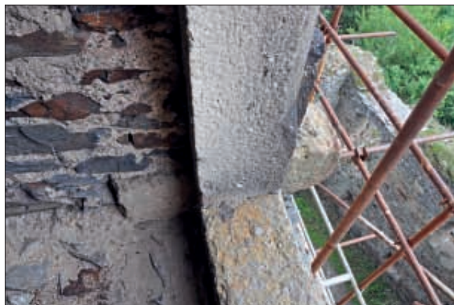
Obr. 16: Vstup do 2. patra věže v pohledu z interiéru (srov. obr. 15). Detail východní stojky portálku, prahu a konzoly pro padací můstek. Konzola je zasazena hluboko ve zdivu (vlevo) a na svém povrchu (vpravo) nevykazuje stopy upevnění můstku (snímek autor, 2011).
