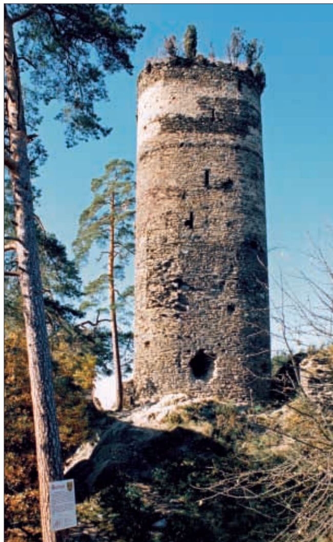
Obr. 4: Věž od východu, s dobře patrnou návazností zaniklé hradby na jihovýchodní zaoblené nároží (snímek z archivu NPÚ – ÚOP v Plzni, J. Gryc, asi 2002).
