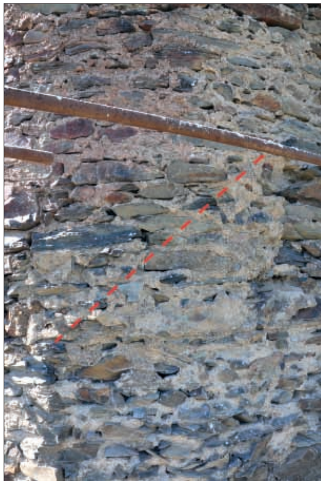
Obr. 9: Detail místa návaznosti koruny zaniklé hradby na jihovýchodním nároží věže (srov. obr. 8). Přerušovanou čarou naznačen průběh stříšky hradby (snímek autor, 2011).
