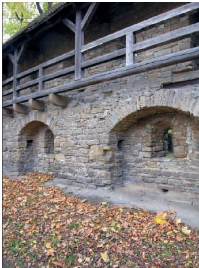
Obr. 28: Zeitz (Sasko-Anhaltsko), část pozdně gotické městské hradby se střílnovými výklenky, po jejichž stranách jsou drobné odkládací niky, podobné nice v 1. patře gutštejnské věže (snímek autor, 2006).
