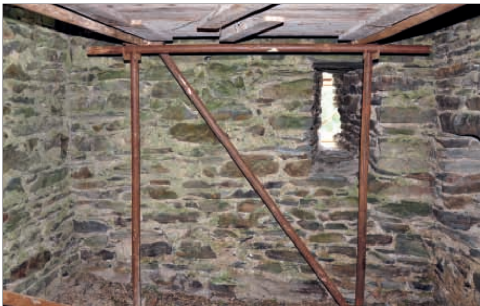
Obr. 13: Interiér 1. patra věže, pohled k východu. Asymetricky umístěný střílnový otvor (s druhotně rozšířenou spodní částí vnějšího ústí, srov. též obr. 4 a 8), zcela vpravo odkládací výklenek (snímek autor, 2011).
