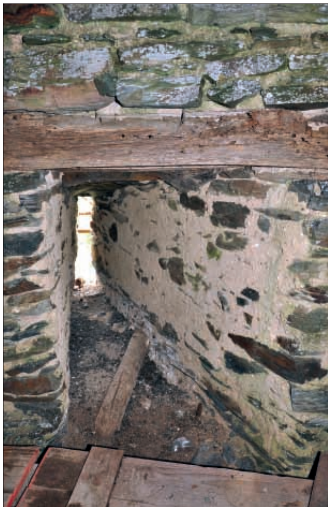
Obr. 25: Interiér 3. patra věže, střílnový otvor ve východní zdi (srov. obr. 12 a 24). Těsně nad parapetem probíhá kulatina jednoho z nosníků lešení (snímek autor, 2011).
