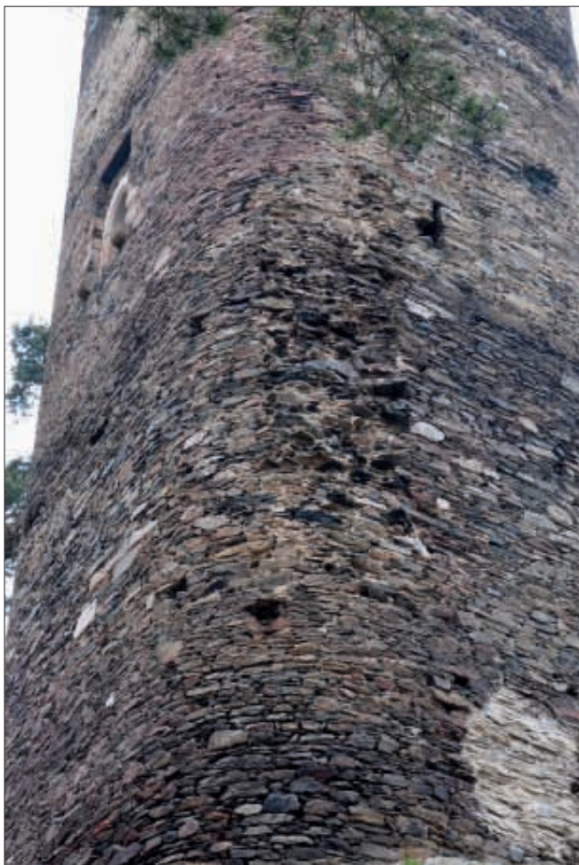
Obr. 8: Detail jihovýchodního zaobleného nároží věže se stopami návaznosti zaniklé hradby (snímek autor, 2012).
