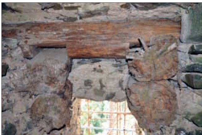
Obr. 23: Pozůstatky dřevěného roštu nad 2. patrem věže, částečný pohled na západní stěnu s druhotným vstupem (snímek autor, 2011).
