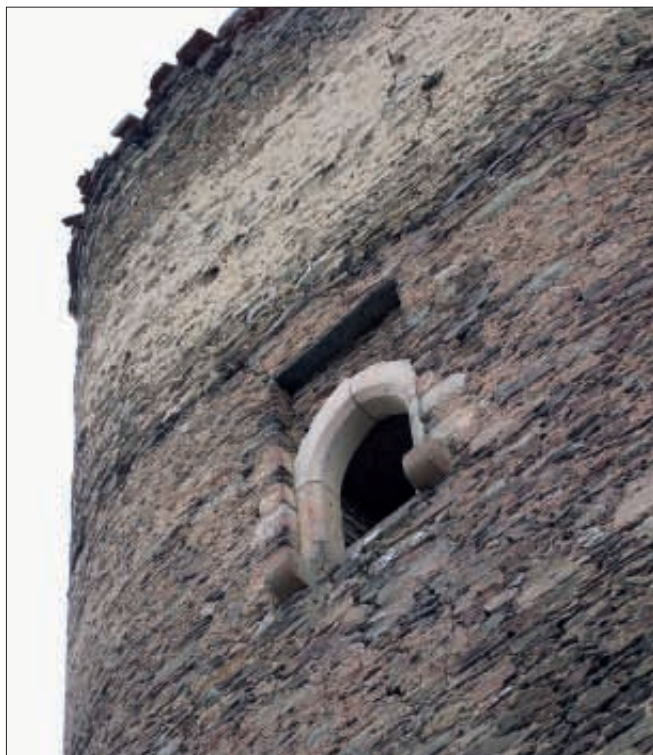
Obr. 10: Detail původního vstupu do 2. patra věže (srov. obr. 7 a 8). Překlad upadliny pro padací můstek je tvořen jedním kusem štípané břidlicové desky (snímek autor, 2008).
