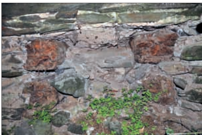
Obr. 22: Pozůstatky dřevěného roštu nad 2. patrem věže, detailní pohled na část jižní stěny (snímek autor, 2011).
