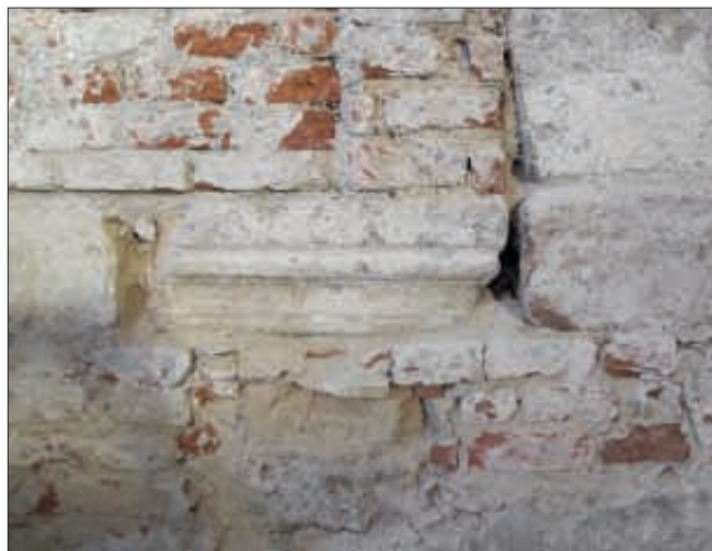
Obr. 10: Svojšín, kostel sv. Petra a Pavla, profilovaná krycí deska hlavice (?) druhotně užitá v barokní zdi oddělující presbyterium od severní sakristie (foto M. Hauserová).
