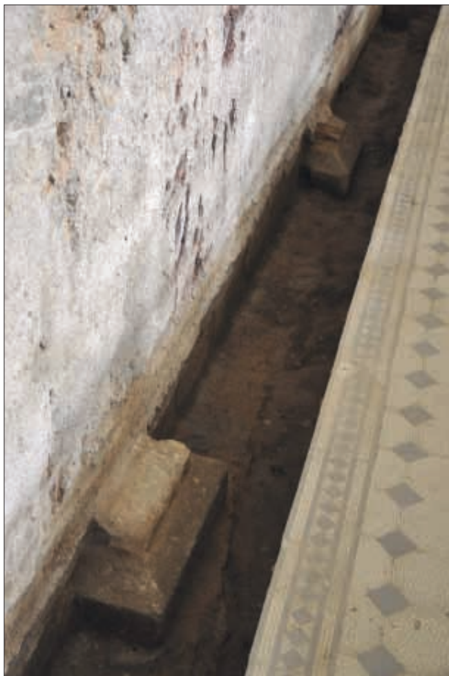
Obr. 7: Svojšín, kostel sv. Petra a Pavla, pohled podél severní zdi lodi směrem k východu. V popředí ve výkopu patka přízedního pilastru, na jehož hlavici dosedl oblouk arkády tribuny. Vzdálenější patka náležela pilastru, který členil severní stěnu lodi na dvě poloviny (foto J. Sommer).
