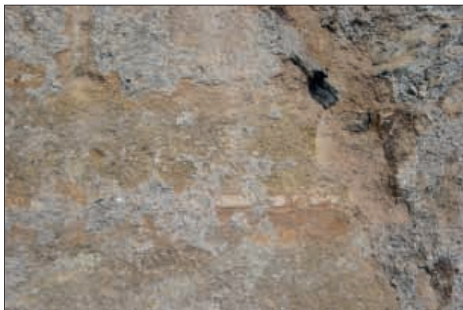
Obr. 8: Svojšín, kostel sv. Petra a Pavla, pozůstatky mladší úpravy kvádrového zdíva vystouplým spárováním (foto J. Anderle).
