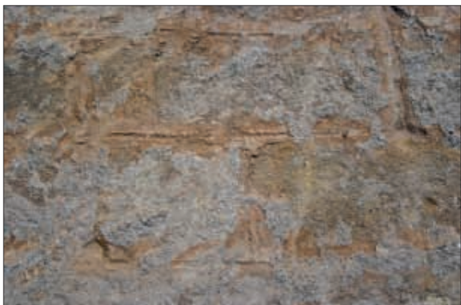
Obr. 6: Svojšín, kostel sv. Petra a Pavla, románský kvádrový interiérový líc severní zdi lodi s podřezávanými sparami (foto J. Anderle).
