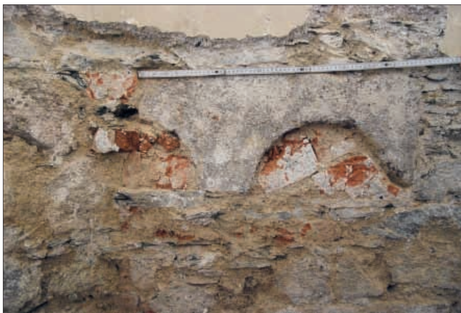
Obr. 9: Svojšín, kostel sv. Petra a Pavla, článek obloučkového podřímsí druhotně užitý v obvodovém zdivu barokního presbyteria (foto M. Falta).
