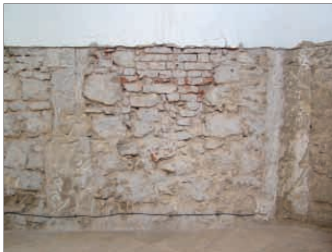
Obr. 21: Kurdějov, kostel sv. Jana Křtitele. Severní strana presbytáře, zdi zdivka sanktuária a druhotně osekané klenební přípory.
