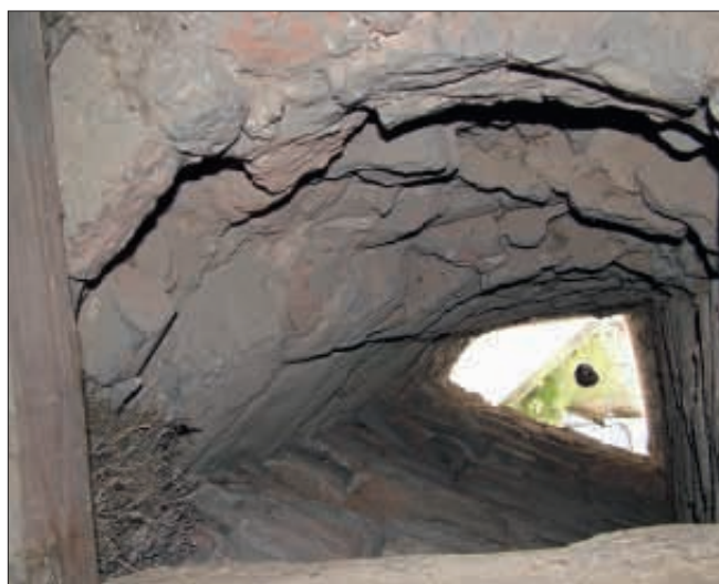
Obr. 27: Kurdějov, kostel sv. Jana Křtitele. Pohled na zdivo polygonu (převětu?) vezděného mezi západní zeď příčné lodi a severní zeď lodi.
