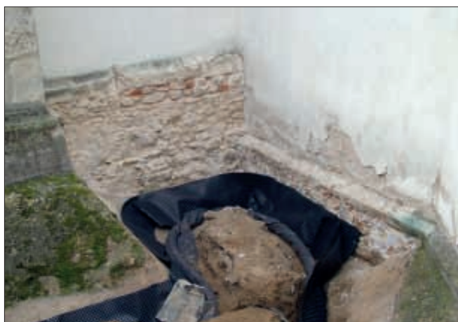
Obr. 20: Kurdějov, kostel sv. Jana Křtitele. Západní část severní zdi presbytáře (nalevo) a východní zeď severní příčné lodi (napravo), patrný výškový rozdíl v úrovni římsy soklu.
