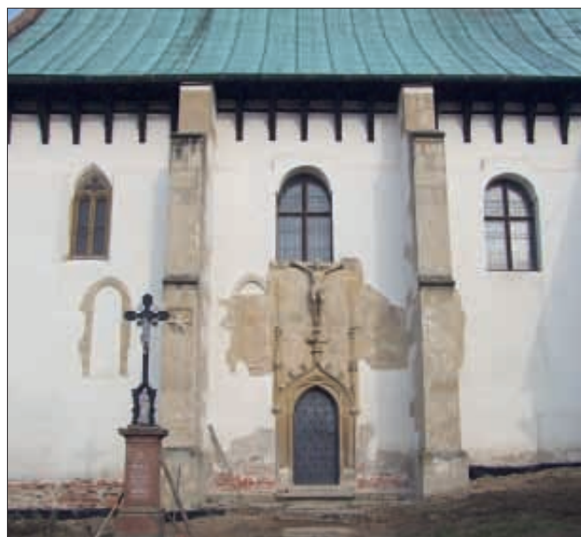
Obr. 14: Kurdějov, kostel sv. Jana Křtitele. Jižní strana lodi kostela se vstupním portálem a zazděnými okny z první fáze výstavby kostela.
