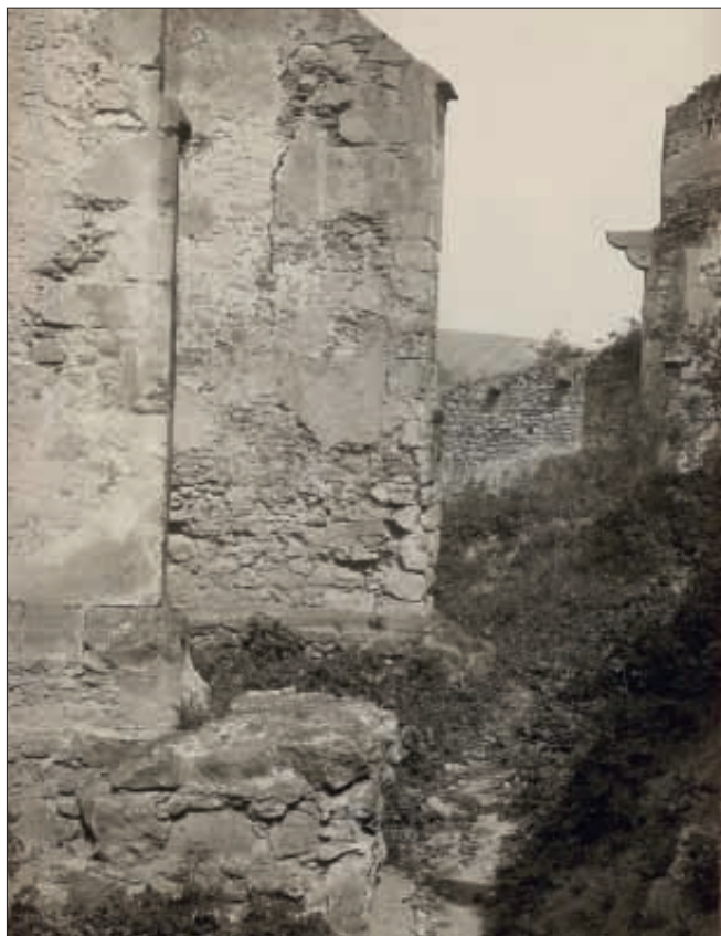
Obr. 4: Kurdějov, kostel sv. Jana Křtitele. Fotografie kostela před opravou v roce 1936, detail opěrného pilíře (uloženo NPÚ ÚOP v Brně, archiv staré fotodokumentace. Inv. č. 21. 653 M-9/442).
