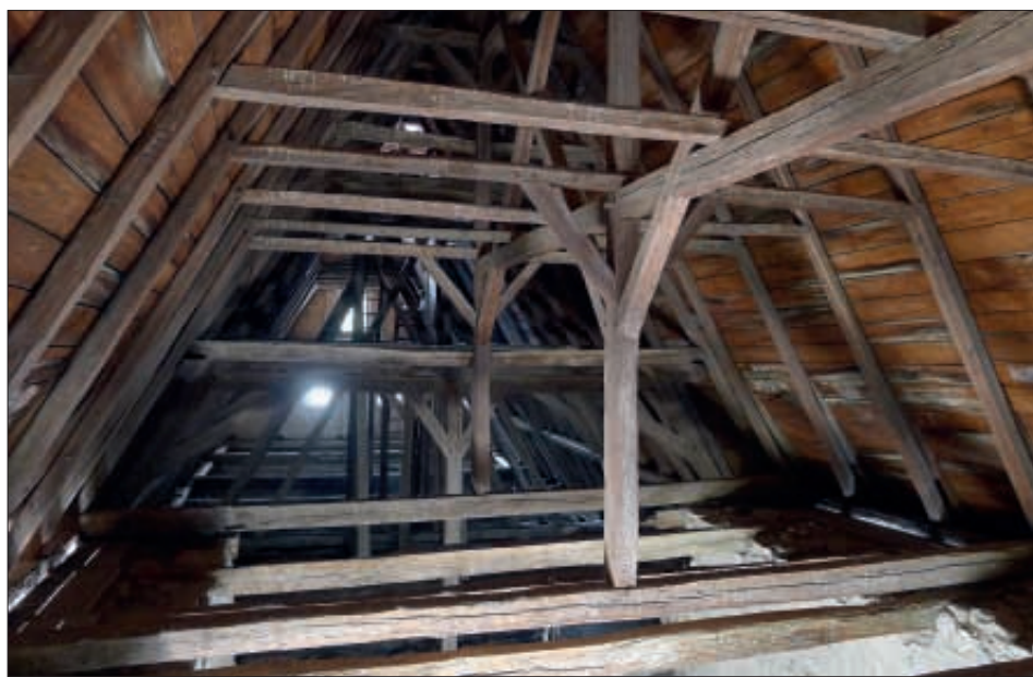
Obr. 29: Kurdějov, kostel sv. Jana Křtitele. Celkový pohled z krovu presbytáře směrem ke krovu lodi.
