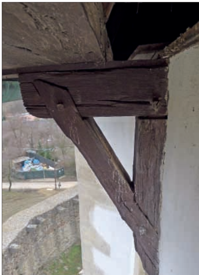
Obr. 25: Kurdějov, kostel sv. Jana Křtitele. Detail krakorce v ose presbytáře.
