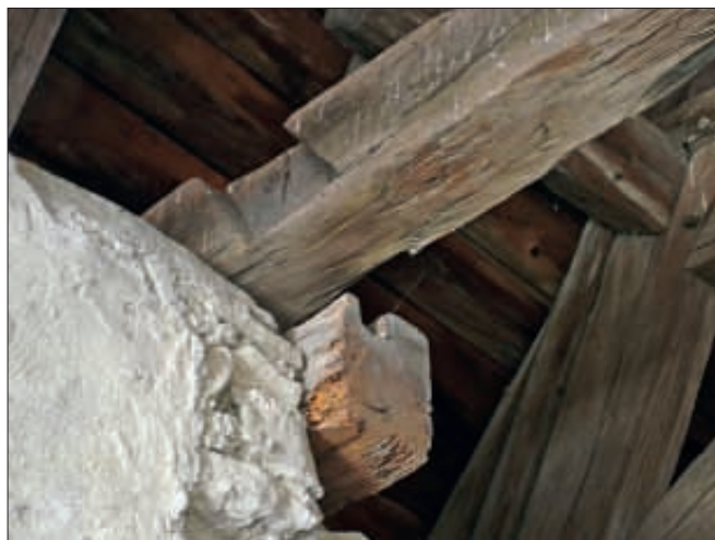
Obr. 24: Kurdějov, kostel sv. Jana Křtitele. Patro presbytáře, pohled na drážku ve vazném trámu staršího krovu presbytáře a dlabu ve vazném trámu západní vazby krovu.
