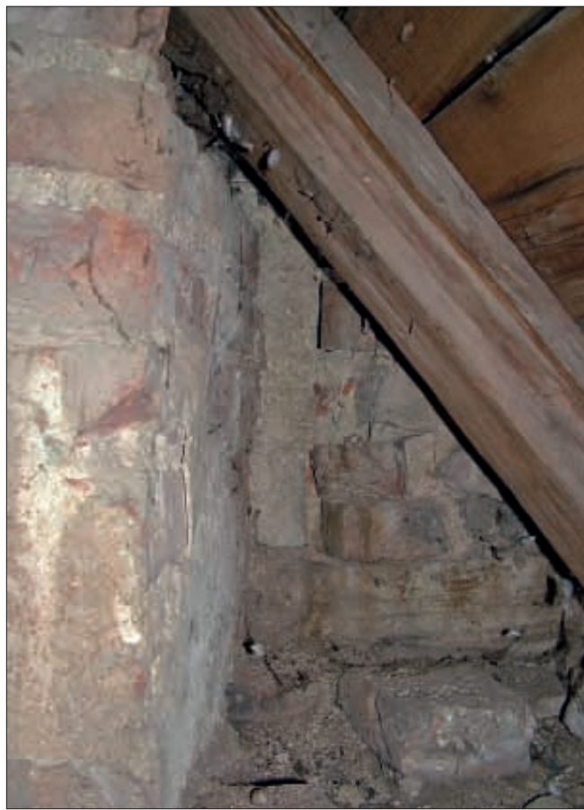
Obr. 26: Kurdějov, kostel sv. Jana Křtitele. Špaleta a ostění střílny, východní štít jižní části příčné lodi.
