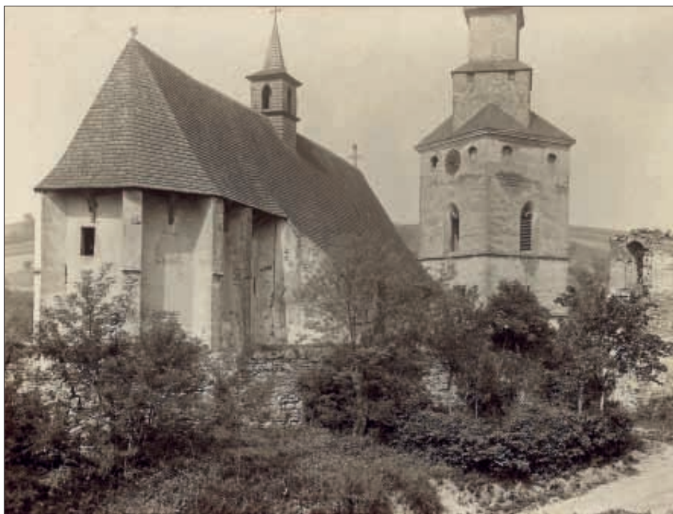
Obr. 3: Kurdějov, kostel sv. Jana Křtitele. Fotografie kostela před opravou v roce 1936, pohled od severovýchodu (uloženo NPÚ ÚOP v Brně, archiv staré fotodokumentace. Inv. č. 21. 650 M-9/439).
