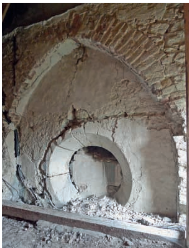
Obr. 22: Kurdějov, kostel sv. Jana Křtitele. Jižní zeď příčné lodi v úrovni patra nad sakristií členěná polem liché arkády s druhotně zazděnou rozetou.
