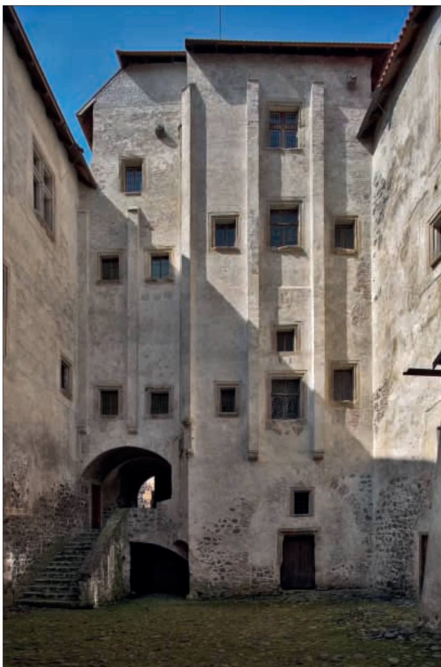
Obr. 1: Nádvoří na Švihově – vysoký kontrast světla a stínu, snímky tohoto druhu je možno realizovat jen s využitím fotografování do RAW formátu, případně za použití metody HDR (foto G. Čapková).
