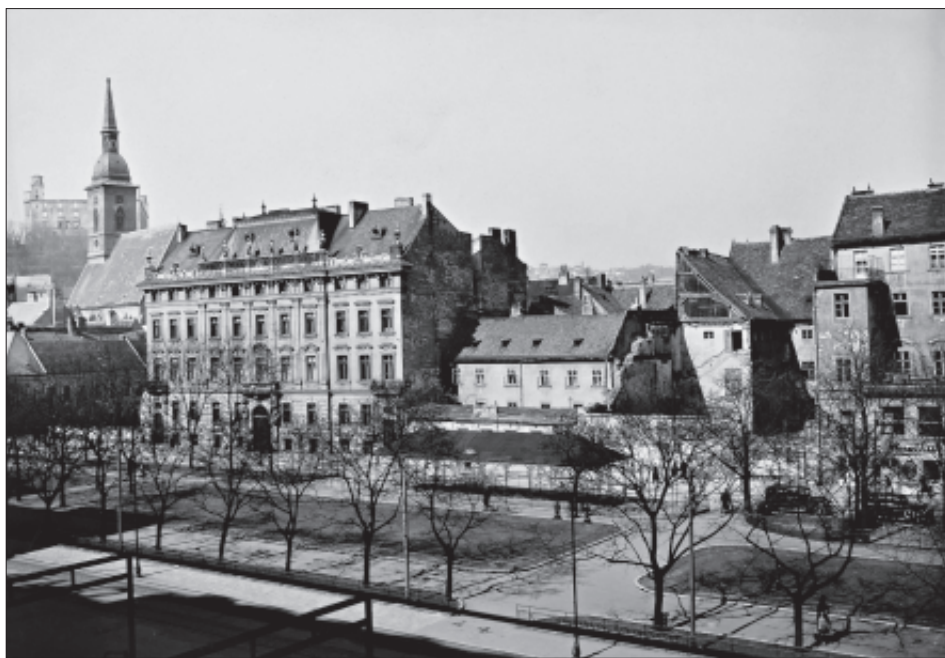
Obr. 45: Historický snímek zachycující bourání původního domu na Hviezdoslavově náměstí, na jehož místě byla postavena Lehmannova novostavba (Archiv Slovenského národního muzea v Bratislavě).
