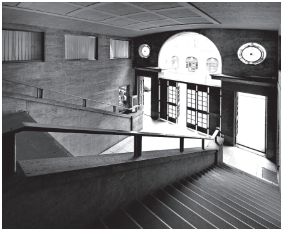
Obr. 34: Vstupní hala v paláci pojišťovny Viktoria s dvouramenným schodištěm (foto Wikipedie).
