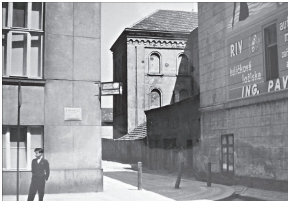
Obr. 38: Továrna Carl Breiding & Sohn, zbořená v souvislosti s výstavbou obytného bloku v ulicích U Nemocenské pojišťovny, Klimentská a Lannova (Městská část Praha 1, archiv stavebního úřadu, složka domu čp. 1229-II).
