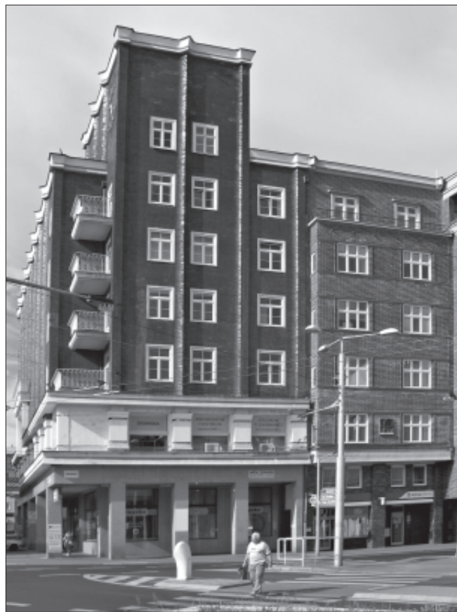
Obr. 15: Expozitura Riunione Adriatica di Sicurtà v Ústí nad Labem (foto autor, 2010).
