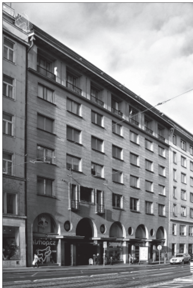
Obr. 33: Expozitura pojišťovny Viktoria v Praze, hlavní průčelí (foto autor, 2011).
