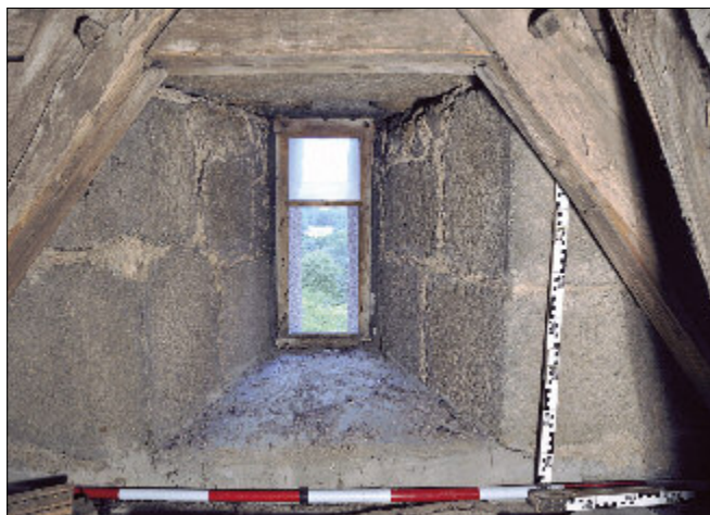
Obr. 24: Obděnice, kostel Nanebevzetí P. Marie. Okno v severní stěně 2. patra věže.
