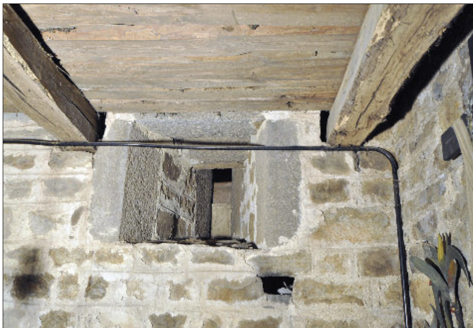
Obr. 21: Obděníce, kostel Nanebevzetí P. Marie. Okno v jižní stěně věže, současné stropní trámy jsou vloženy do negativů románských trámů.
