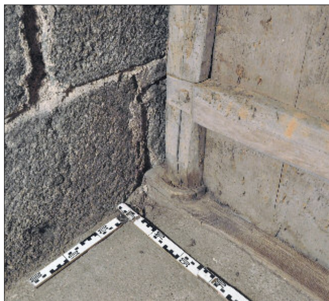
Obr. 20: Obděnice, kostel Nanebevzetí P. Marie. Detail spodního ložiska točnice dveří v průchodu mezi lodí a přízemím věže, srov. obr. 19.
