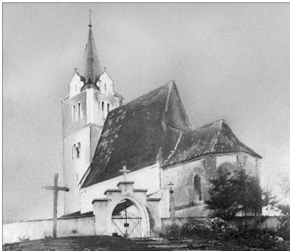
Obr. 1: Obděnice (okres Příbram), kostel Nanebevzetí P. Marie. Celkový pohled od jihovýchodu, zachycena je strmá střecha lodi, stržená v roce 1891 (foto cca 1890, Sběrka fotografické dokumentace NPÚ GnŘ, z pozůstalosti A. Podlahy).
