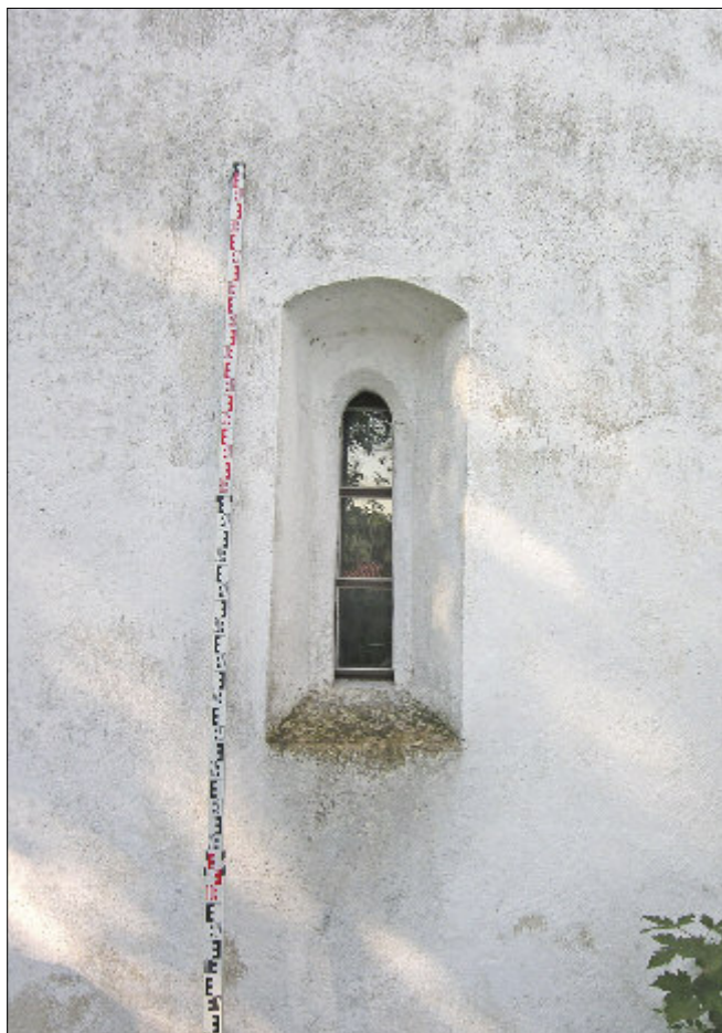
Obr. 16: Obděnice, kostel Nanebevzetí P. Marie. Okno ve východním boku sakristie.
