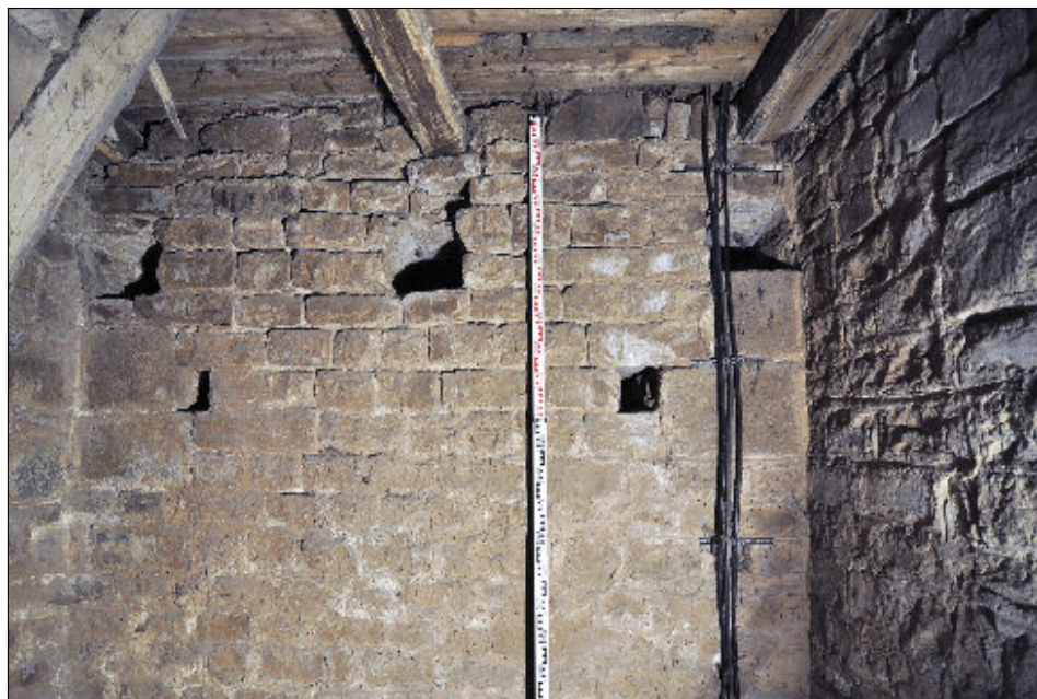
Obr. 23: Obděnice, kostel Nanebevzetí P. Marie. Detail severní stěny 1. patra věže, strop z desek z počátku 17. století je nesen třemi trámy 2. románské technologické etapy, pod nimi jsou tři větší kapsy/otisky zaniklých stropních trámů 1. románské technologické etapy, nejnižší dvě lešeňové kapsy.
