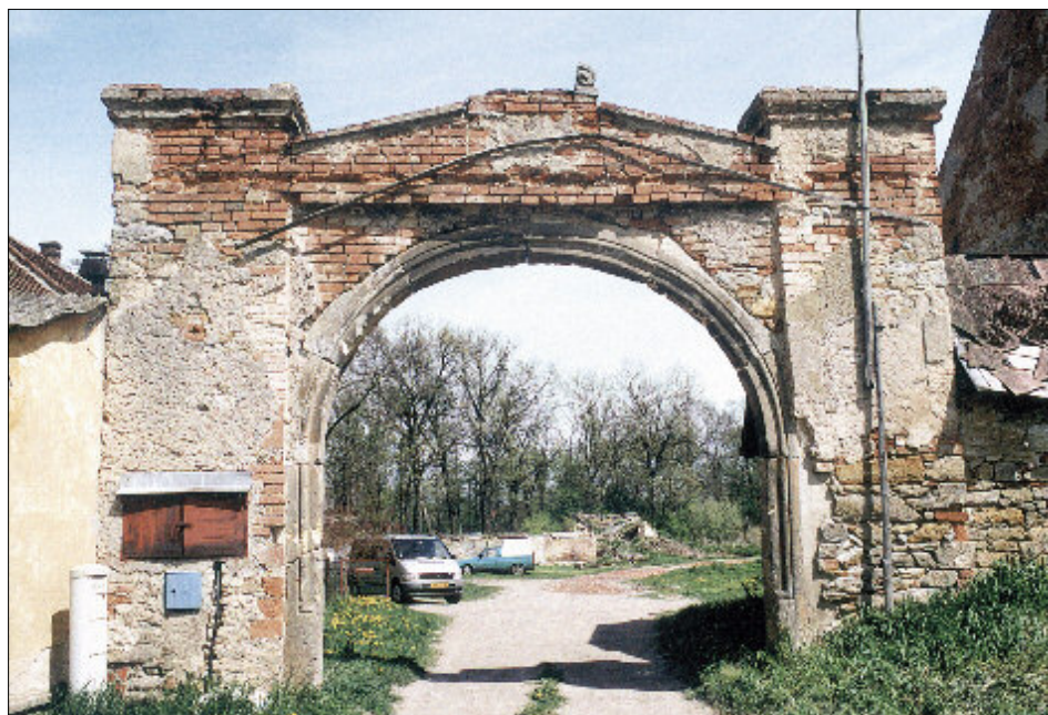
Obr. 3: Týnec (okres Nymburk) – brána dvora ze třetí čtvrtiny 19. století s rozšířeným a doplněným renesančním ostěním. Pravá stojka s navazujícím zdívem odpovídá poloze v původní renesanční bráně.
