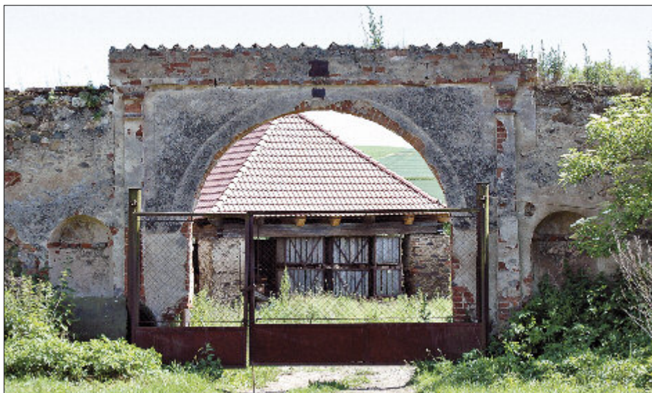
Obr. 1: Skalkov (okres Benešov) – pohled na renesanční bránu dvora z doby po roce 1600. Vjezd rámuje edikula s „vzábílými“ pilastry a dvojice konchovitých nik s dochovanou rytou a malovanou výzdobou. Na přilehlých úsecích ohradních zdí patrné zbytky sgrafita (všechny snímky autor, není-li uvedeno jinak).
