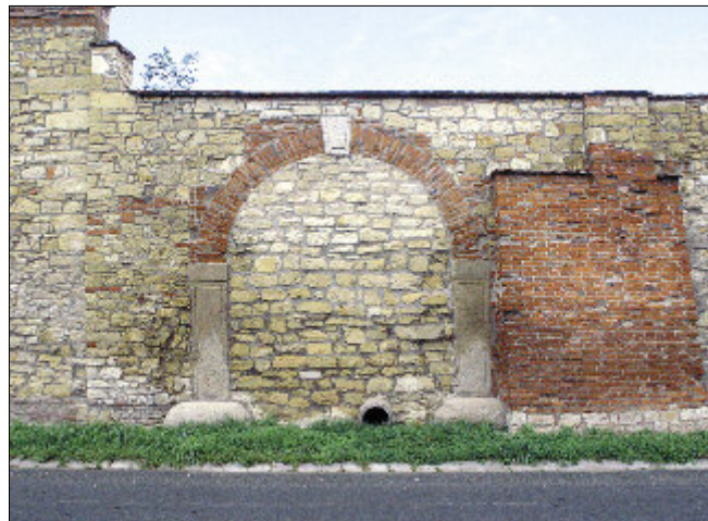
Obr. 11: Blážíim (okres Louny), bývalé panství Postoloprty – barokní zadděná brána s kamenným ostěním a cihelným záklenkem.
