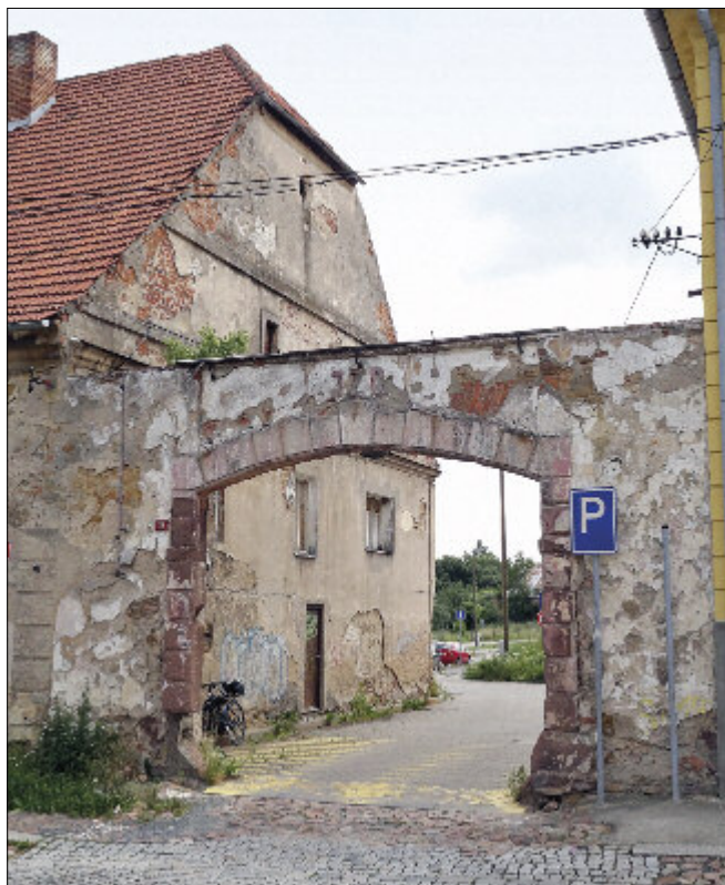
Obr. 4.: Kostelec nad Černými lesy (okres Kolín), bývalé panství Kostelec – brána dvora proti zámku z doby kolem roku 1870. Brána vznikla rozšířením renesanční brány, ze které využila stojky bosovaného ostění. Levá stojka je dosud na původním místě. Archivolta je vytvořena z omítkových klenáků imitujících červený pískovec (arkózu), ze které jsou vytesány renesanční prvky.
