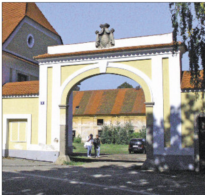
Obr. 31: Nový Dvůr v Třeboni, bývalé panství Třeboň – brána z přestavby dvora z doby po roce 1787.
