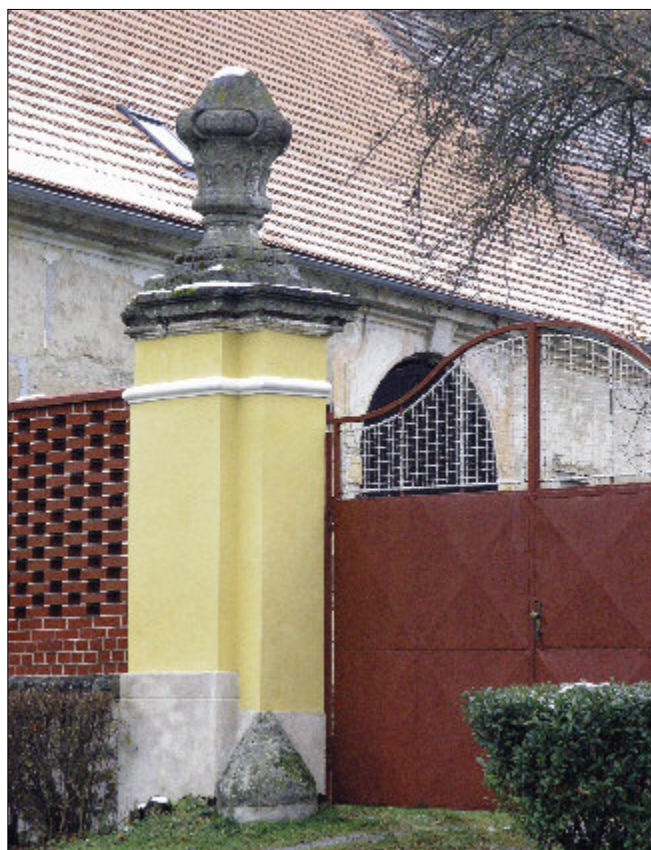
Obr. 23: Žinkovy (okres Plzeň-jih) – piliř brány s nákolníkem, zdobený vázou hospodářského dvora postaveného ve 40. letech 18. století na půdorysu rovnostranného trojúhelníka.
