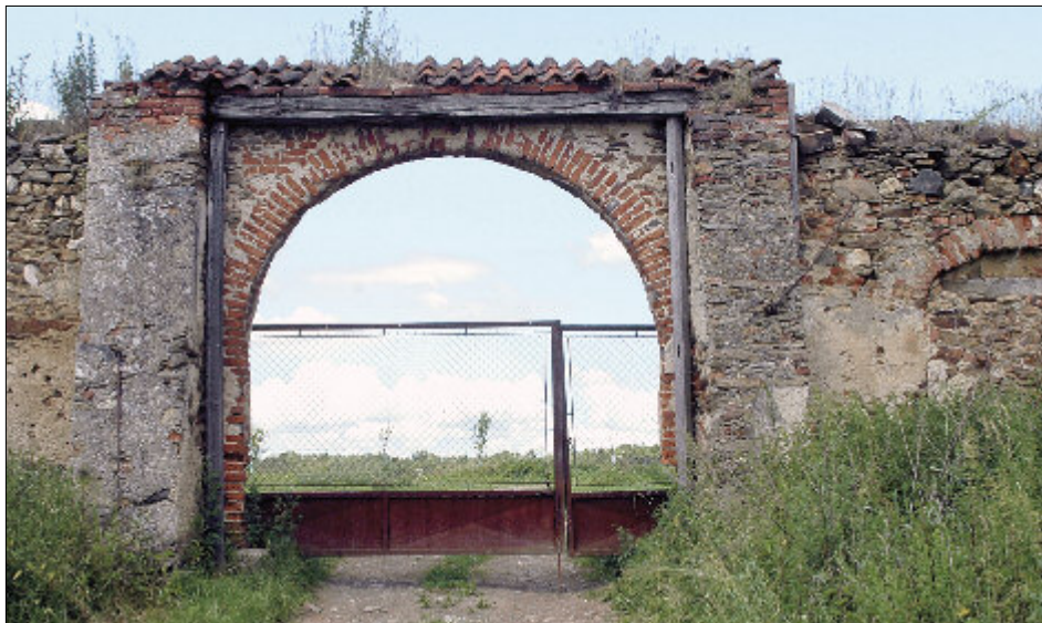
Obr. 2: Skalkov – pohled na vnitřní stranu brány s typickým dřevěným překladem niky a dodatečnými skarpovitými opěráky.
