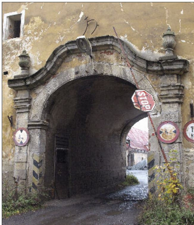
Obr. 26: Sedliště (okres Česká Lípa), bývalé panství Mímoň – náročné řešení portálu brány v čelní budově hospodářského dvora.
