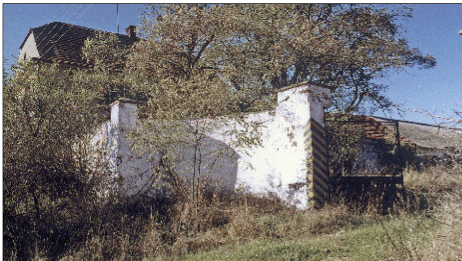
Obr. 22: Hejdov (okres Příbram), bývalé panství Hořovice – úprava brány v úseku ohradní zdi, půdorysně vyduť do prostoru dvora.
