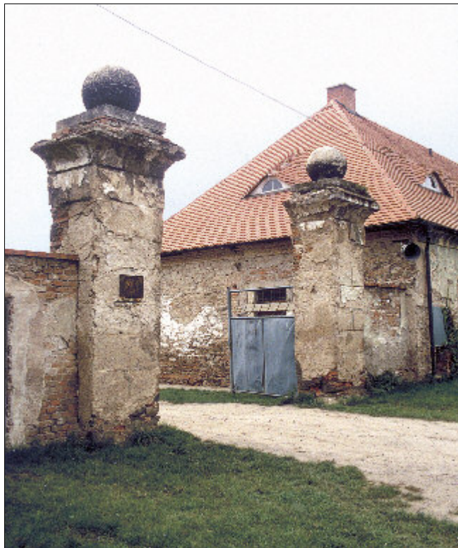
Obr. 36: Druhanice (okres Kutná Hora), bývalé panství Žehušice – piliřová brána dvora z úprav realizovaných v roce 1818.
