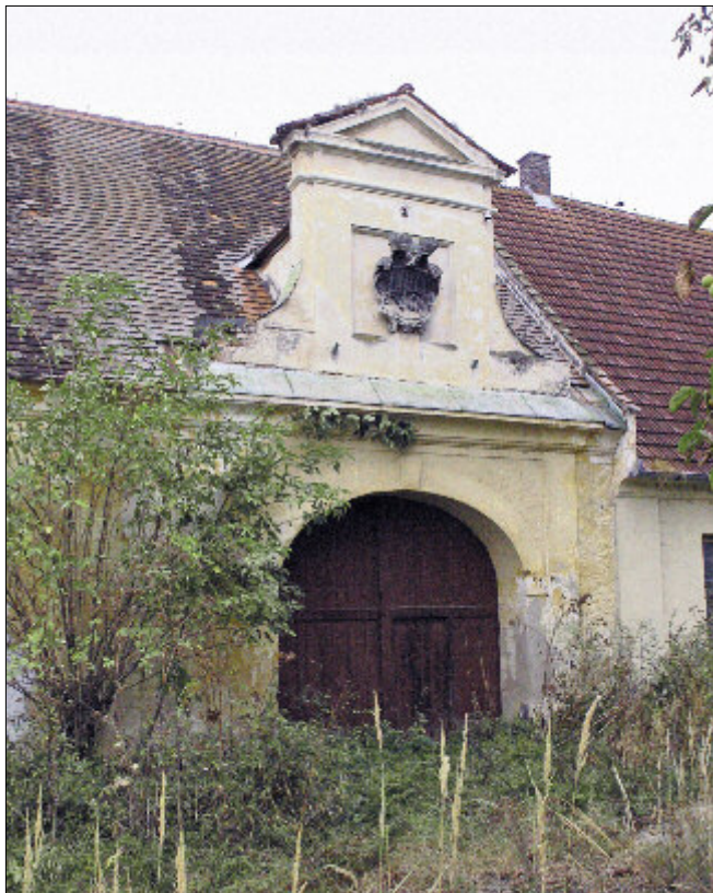
Obr. 24: Lhota (okres Jindřichův Hradec), bývalé panství Třeboň – brána v ose přízemní budovy čelní strany dvora, postaveného zřejmě v 90. letech 17. století G. A. Maggim.
