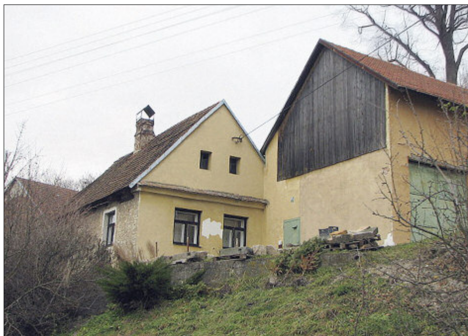
Obr. 22: Mravín, čp. 25, pohled na průčelí chalupnické usedlosti, dům postaven ve 40. letech 19. století, kolmé chlévy s průjezdem do dvora přistavěny po roce 1869 a na začátku dvacátého století opatřeny novou střešní konstrukcí.
