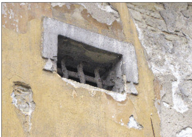
Obr. 20: Mravín, čp. 18, detail štukové výzdoby fasády sýpky, šambrána okenního otvoru v patře na dvorní štítové straně z poslední třetiny 19. století.
