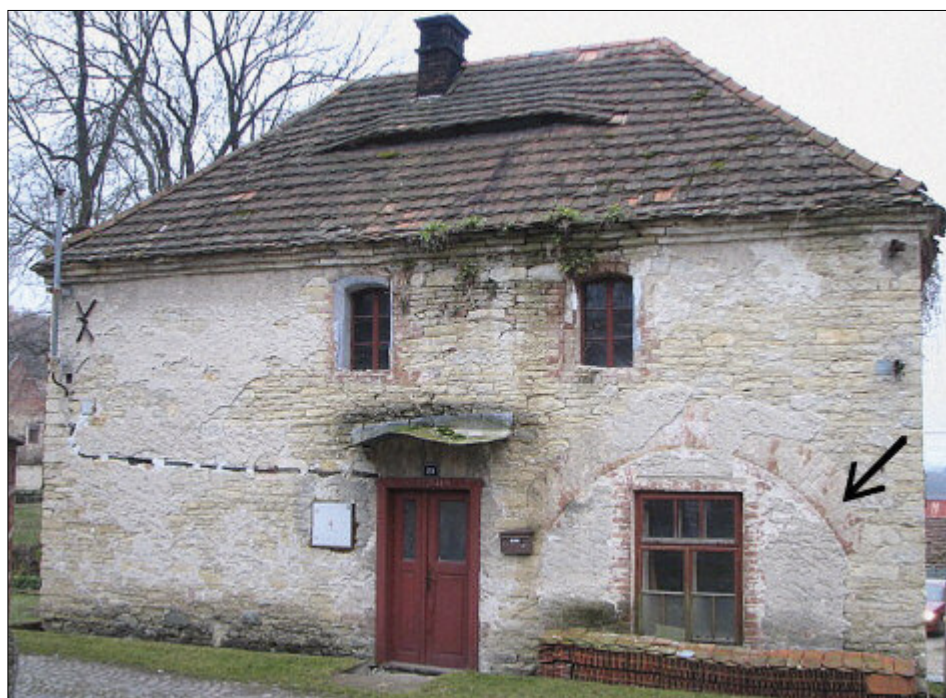
Obr. 21: Mravín, čp. 20, pohled na vstupní stranu, kde v pravé části vstupního průčelí je označen černou šipkou klenutý cihelný pas, který poukazuje na původní funkci objektu, provoz kovárny. Identický cihelný oblouk je na zadní štitové stěně.
