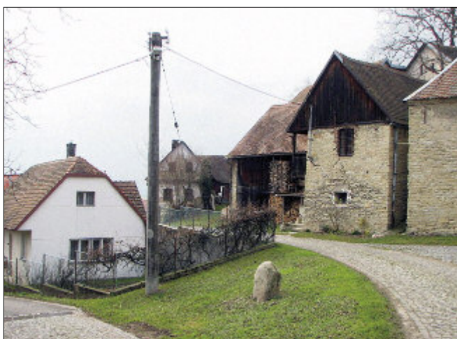
Obr. 3: Mravín, současný pohled na domkářskou zástavbu v západní části vesnice zachycuje domy čp. 9, 10, 11. Domy čp. 10 a 11 jsou zachovány v původní hmotě z doby výstavby po požáru roku 1877.
