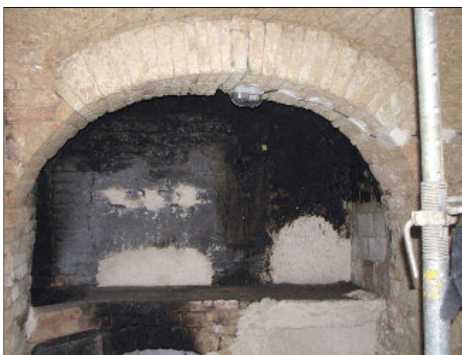
Obr. 16: Mravín, čp. 3, pohled na zazděná ústí obslužných otvorů (zleva kamna, pec) pod dymníkem v kuchyňské nise v zadní části síně.
