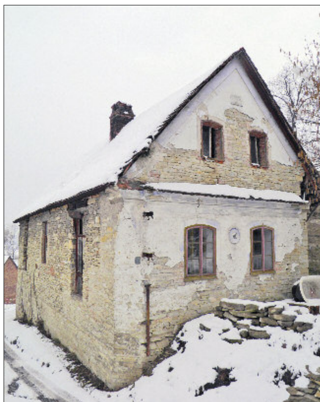
Obr. 17: Mravín, čp. 10, pohled na průčelí domu domkáře, postaveného po požáru v roce 1877.
