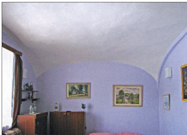
Obr. 23: Mravín, čp. 27, pohled na plackovou klenbu v obytné části domu, který byl postaven v roce 1866.
