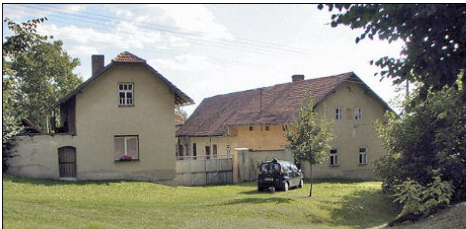
Obr. 15: Mravín, čp. 3, pohled na průčelí usedlosti situované na jižní straně návsi.
