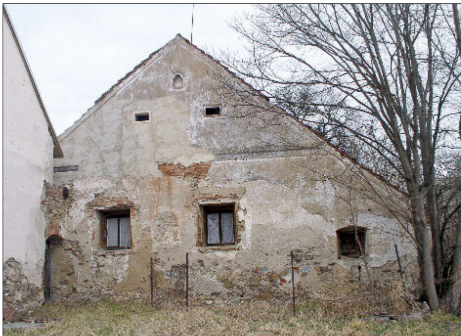
Obr. 12: Záluží, čp. 6 – jižní průčelí obytné části usedlosti, mezi novodobě upravovanými okny světnice je čitelné třetí, zazděné okénko.
