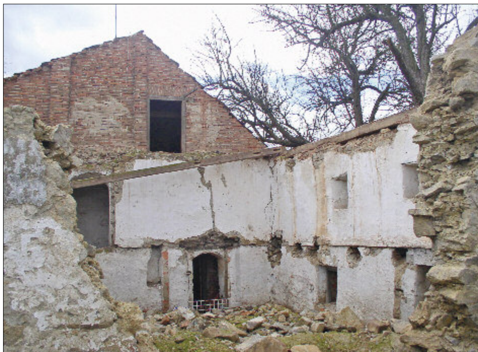
Obr. 13: Záluží, čp. 6 – průhled do zbytku komorové části domu, vpravo v patře dochovaná štěrbinová okna špýcharu, v přízemí vlevo od vstupu osvětlovací krbeček.
