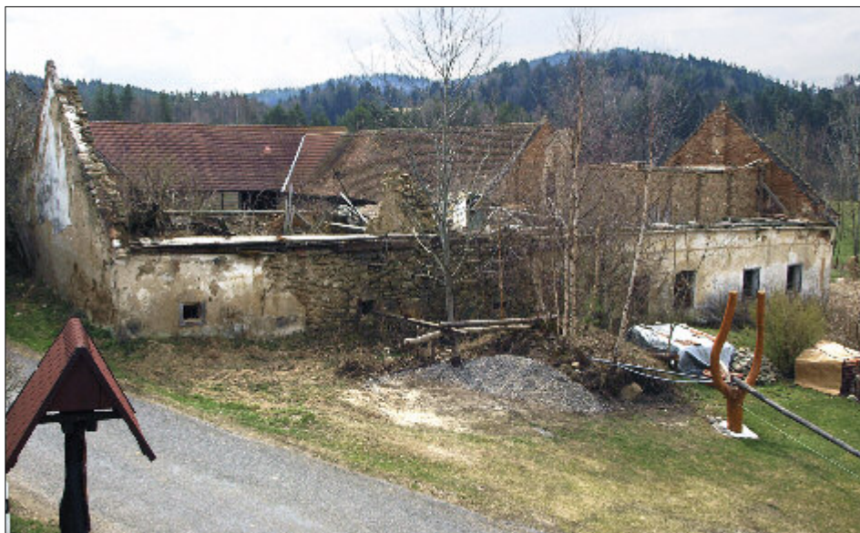
Obr. 23: Děkanské Skaliny, čp. 13 – celkový pohled na usedlost do jihozápadu, v popředí obytná část.
