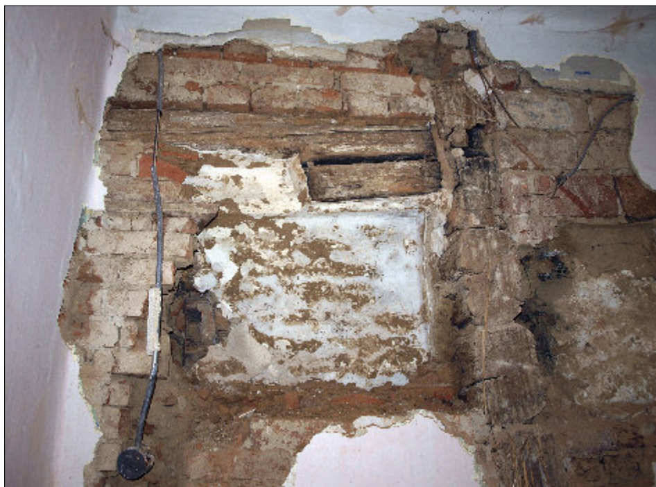
Obr. 7: Mirkovice, čp. 1 – odkrytý fragment roubené přičky a roubení nádvorní stěny s částečně viditelným zadržujícím oknem, vpravo od přičky patrné stopy zadehtování kamenné stěny síně.
