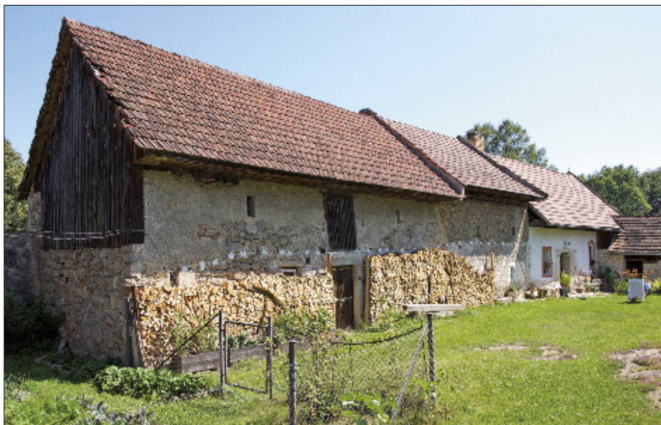
Obr. 16: Přísečno, čp. 3 – pohled na hlavní obytnou část s navazujícími chlévy v popředí.
