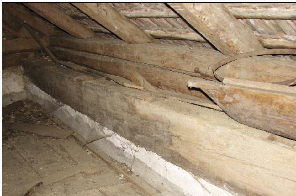
Obr. 8: Mirkovice, čp. 1 – roubený věnec je fragmentem konstrukce lepenice dochovaným v podkroví samostatně stojícího patrového špýcharu.
