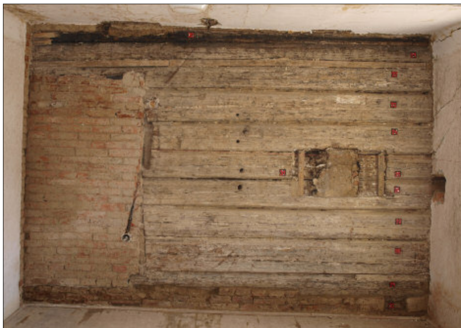
Obr. 9: Mirkovice čp. 1 – pohled na východní stěnu roubené místnosti domu, nad zazděným dveřním otvorem je dochovaná spodní část dymného okénka, u pravé špalety fragment původního okénka a zcela vpravo kompletně dochované okénko jizby.
