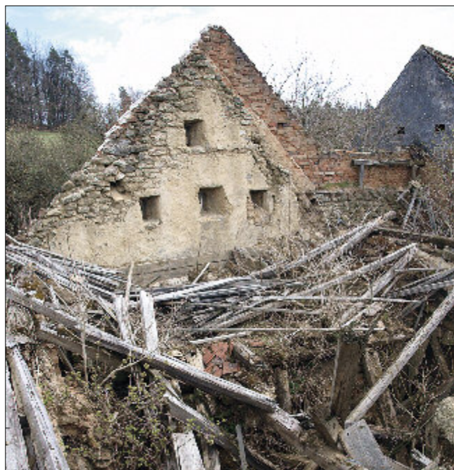
Obr. 24: Děkanské Skaliny, čp. 13 – pohled do interiéru komorové části, v pozadí štit s pyramidálně komponovanými špýcharovými okny, ve štitu zazděné trámy, datované do roku 1572–1573 (foto autor).
