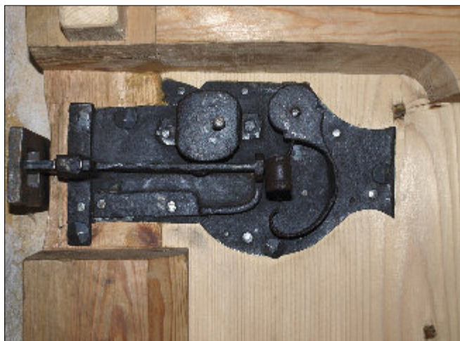
Obr. 19: Přísečno, čp. 3 – zámek vstupních dveří nalezený vlastníkem nemovitosti na půdě špýcharu.
