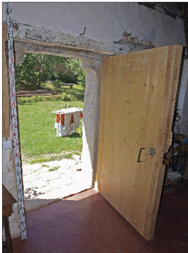
Obr. 18: Přísečno, čp. 3 – vstupní dveře do síně se sedlovým portálem a replikou točnicových dveří, uložených v původním lůžku.
