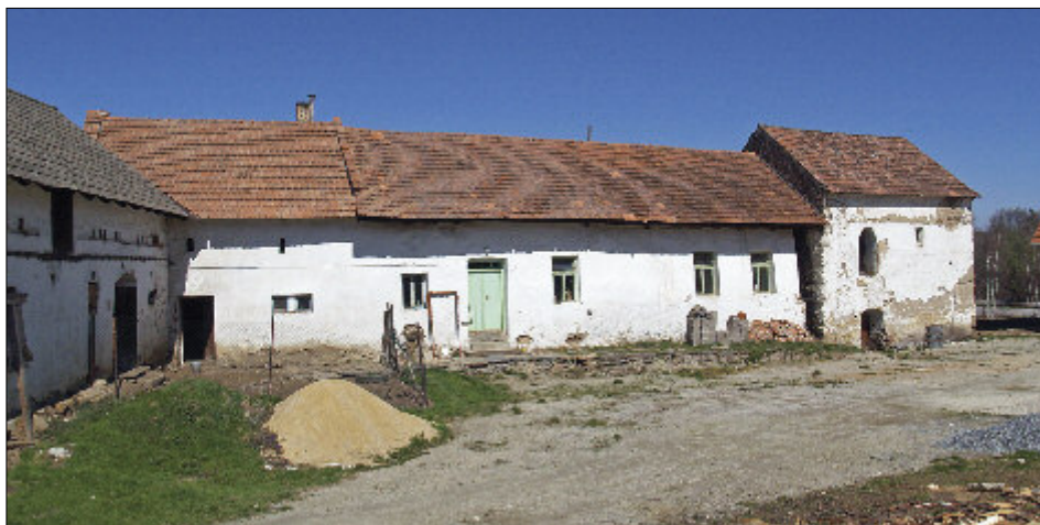
Obr. 3: Mirkovice, čp. 1 – zleva klasicistní chlévy přiléhající na komorový díl obytné části, dále síň a světnice s roubením, zcela vpravo samostatně stojící patrový středověký špýchar (všechny snímky autor, není-li uvedeno jinak).
