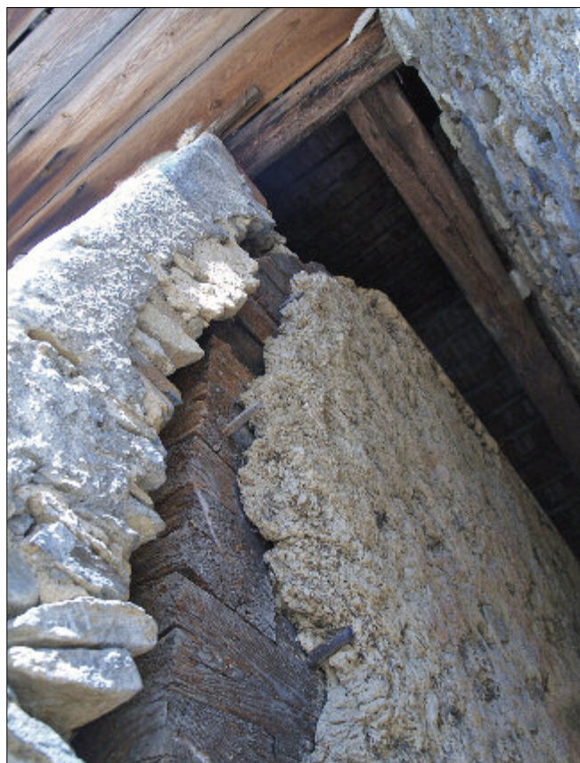
Obr. 4: Mirkovice, čp. 1 – detail jihovýchodního nároží světnice s roubením opatřeným kamennou přízdívkou a hliněnou omazávkou.
