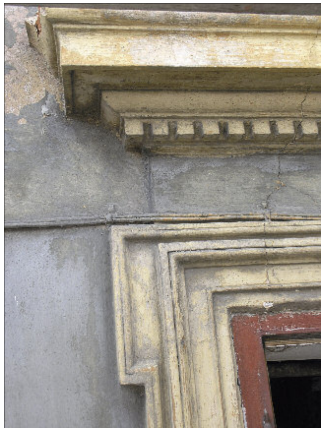
Obr. 5: Brandýs nad Labem, dům čp. 98 – průčelí do náměstí. Detail okení šambrány s římsou z poslední historizující úpravy z roku 1878, stav 2005.
