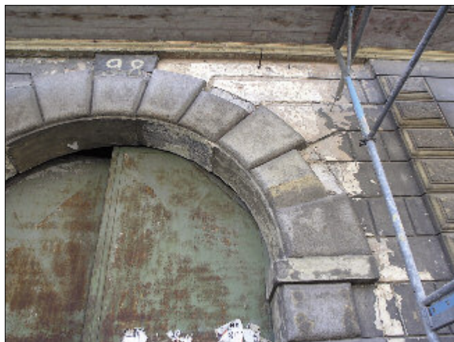
Obr. 4: Brandýs nad Labem, dům čp. 98. Detail pozdně renesančního bovaného portálu, stav 2005.
