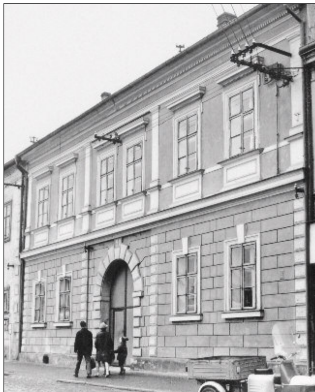
Obr. 2: Brandýs nad Labem, dům čp. 98 – průčelí do náměstí, stav v roce 1971 (foto M. Hauserová, Fotoarchiv NPÚ ÚOPSC).
