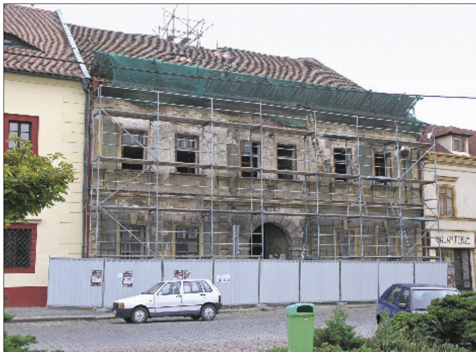
Obr. 3: Brandýs nad Labem, dům čp. 98 – průčelí do náměstí, stav 2005 (všechny snímky E. Vyletová, není-li uvedeno jinak).
