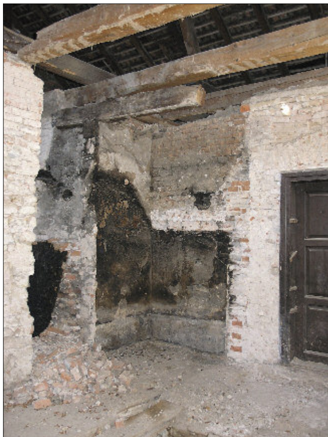
Obr. 17: Brandýs nad Labem, dům čp. 98 – patro. Otisk dymníku otopné komory v chodbě, stav 2005.
