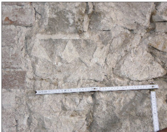
Obr. 12: Brandýs nad Labem, dům čp. 98. Úlomky kvádrů se sgrafitem druhotně užitá ve zdivu přízemí, stav 2005.
