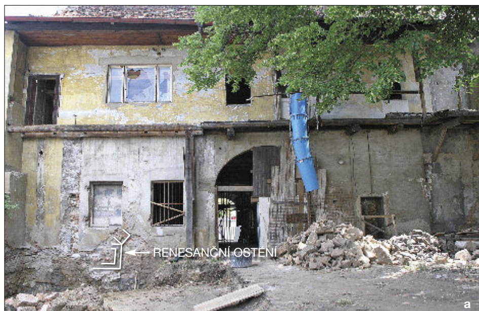
Obr. 7: Brandýs nad Labem, dům čp. 98: a – průčelí do dvora, pod levou okenní osou v přízemí zachována část renesančního ostění okna vedoucí na schodiště do sklepa; b – detail renesančního ostění s částí původního vynášecího cihelného záklenku; c – detail špalety ze strany interiéru zaniklého schodiště, stav 2005.
