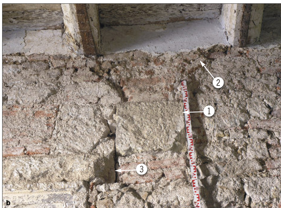
Obr. 10: Brandýs nad Labem, dům čp. 98 – přízemí, a: průjezd s pohledem směrem ke dvoru. 1 – kvádry s otisky odsekaných konzol nebo kapsy po nich ve zdivu; 2 – odsekané cihelné náběhy klenby; 3 – části portálů; b: detail konzoly s otiskem odsekané profilace, stav 2013.
