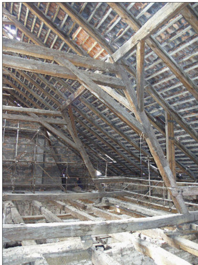
Obr. 18: Brandýs nad Labem, dům čp. 98 – krov z roku 1878, stav 2005.
