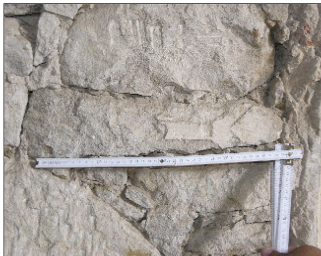
Obr. 12: Brandýs nad Labem, dům čp. 98. Úlomky kvádrů se sgrafitem druhotně užitá ve zdivu přízemí, stav 2005.
