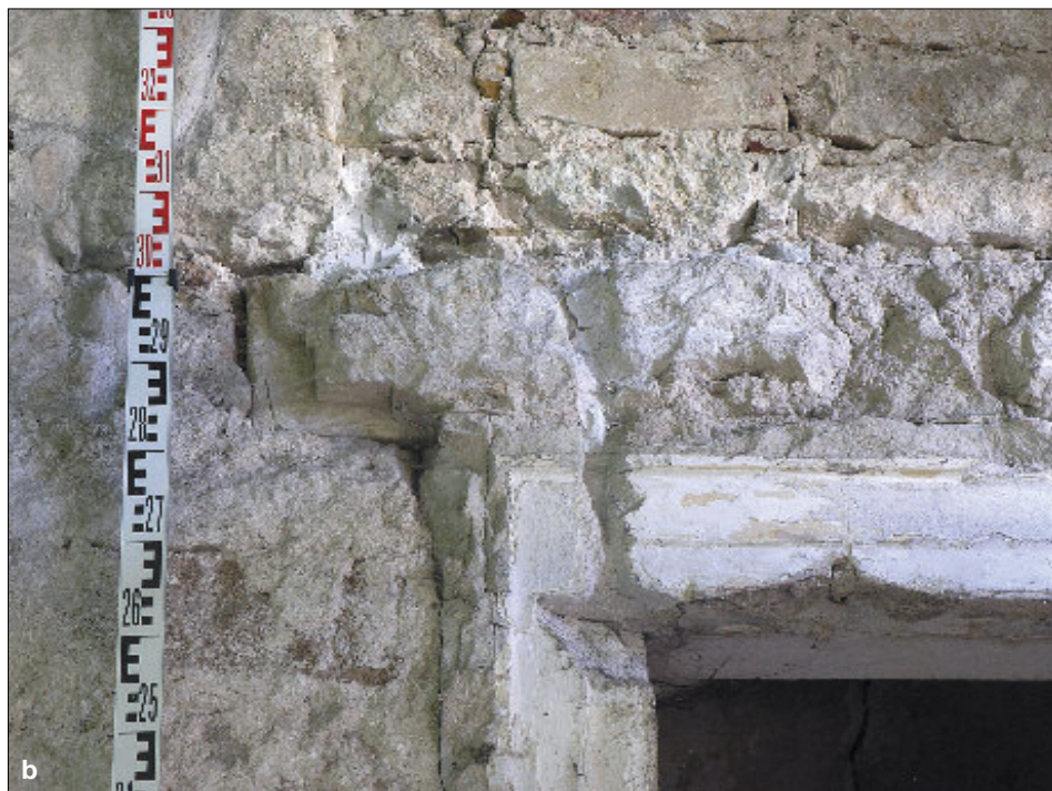
Obr. 11: Brandýs nad Labem, dům čp. 98 – přízemí, průjezd: a – dvojice portálů na schodiště do patra a do sklepa s odsekanými římsami; b – detail profilace římsy, stav 2013.
