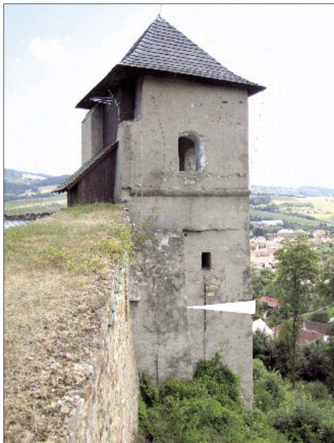
Obr. 11: Hrad Brumov – pohled na západní fasádu rizalitu, vystupujícího před jižní průčelí jádra; šipka ukazuje na jihozápadní nároží staršího, hranolového objektu, pojatého do hmoty rizalitu.
