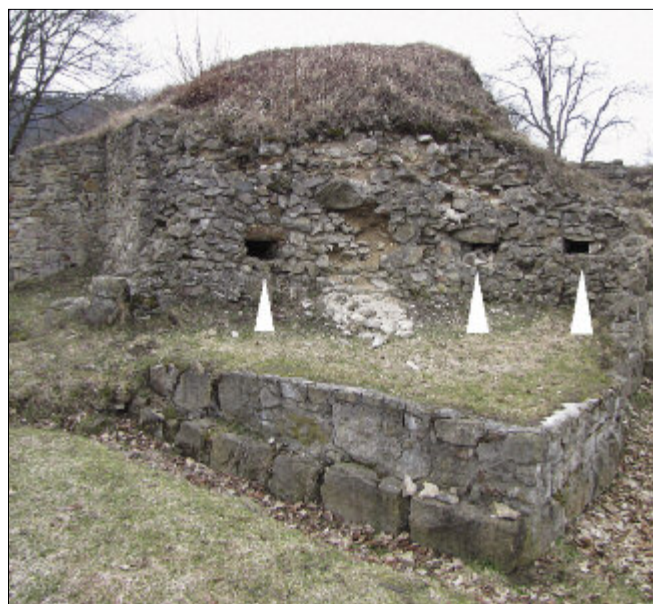
Obr. 5: Hrad Brumov – torzo hranolové věže, pohled od jihu; v popředí základové zdivo jižního nároží, šipky označují otvory po dřevěných trámech v amorfním zdivu hmoty věže; nalevo zdivo související s pozdějším průrazem vstupu do jádra, napravo svíslá spára, oddávající jihovýchodní stěnu věže od přiložené hradby, a upravené ústí pece.
