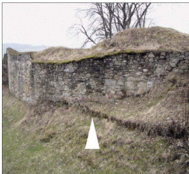
Obr. 4: Hrad Brumov – severní čelo jádra, pohled od severozápadu; šipka označuje pozůstatky zakonzervované severovýchodní stěny hranolové věže, ležící nyní před hradbou jádra.
