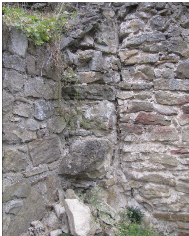
Obr. 7: Hrad Brumov – torzo hranolové věže; detail styku torza jihovýchodního průčelí věže (uprostřed) se zdivem severní obvodové zdi jádra (napravo). Vlevo se nachází novodobé zdivo, které nahradilo destruovanou, cihelnou zeď mladší pece.
