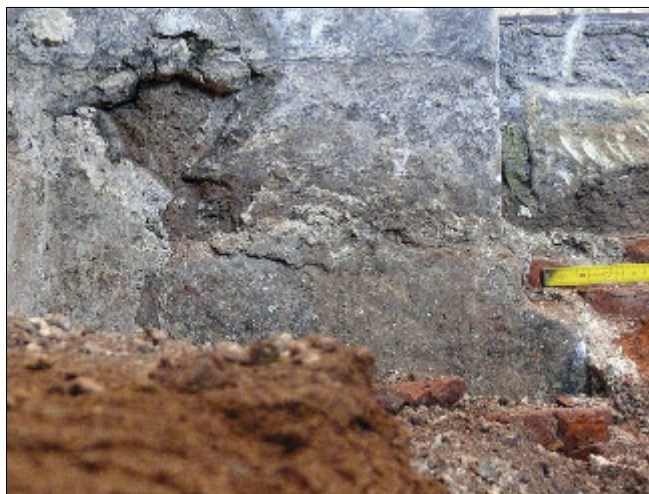
Obr. 7: Náchod, kostel sv. Vavřince – soklová partie vítězného oblouku.
