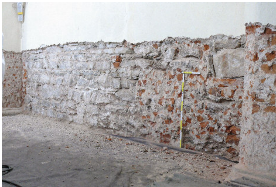
Obr. 9: Náchod, kostel sv. Vavřince – jižní stěna lodi, vlevo kamenné zdivo; v pravé části nerovný líc dozděný zlomky cihel; napravo od skládacího dvoumetru smíšená partie s pískovcovým kvádrem (druhotně užitá nárožní armatura?). Zcela vpravo a zcela vlevo pilíře klenby. Nad rozhraním kamenného zdiva a zdiva se zlomky cihel je patrná svíslá trhlina.
