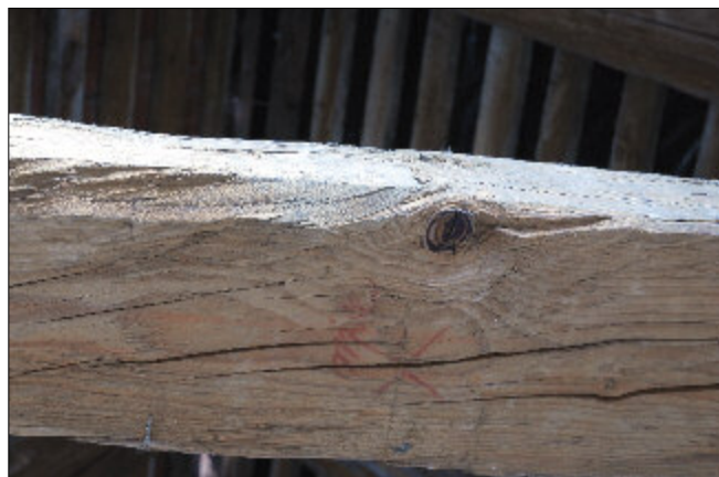
Obr. 23: Výšovice, kostel sv. Vavřince. Vyznačení osy vazby linkou vyrytou ostrým či špičatým předmětem a nápisem rudkou „míl“ na spodní straně horního hambalku 31. vazby (1. plně příčné vazby) v partii krovu nad kněžištěm.
