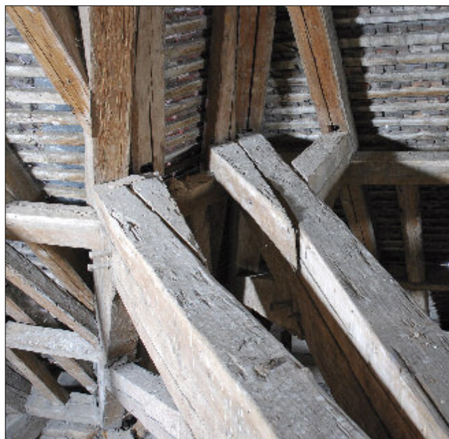
Obr. 21: Výšovice, kostel sv. Vavřince. Lípnutí velmi krátkých hambalků (krátčat) k boční straně delších hambalků vazeb tvořících přechod mezi lodí a kněžištěm (JZ partie krovu).
