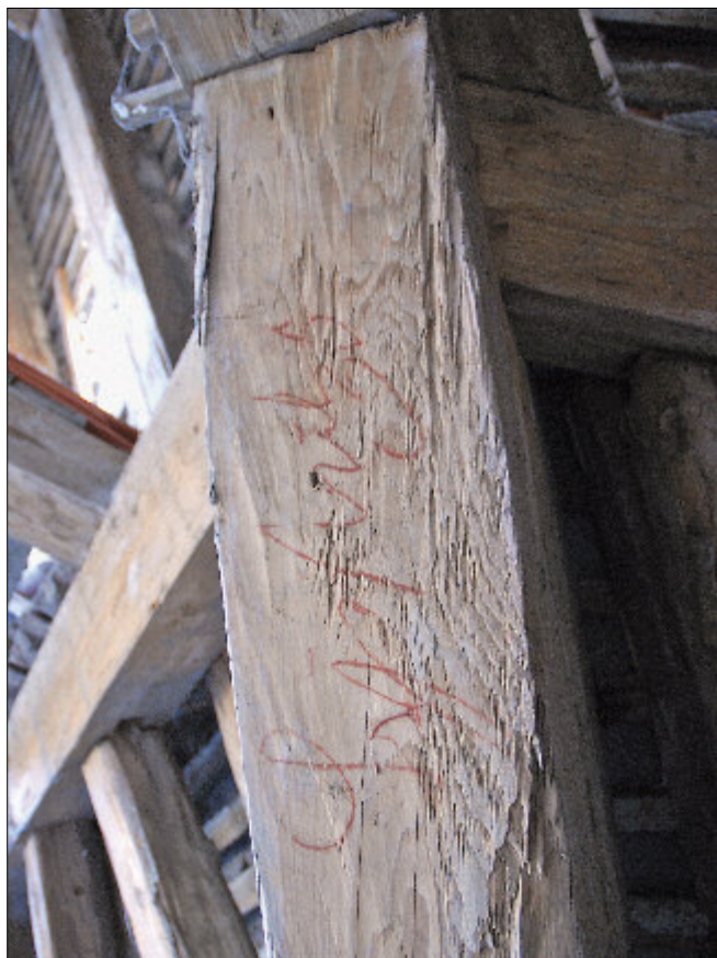
Obr. 24: Výšovice, kostel sv. Vavřince. Nápis „Brzesowitz 5“ (?) provedený rudkou na sloupku stolice 30. (úboční plně vazby v JZ části krovu.
