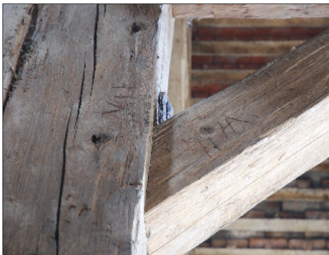
Obr. 16: Výšovice, kostel sv. Vavřince. Tesařské montážní značky provedené rudkou (arabská číslce) a dlátem nebo dlátovkou (římská číslce) na věšáku 4. plné příčné vazby a na zavětrovacím pásku podélného vázání v ose partie krovu nad lodí (pohled od JZ).
