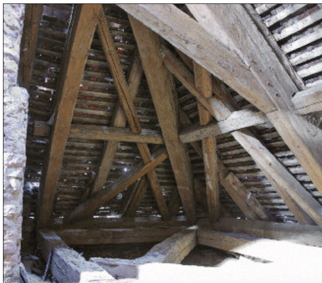
Obr. 18: Výšovice, kostel sv. Vavřince. Severní nároží (valba) v partii krovu nad lodí.
