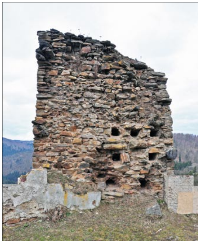
Obr. 14: Hasištejn, pohled z jižního paláce na dodatečný pilíř na jeho západní straně. Snížením zdiva paláce došlo k obnažení styčné plochy pilíře, na níž je zřetelný systém kotev z dřevěných trámů (v pravé polovině) a cedičových sloupců (po stranách; 2014).
