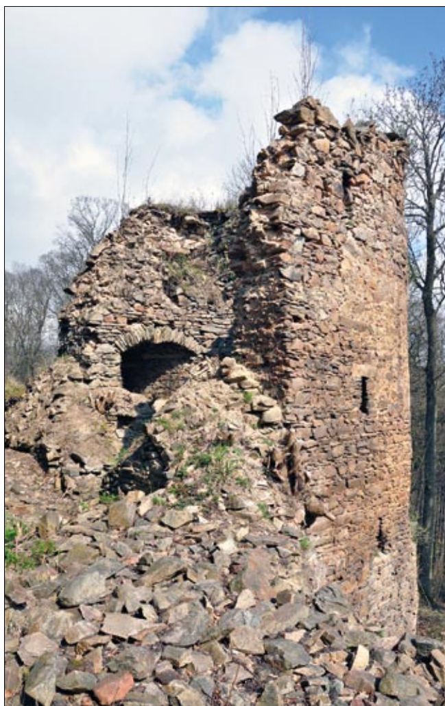
Obr. 34: Hasištejn, východní parkánová bašta od jihozápadu, z parkánu. Dobře patrné je někdejší příložení k parkánové hradbě na spáru (hradba ve vyšších partiích zanikla). Nahoře je vidět zasypání postranní střelny 2. patra sutí (2014).
