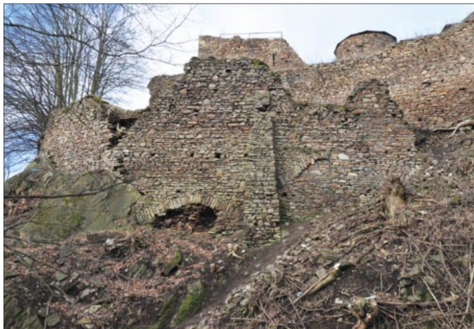
Obr. 38: Hasištejn, úsek vnějšího líce hradby jižně od východní parkánové bašty. Uprostřed kónický opěrný pilíř, po jeho stranách vynášecí oblouky – pravá část upravována (2014).
