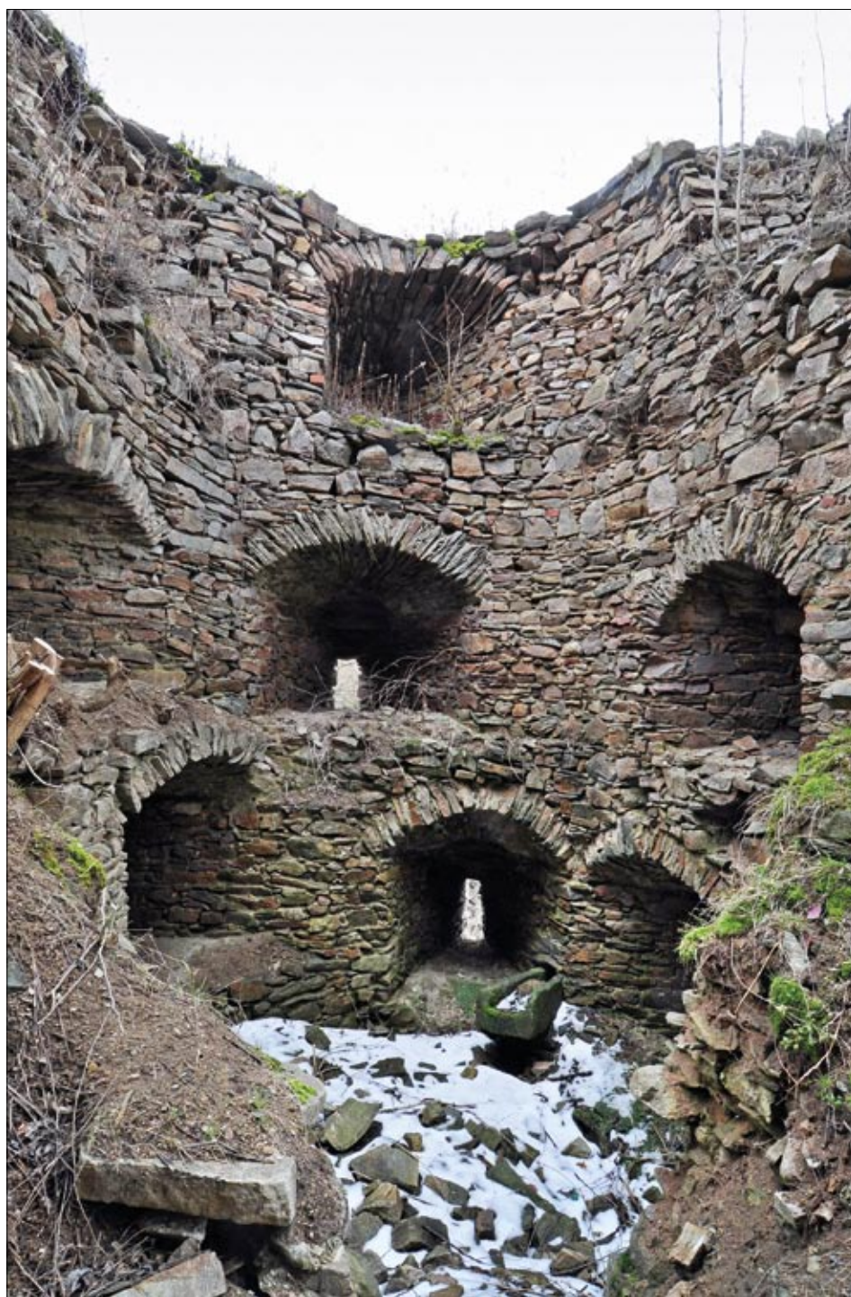
Obr. 35: Hasištejn, celkový pohled do interiéru východní parkánové bašty. Dole koryto mezi dvěma střílnami v přízemí (2014).
