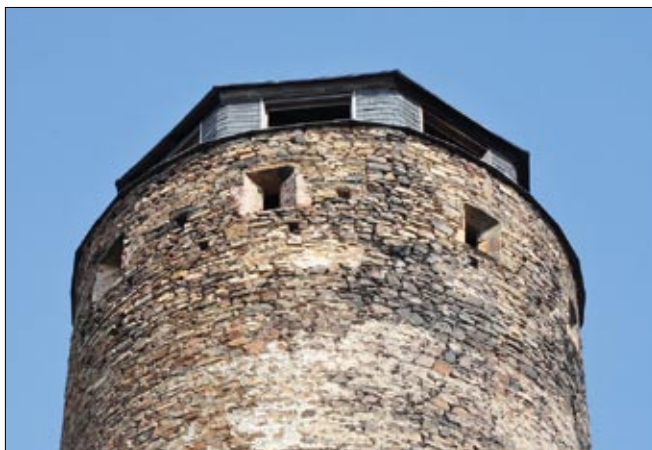
Obr. 16: Hasištejn, horní část válcové věže od jihozápadu. Zřetelně je patrný rozsah původního zdiva. Mezi okénky svíslá spára, zřejmě stopa původního cimbuří. Pod okénky pravidelně rozmístěné hranolové otvory (2014).
