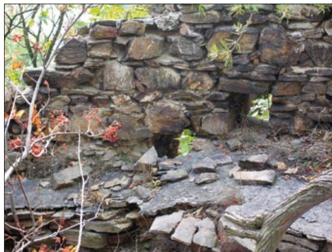
Obr. 51: Hasištejn, věž předsunutého opevnění, detail interiéru horního podlaží s otvorem po nosníku ochozu (vpravo) a otvorem nejasného účelu v poněkud nižší úrovni. Plocha podlahy ústupku byla při opravě koncem 19. století pokryta betonovou krustou (2006).
