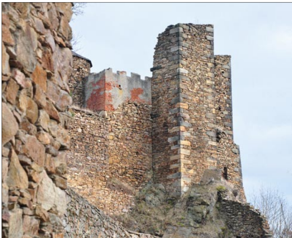
Obr. 10: Hasištejn, jižní věžový palác v pohledu od severozápadu, se dvěma dodatečnými opěráky (2014).
