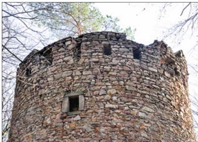
Obr. 46: Hasištejn, věž předsunutého opevnění, detail otvorů po zaniklých nosnících předsazeného ochozu na severozápadní straně (2013).
