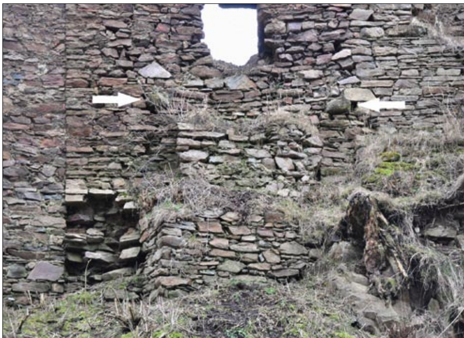
Obr. 24: Hasištejn, detail dolní části zrušené brány do parkánu (srov. obr. 22). Šipkami vyznačeny zbytky pískovcových kamenů, v nichž byly vytvářeny točnice pro padací most (2014).
