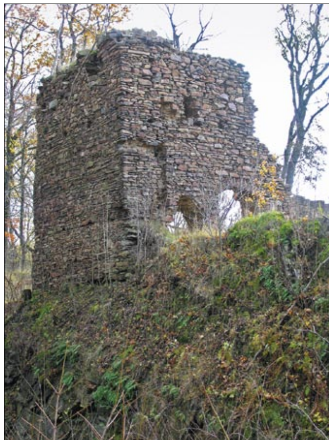
Obr. 40: Hasištejn, torzo stavby nejasného účelu na severním valu (srov. obr. 39) v pohledu od severozápadu. Stav před nedávnou úpravou, při níž byl setřen detail návaznosti zdi běžící k 1. bráně (2006).
