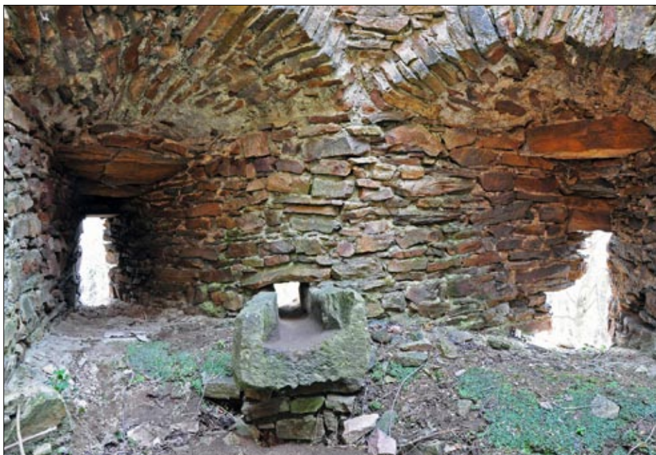
Obr. 36: Hasištejn, detailní pohled na koryto v přízemí východní parkánové bašty (srov. obr. 31, 33 a 35; 2014).
