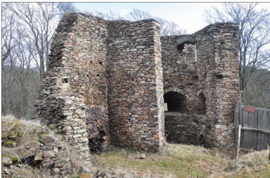
Obr. 26: Hasištejn, celkový pohled do interiéru severovýchodní parkánové bašty a bývalé brány (vlevo; 2014).
