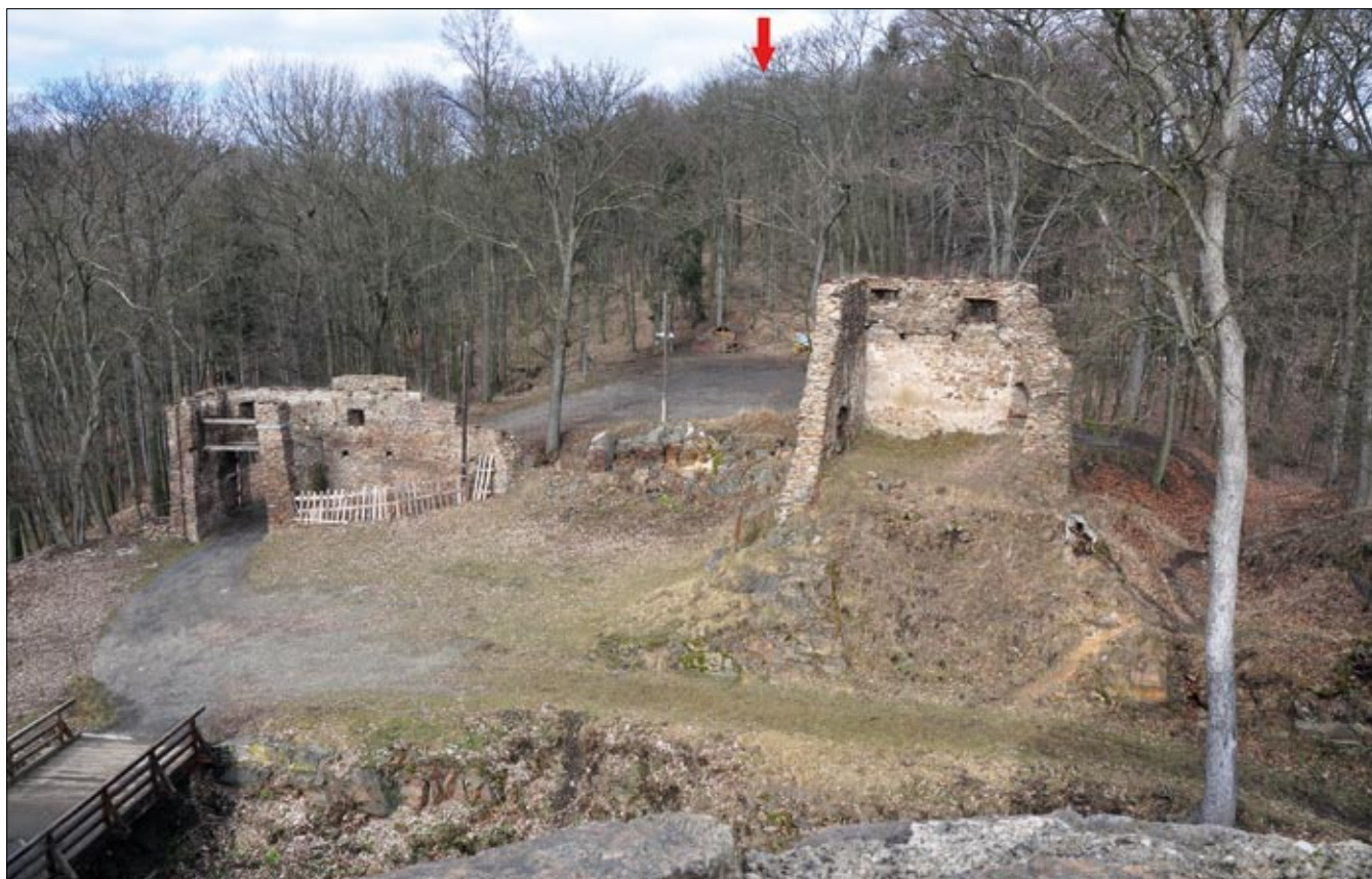
Obr. 42: Hasištejn, pohled na severní část valu z jádra hradu. Vpravo torzo stavby nejasného účelu se dvěma různými střílnami v patře, vlevo dnešní 1. brána. Šípkou vyznačena poloha věže předsunutého opevnění, která je dnes obklopená vzrostlými stromy (2014).
