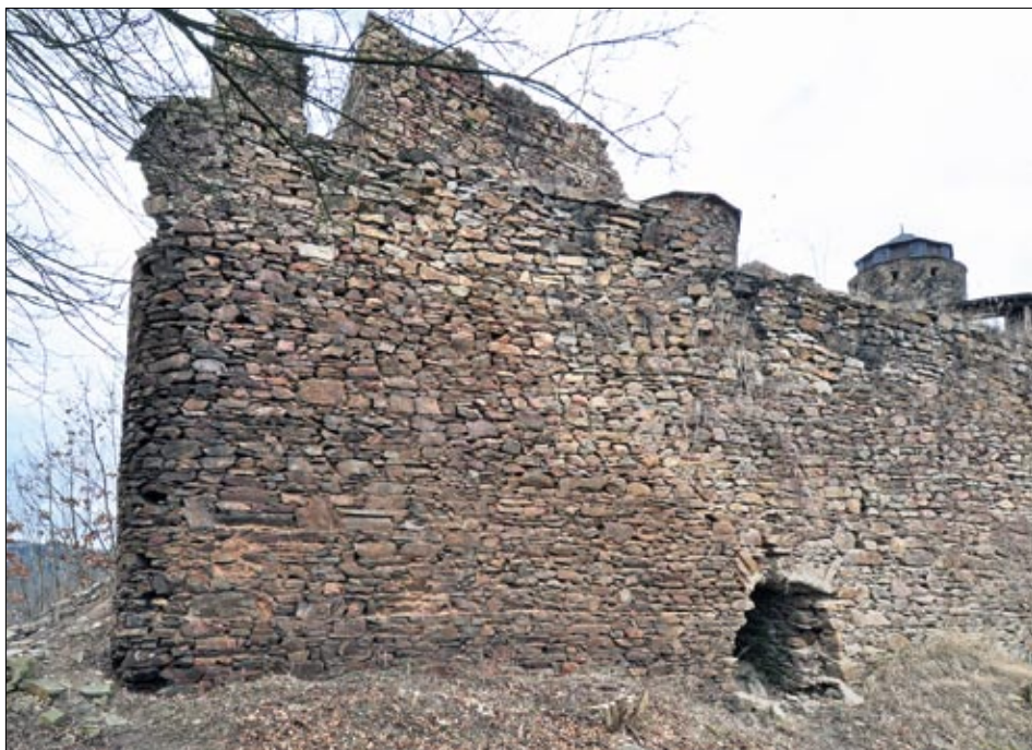
Obr. 21: Hasištejn, pohled z parkánu na jihovýchodní zaoblené nároží hradby jádra (srov. obr. 13), vpravo původní branka s vytrhaným ostěním (2014).
