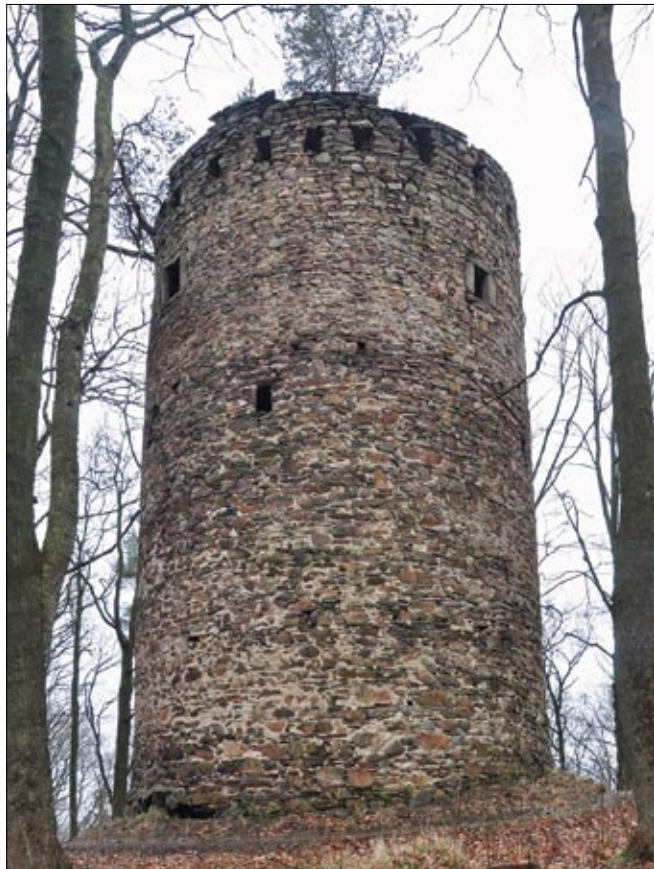
Obr. 43: Hasištejn, věž předsunutého opevnění od severovýchodu. V 1. patře střílna bez ostění, ve 2. patře dvě větší střílny s ostěním, složeným z druhotně použitých tesaných prvků. Nahoře otvory po zaniklých nosnících předsazeného ochozu (2014).
