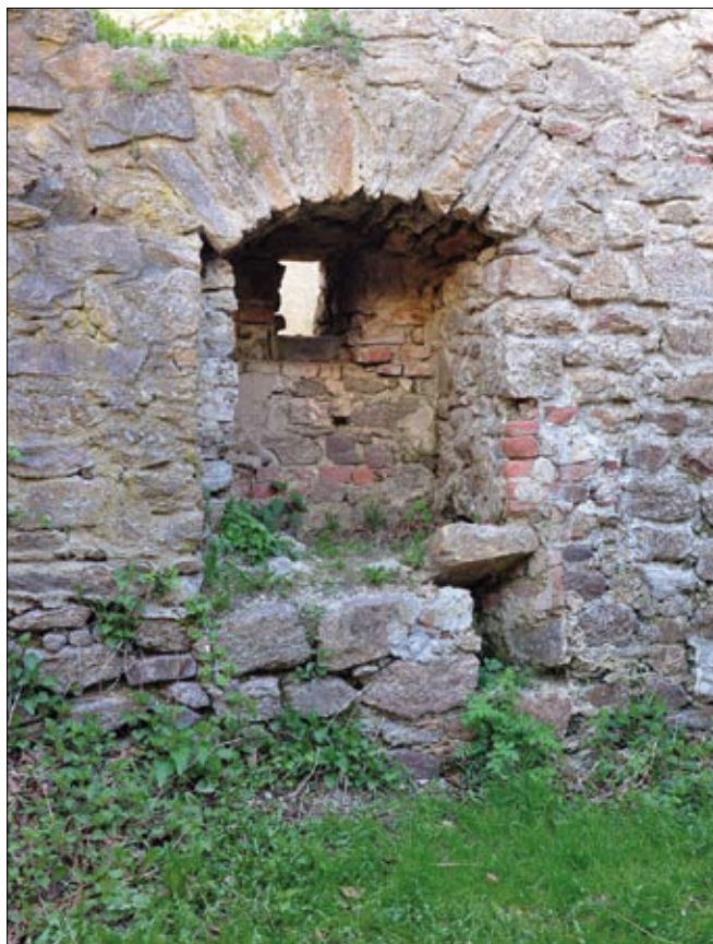
Obr. 52: Choustník (okres Tábor). Střílna pro ruční palnou zbraň v objektu jižně od brány do jádra hradu. V pravém dolním rohu niky šikmo dolů směřující otvor, patrně stejné funkce jako koryto ve východní parkánové baště hradu Hasištejna. Otvor je však zazděný a na vnější straně zdi se vůbec neprojevuje (2014).
