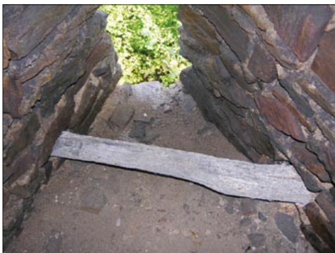
Obr. 37: Hasištejn, detail střední střílny v 1. patře východní parkánové bašty, s šikmo osazeným trámek pro zaklesnutí ruční palné zbraně (2006).
