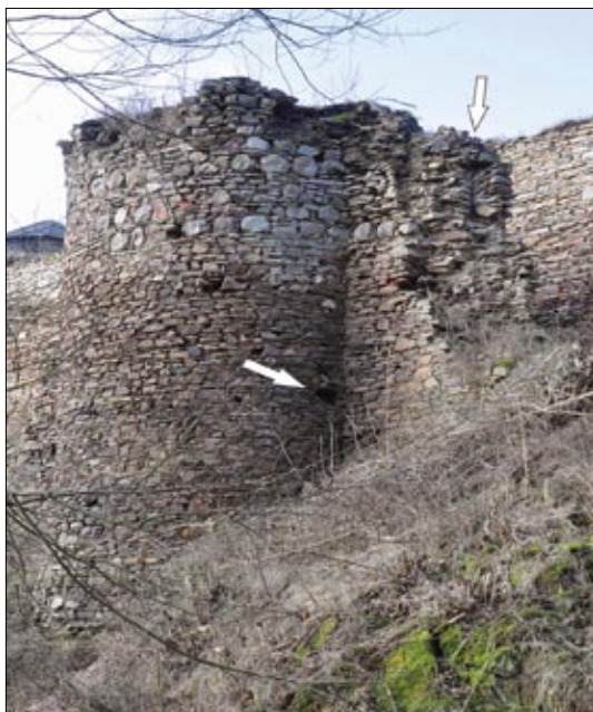
Obr. 28: Hasištejn, parkánová věž v pohledu od severovýchodu. Dobře je patrná horninová skladba s nevelkým uplatněním cihel. Dole při styku s kurtinou otvor druhotné střelny, upravo stopy zvýšení hradby, vyznačeno šipkami (2014)
