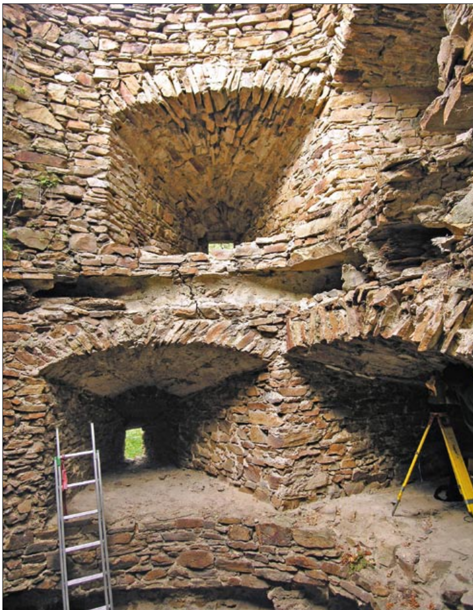
Obr. 49: Hasištejn, věž předsunutého opevnění, čtyři palebné komory v 1. a 2. patře a zbytky stopních konstrukcí (2006).
