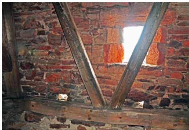
Obr. 17: Hasištejn, detail interiéru horního patra válcové věže. Jedno z okének, dole nad vodorovným trámem novodobého krovu dva hranolové otvory nejasné funkce (2014).
