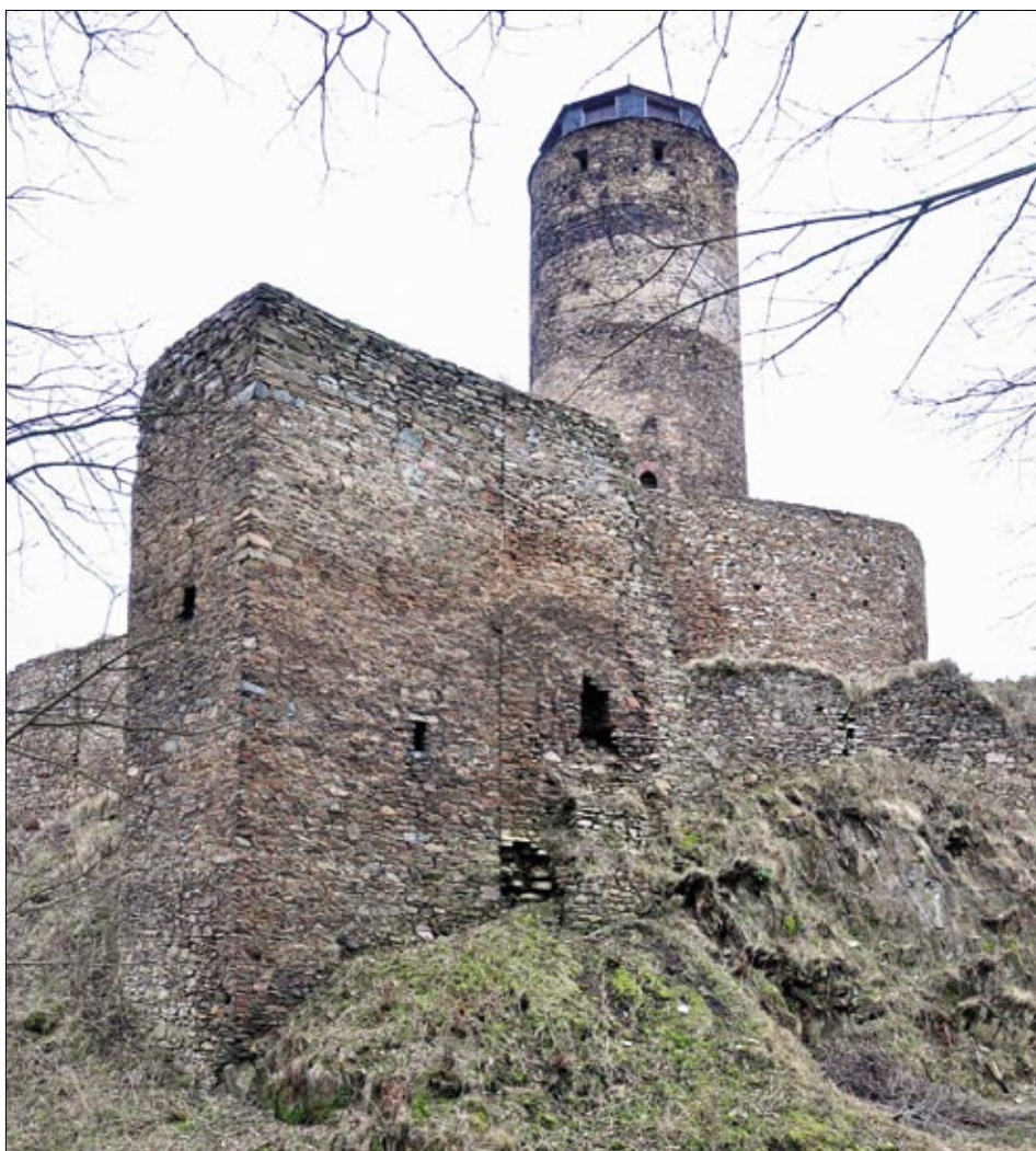
Obr. 22: Hasištejn, celkový pohled od severovýchodu na původní bránu do parkánu, přestavěnou na pozdně gotickou baštu. Horní část je výsledkem novodobé úpravy. Vpravo navazuje parkánová zeď, snad se střilnovým otvorem (2014).
