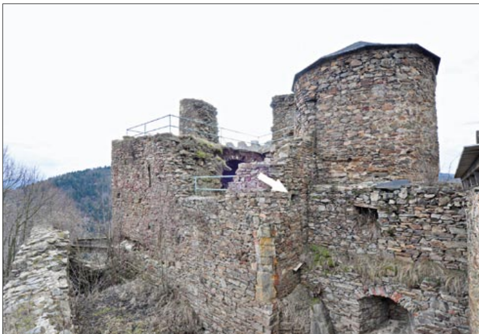
Obr. 12: Hasištejn, pohled od severovýchodu na věžový palác. Vpravo dodatečné točité schodiště, v pozadí vystupují dva druhotné opěráky (srov. obr. 7). Šipkou vyznačeno ležaté okénko nejasného účelu (2014).
