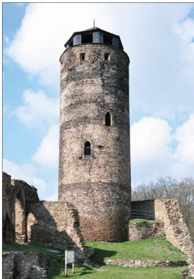
Obr. 15: Hasištejn, válcová věž – bergfrit v pohledu od jihu. Níže původní vchod do prvního patra, výše novodobý otvor z konce 19. století (2014).
