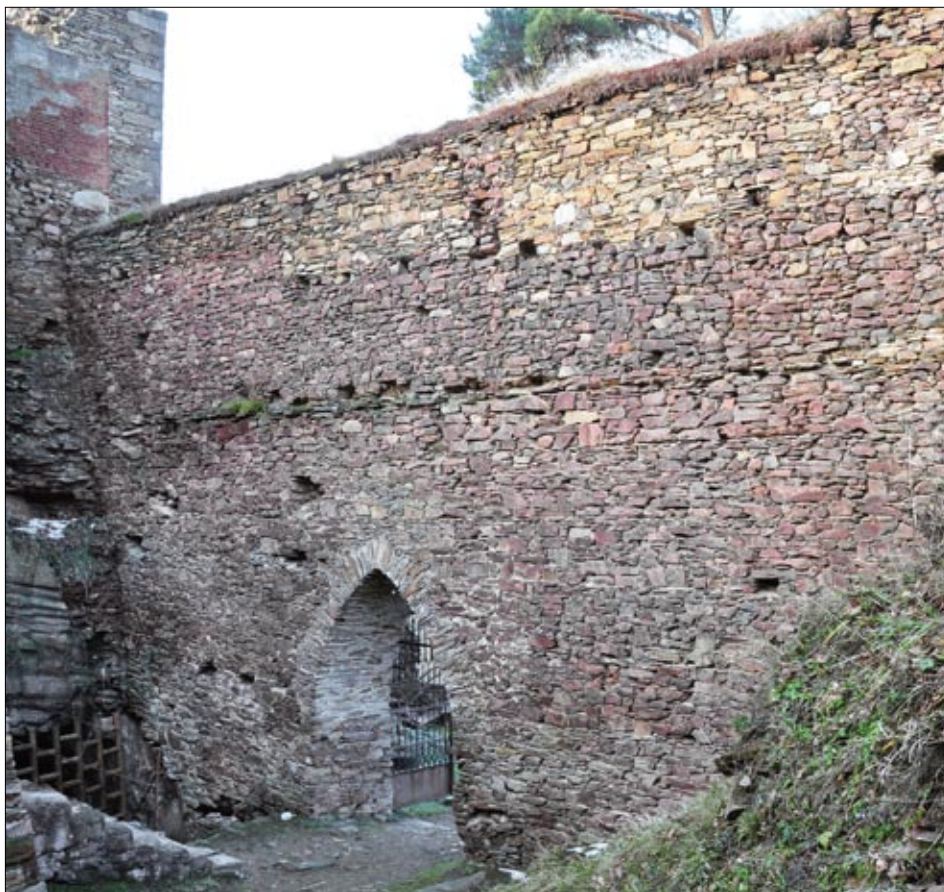
Obr. 18: Hasištejn, vnitřní líc hradby jádra s pohledem na dnešní třetí bránu. Vodorovná spára nad bránou, s předstupujícími kameny, patrně udává původní úroveň ochozu. Zcela vlevo hradba na spáru přiléhá k trnoži věžového paláce (2014).
