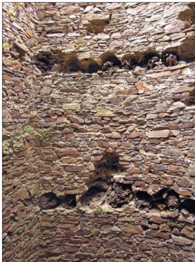
Obr. 47: Hasištejn, věž předsunutého opevnění, detail zbytků kmenů, které tvořily podlahy 1. a 2. patra (2006).
