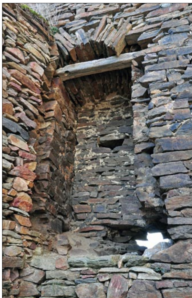
Obr. 8: Hasištejn, výklenek zrušeného prevetu v hradbě pod válcovou věží. Po stranách ústupky po zaniklých stojkách ostění, nahoře dendrochronologicky datovaný trám pro uchycení dveří (2014).
