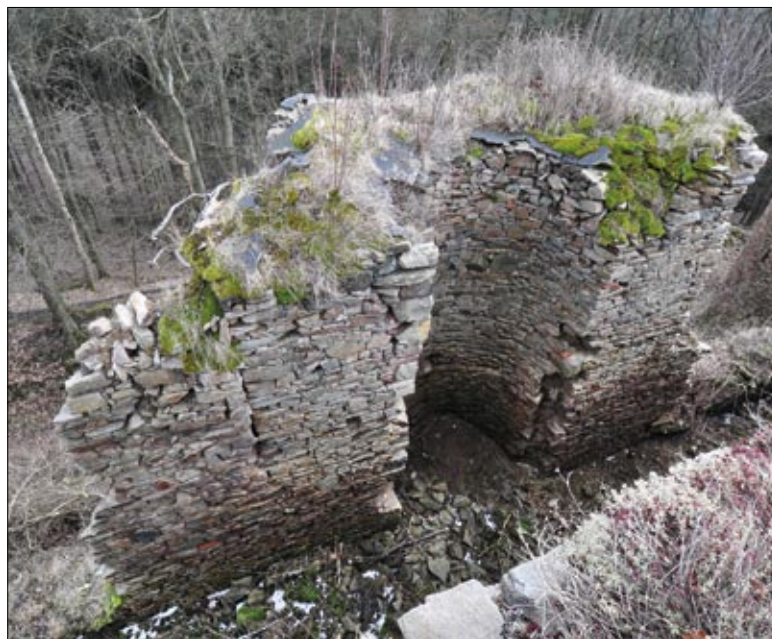
Obr. 29: Hasištejn, parkánová věž v pohledu z koruny hradby jádra. Vlevo svíslá spára oddělující zdivo věže od druhotné nadezdívky kurtiny. Na koruně věže rozlámaná cemento-asfaltová křa z konce 19. století (2014).
