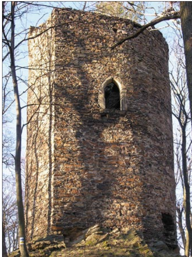
Obr. 44: Hasištejn, věž předsunutého opevnění od jihozápadu. Vlevo jediné nároží věže, v 1. patře původní vstup, vpravo dole novodobý průraz do přízemí (2008).
