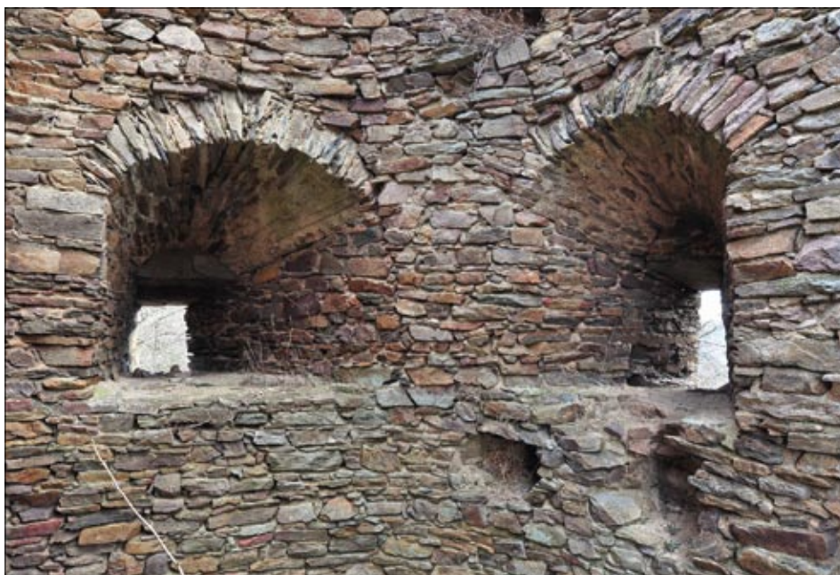
Obr. 27: Hasištejn, detail dvou střílen v 1. patře severovýchodní parkánové bašty (srov. obr. 26). Vlevo větší střílna pro větší palnou zbraň, bez stop lafetáže, vpravo poněkud menší střílna, v níž byl zazděn příčný trámek (otvor těsně nad parapetní plochou; 2014).
