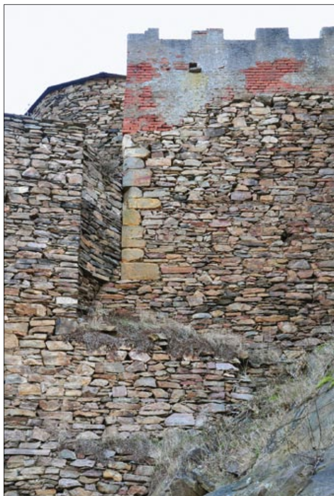
Obr. 11: Hasištejn, severozápadní nároží věžového paláce, armované pískovcovými kvádry, pohled od západu. Dolní část hradby předstupuje před průčelí paláce, horní část k nároží přiléhá novodobým konkávním obloučkem (2014).
