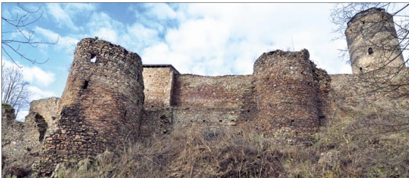
Obr. 30: Hasištejn, pohled z valu na část opevnění parkánu s věží (srov. obr. 28) a východní baštou. Mezi nimi úsek parkánové hradby (světlejší zdivo je druhotné, vlevo od něj zbytky opěrného pilíře). Na levé straně bašty zbytky vystupujícího koryta (2014).
