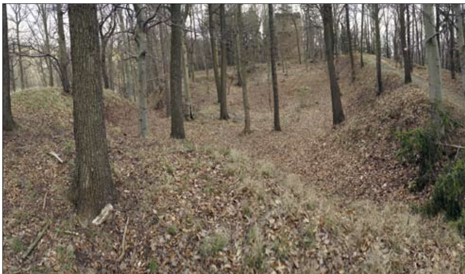
Obr. 17: Hrad Hasištejn, předsunutá bašta, pohled z koruny čelního náspu k jihu, v pozadí věž (foto J. Marounek, 2014).
