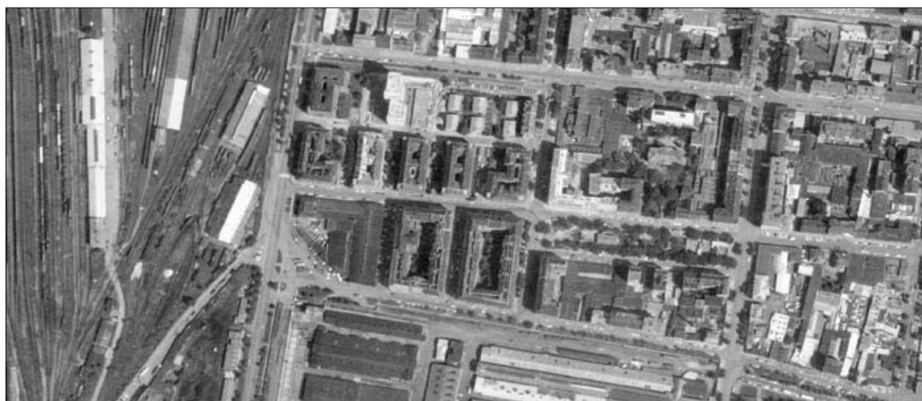
Obr. 20: Praha 7, poslední domy bubenské kolonie na snímku z roku 1975 (Geoportál Praha).
