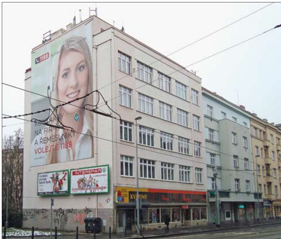
Obr. 5: Praha 9-Vyšochaň, čp. 608/312, bývalý obchodní dům Baťa (foto A. Dorňáková, 2013).
