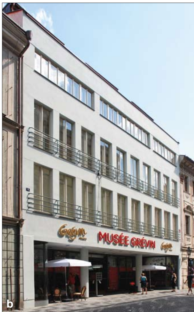
Obr. 6: Praha 1-Staré Město, čp. 596/15: a – obchodní dům Baťa, 30. Léta (repro z: MZA v Brně, SOkA Zlín); b – bývalý obchodní dům Baťa na Celetné ulici, hlavní fasáda (foto V. Tutr, 2014).
