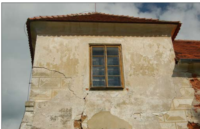
Obr. 13: Lustenec, dvůr. Detail jihozápadního průčelí obytné budovy s obnaženou sgrafitovou výzdobou (foto D. Kovář, 2010).
