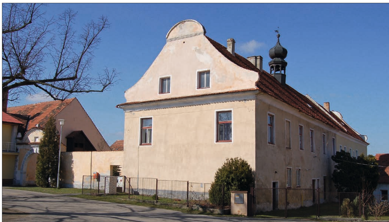
Obr. 18: Doubravice (okres České Budějovice), zámek. Východní štítové průčelí s vjezdem do bývalého panského dvora, pohled z návsi (foto D. Kovář, 2007).
