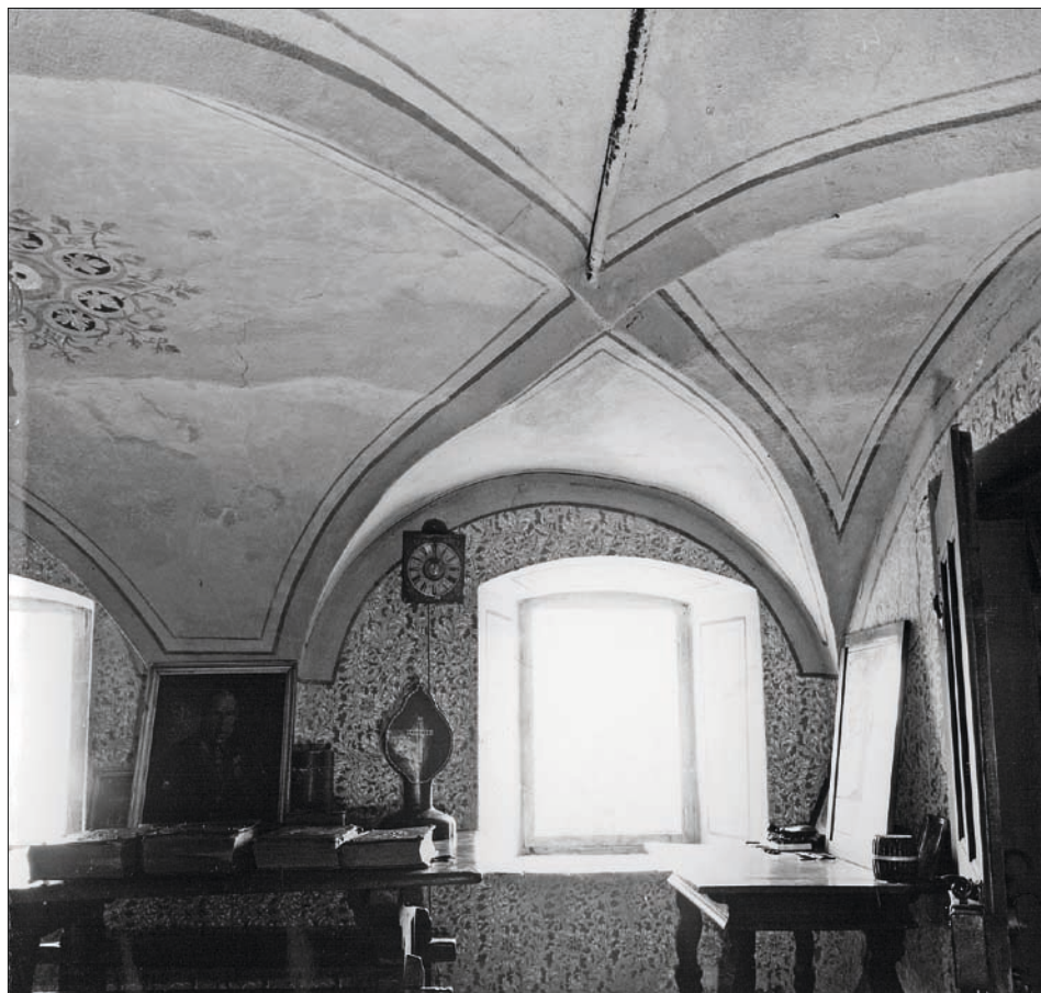
Obr. 3: Solopysky, čp. 22. Renesanční klenba s hřebínky v obytném domě (foto P. Dostál, 1989/1990, archiv NPÚ ÚOPSC v Praze).
