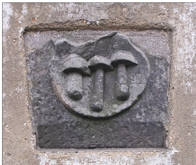
Obr. 6: Vykáň, čp. 5, druhotně použitý segment záklenku brány s erbem (zatím) neznámého rodu (foto J. Šulc, 2004).
