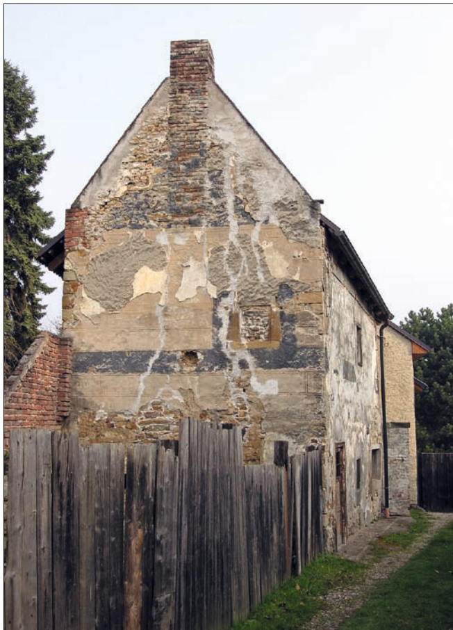
Obr. 4: Lázně Toušeň (okres Praha-východ), čp. 30. Jižní průčelí renesanční hospodářské přístavby obytné budovy mlýna (foto J. Kypa, 2014).
