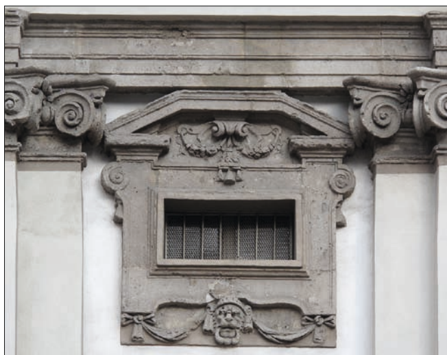
Obr. 26: Milán, kostel S. Giuseppe, okno přízemní etáže průčelí (foto P. Uličný).
