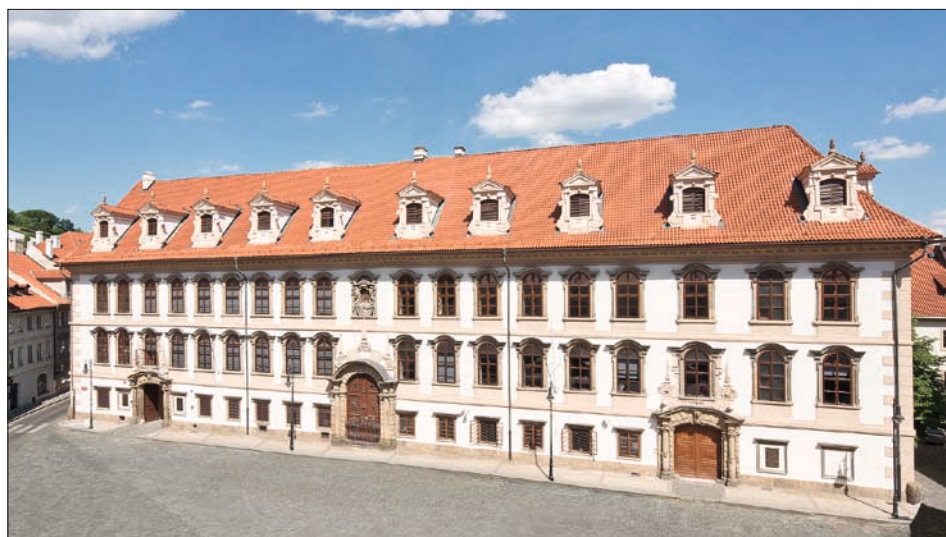
Obr. 17: Praha, Valdštejnský palác, průčelí (foto T. Rasl).
