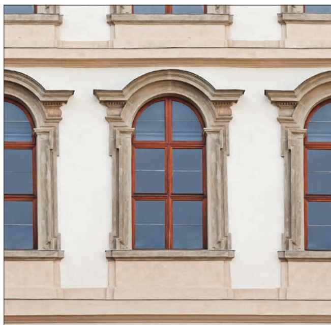
Obr. 18: Praha, Valdštejnský palác, okna východní strany hlavního dvora (foto T. Rasl).
