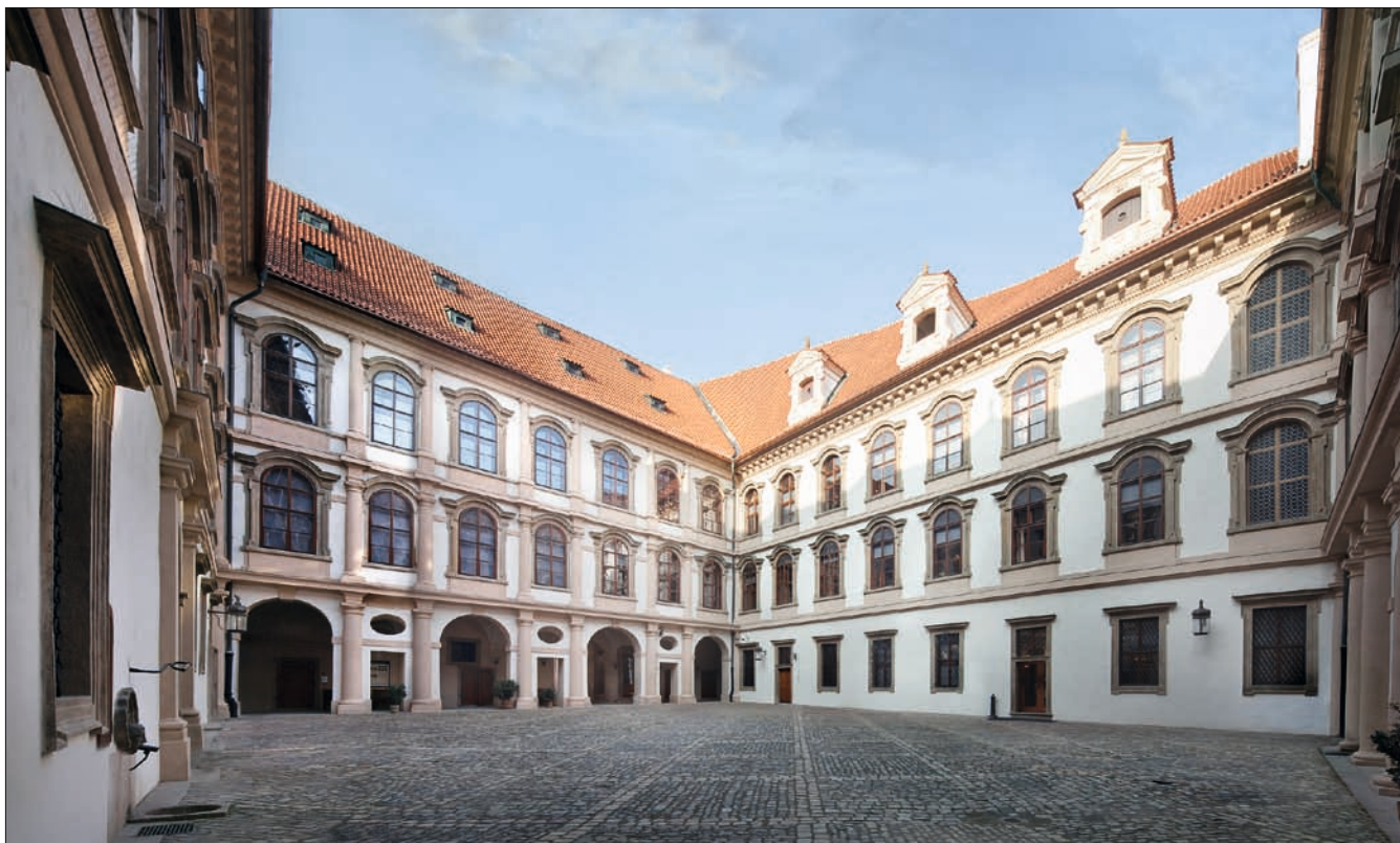
Obr. 14: Praha, Valdštejnský palác, hlavní nádvoří, pohled k západní vstupní straně (foto T. Rasl).
