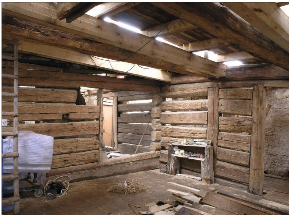
Obr. 6: Bělá pod Bezdězem, dům čp. 4, patro, pohled z přední místnosti k nároží se zadní místností. Stěna byla druhotně narušena s vestavbou mladšího otopného zařízení. V podélné stěně je zachována původní stojka s druhotně zaslepeným vstupem. V kolmé stěně je viditelný malý čtvercový otvor po konstrukci dymníku, shodný otvor je vidět vedle vstupu do zadní místnosti.
