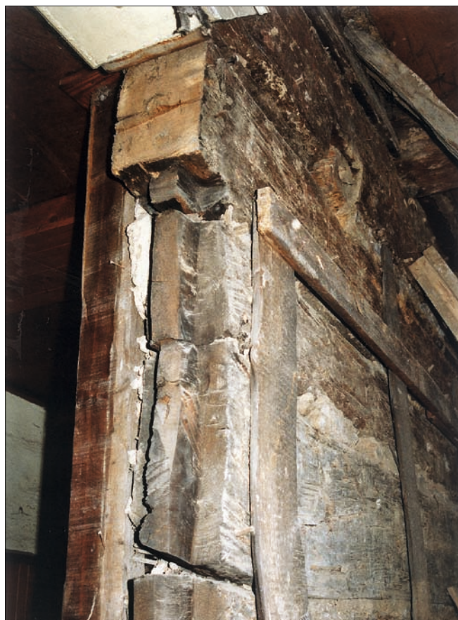
Obr. 8: Bělá pod Bezdězem, dům čp. 4, přízemí, přední místnost, detail spoje roubené stěny a zaniklé stojky vstupu. Trám nadpraží byl druhotně odřezán při zvýšení vstupu (stav 1996).
