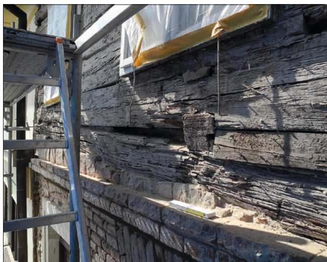
Obr. 17: Bělá pod Bezdězem, dům čp. 83, detail roubené konstrukce průčelní stěny v patře. Pod oknem jsou viditelná čela trámů, která jsou pravděpodobně pozůstatkem kolmé roubené stěny (stav 2014).
