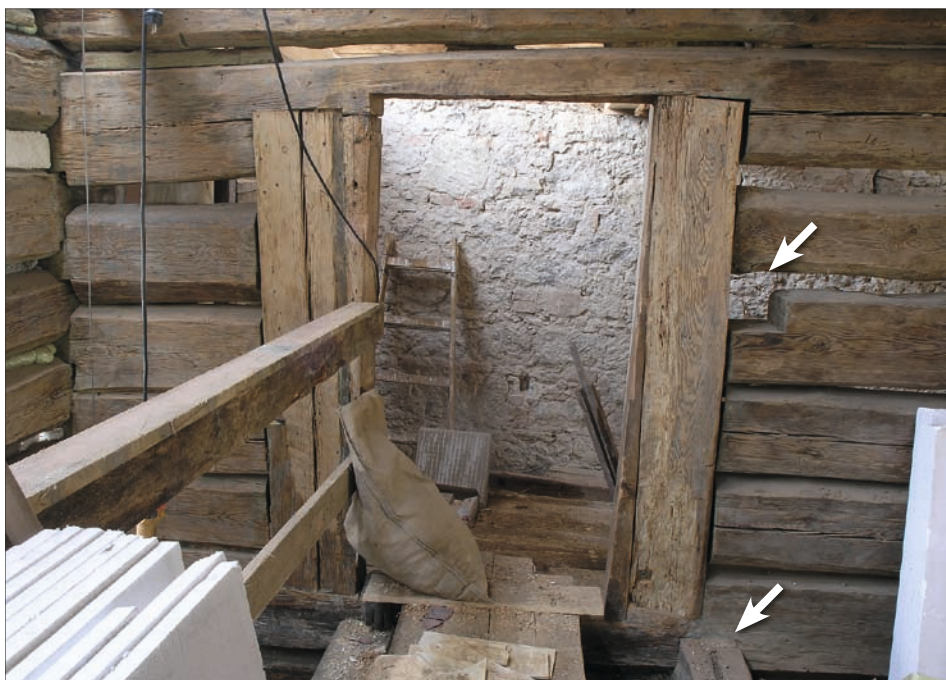
Obr. 7: Bělá pod Bezdězem, dům čp. 4, patro, zadní komora. Pohled ke vstupu ze síně. U pravé stojky je zachován otvor po vodorovném trámku konstrukce dymníku, v horní ploše stropního trámu pod pravou stojkou žlábek po dřevohliněné výplni.
