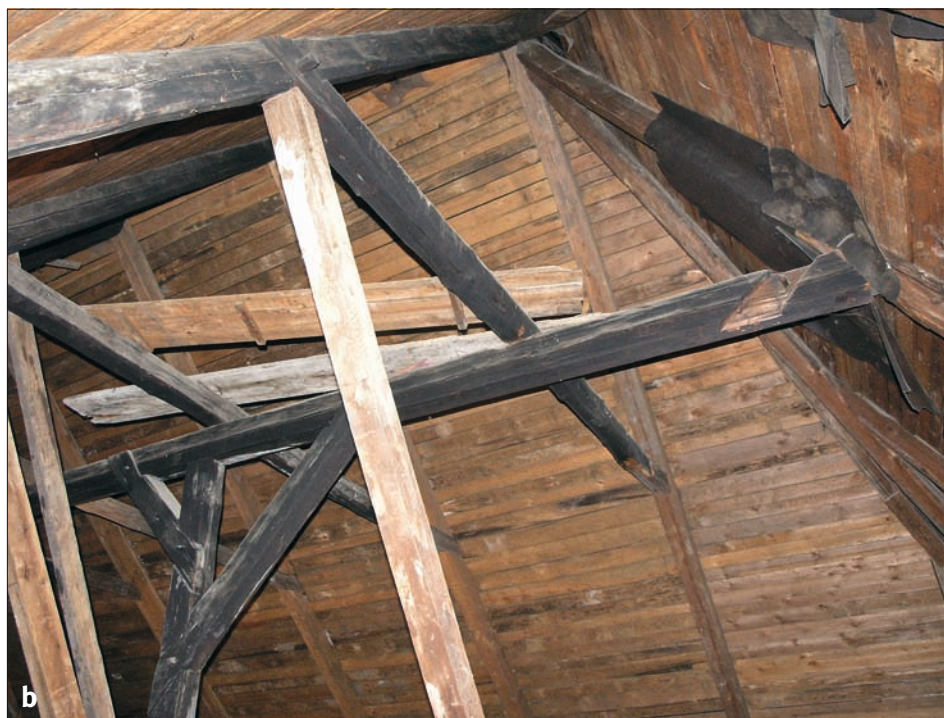
Obr. 10: Bělá pod Bezdězem, dům čp. 4, krov: a) Pohled od průčelí k severní valbě se střední a koncovou stojkou s podélným zavětrováním. Původní prvky krovu jsou odlišitelné od mladších podle zčernalého povrchu (stav 2008); b) Pohled na přední část krovu od střední stojky k valbě průčelí. Na středové vaznici je patrný otisk po horním pásku, který spojoval vaznici a zaniklou stojku první vazby (stav 2008).
