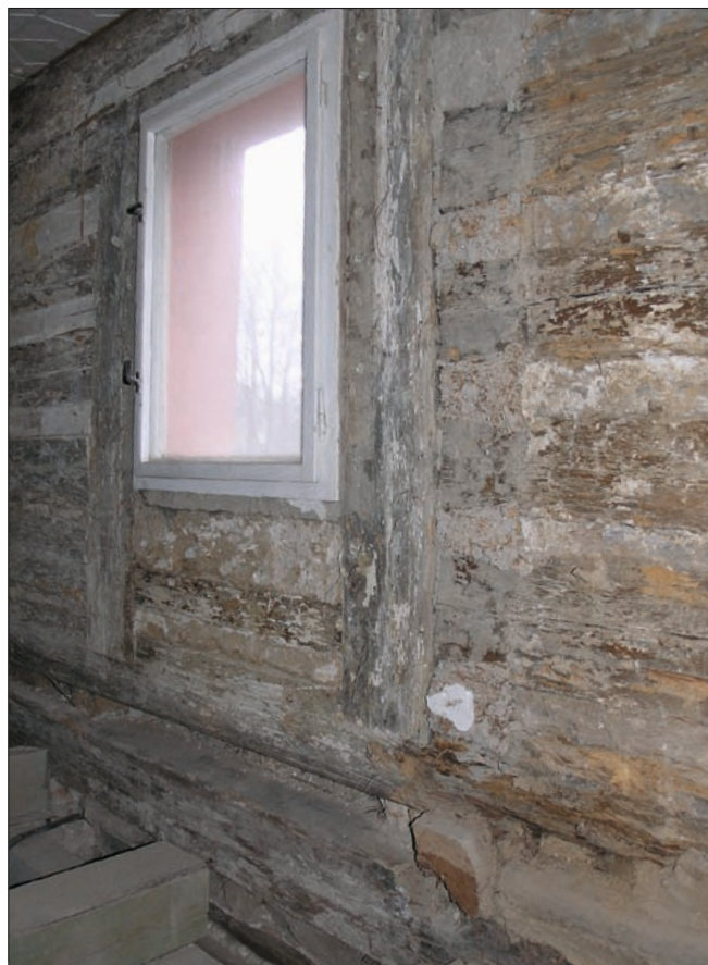
Obr. 15: Bělá pod Bezdězem, dům čp. 18, pohled na roubenou stěnu průčelí v patře s původními stojkami vstupu, který byl druhotně nahrazen oknem. U pravé stojky jsou viditelná odřezaná zhlaví trámů kolmé roubené stěny, která oddělovala chodbu (stav 2010).
