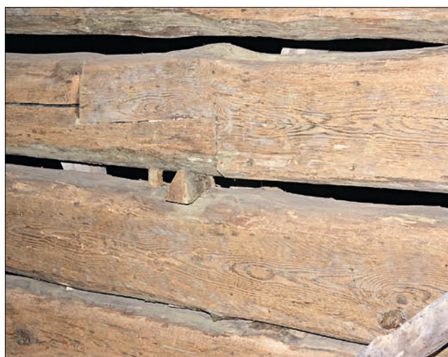
Obr. 9: Bělá pod Bezdězem, dům čp. 4, detail původního navázání trámů roubené stěny.
