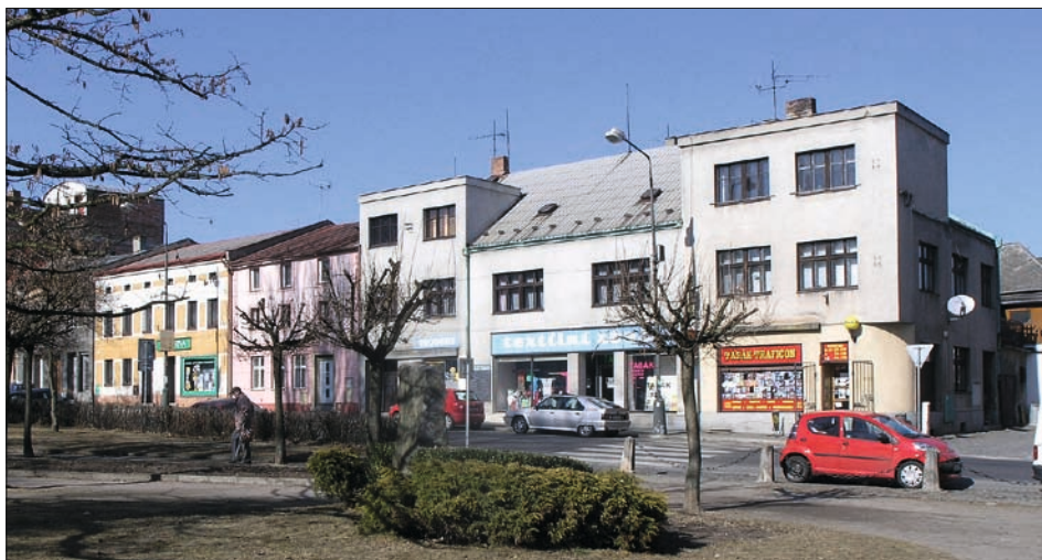
Obr. 12: Bělá pod Bezdězem, dům čp. 18, stejný pohled na domy severní strany náměstí jako na předchozí fotografii zhruba o sto let později. Dům čp. 18 zcela změnil svůj vnější vzhled. Původní vysoká střecha domu byla nahrazena polopatrem (stav 2010).
