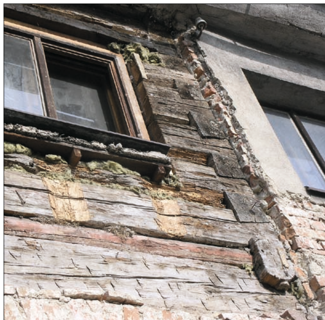
Obr. 5: Bělá pod Bezdězem, dům čp. 4, průčelí do ulice po odhalení roubených konstrukcí v patře s detailem navázání kolmé příčky s průčelní stěnou rybinovým spojem typickým pro nároží. Odlišné je pouze ukončení prahového trámu kolmé stěny (stav 2009).
