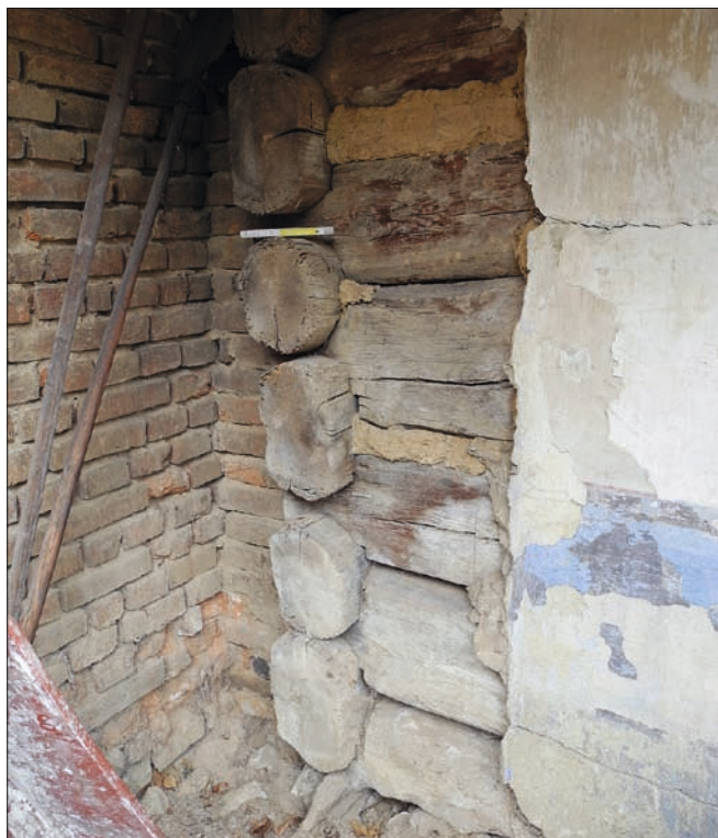
Obr. 18: Bělá pod Bezdězem, dům čp. 83, detail nároží roubené dvorní stěny v přízemí. Trámy obvodové stěny na straně k sousednímu domu čp. 82 byly zřejmě druhotně odřezané, z čehož vyplývá, že konstrukce objektu pokračovala směrem do dvora (stav 2014).
