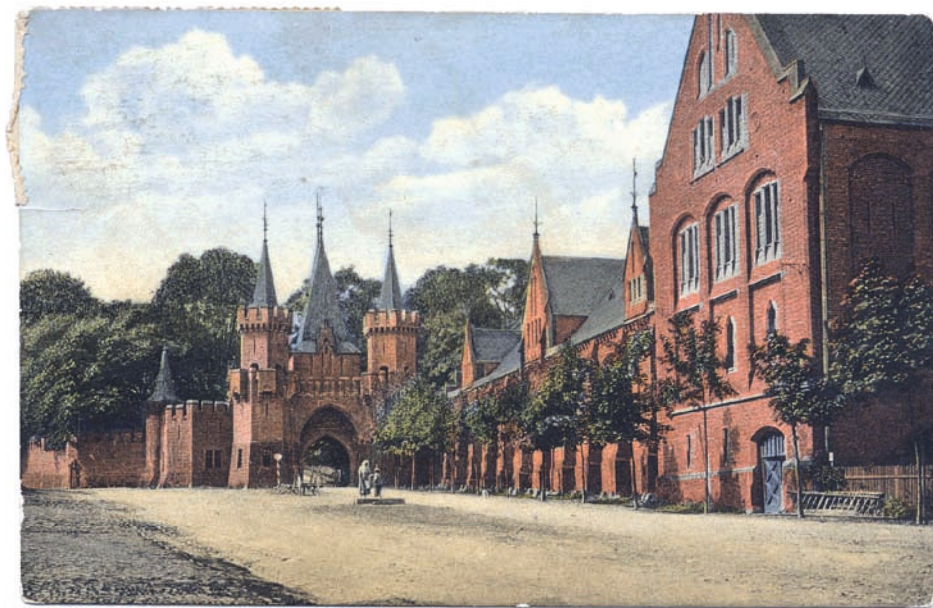
Obr. 7: Hradec nad Moravicí, Červený zámek, celkový pohled na západní průčelí s provozní věží, konírnou a vstupní branou. U provozní věže původní stav řešení přízemí s vjezdem (soukromá sbírka P. Havrlanta, 1917).
