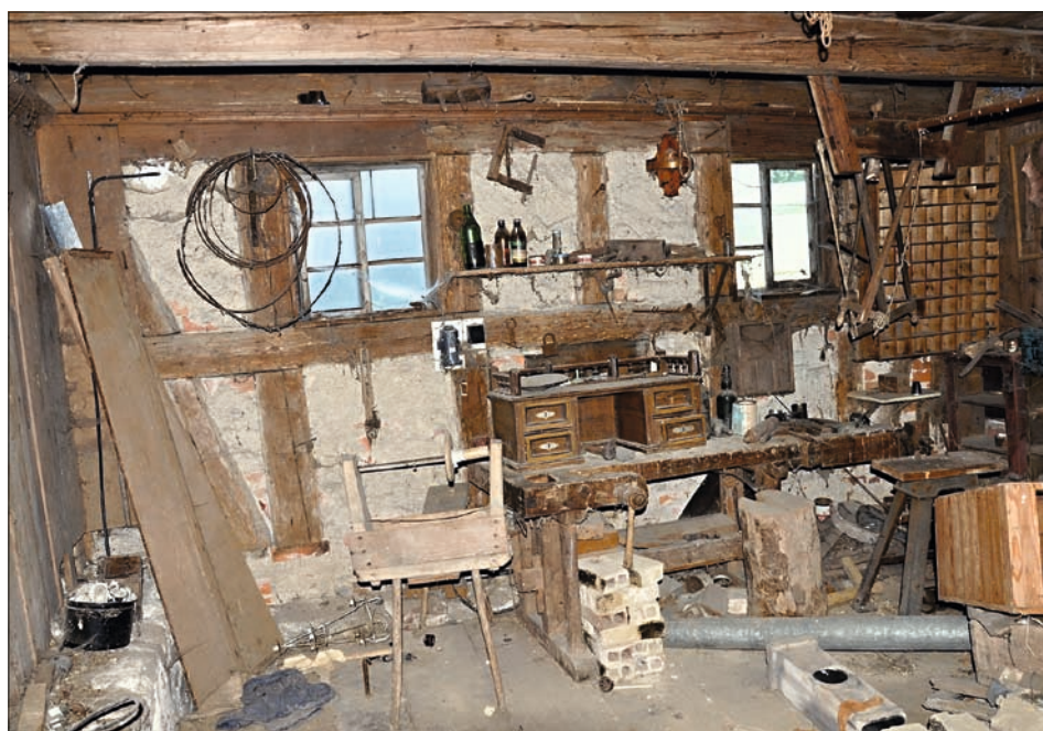
Obr. 28: Dětřichovec, mlýn čp. 30, dílna č. 2.02 – pohled k jihovýchodní stěně (foto M. Ouhrabka, 2013).
