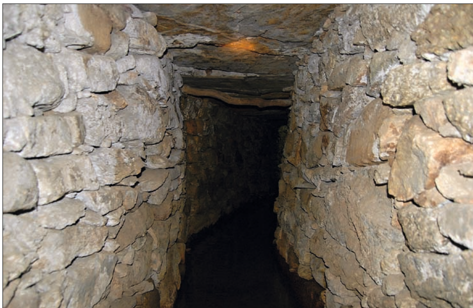
Obr. 17: Dětrichovce, mlýn čp. 30, odtokový kanál, svrchu krytý břídlíčovými plotnami.
