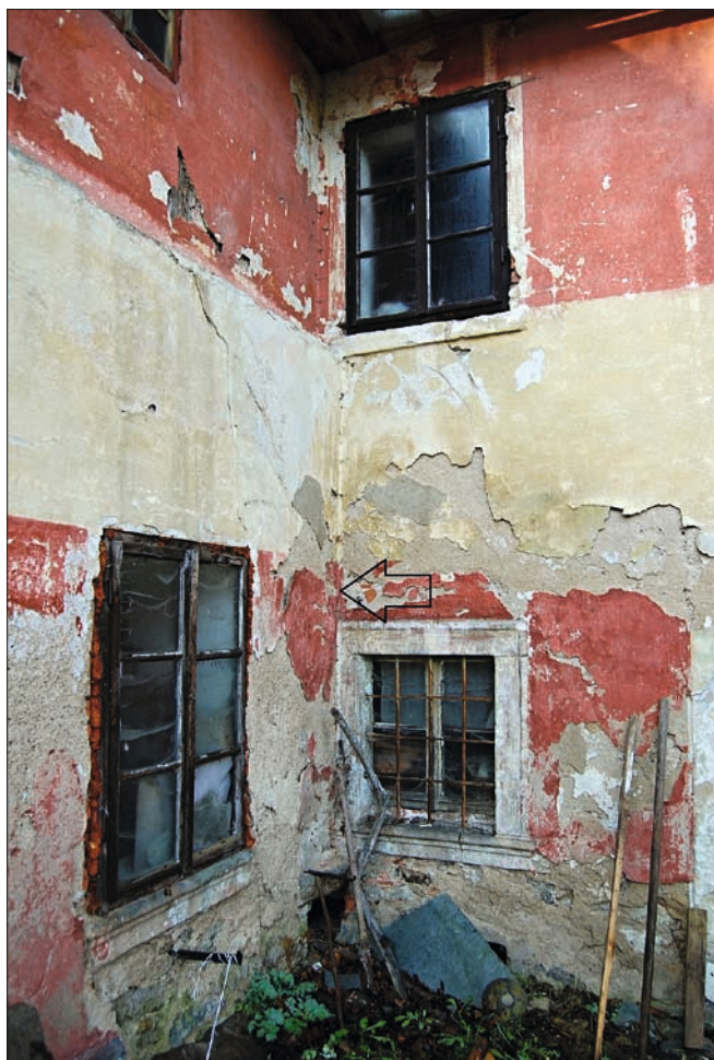
Obr. 7: Dětrichovec, mlýn čp. 30, detail napojení severovýchodního (levá část – kolmé křídlo) na jihovýchodní (hlavní vstupní) průčelí; šipkou označeno přisazení kolmého křídla.
