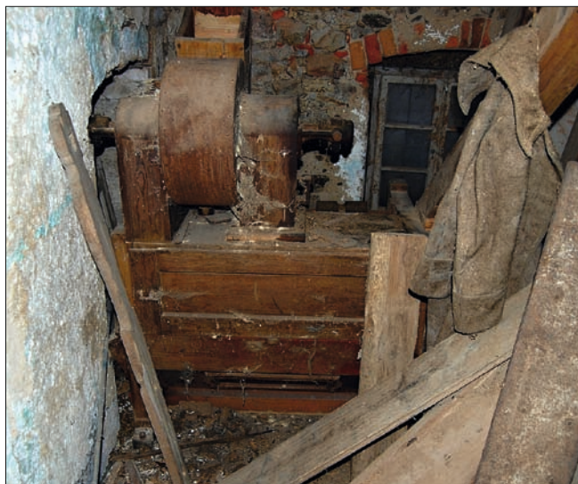
Obr. 32: Dětřichovec, mlýn čp. 30, mlýnice č. 2.01 – loupáčka, čelní pohled.
