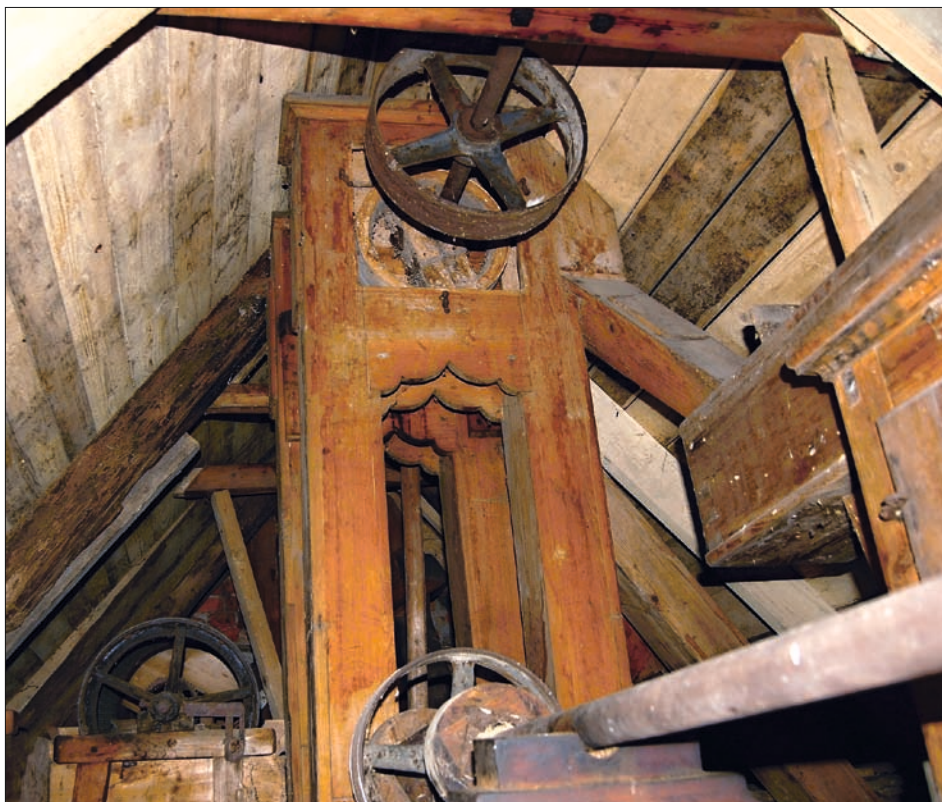
Obr. 35: Dětřichovec, mlýn čp. 30, podkroví č. 3.01 – hlava kapsového výtahu, vlevo dole trieur.
