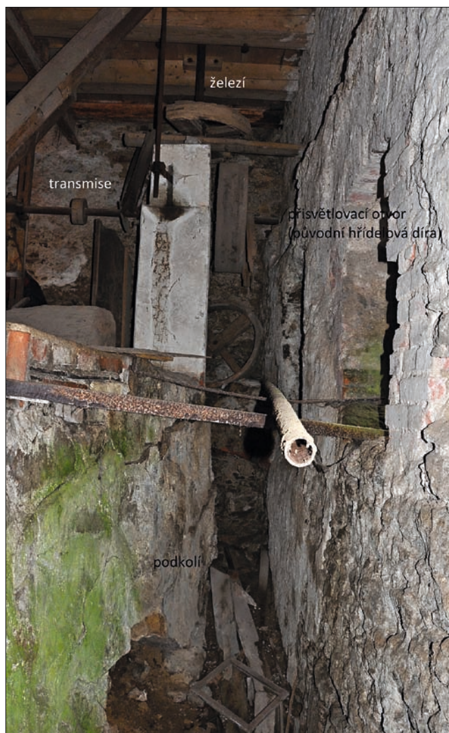
Obr. 25: Dětřichovec, mlýn čp. 30, podkolí č. 0.02 – pohled do šachty směrem k jihozápadní stěně. V pozadí betonový fundament, nesoucí vodorovnou a svislou hřídel (železí) s řemenicemi (foto M. Ouhrabka, 2013).
