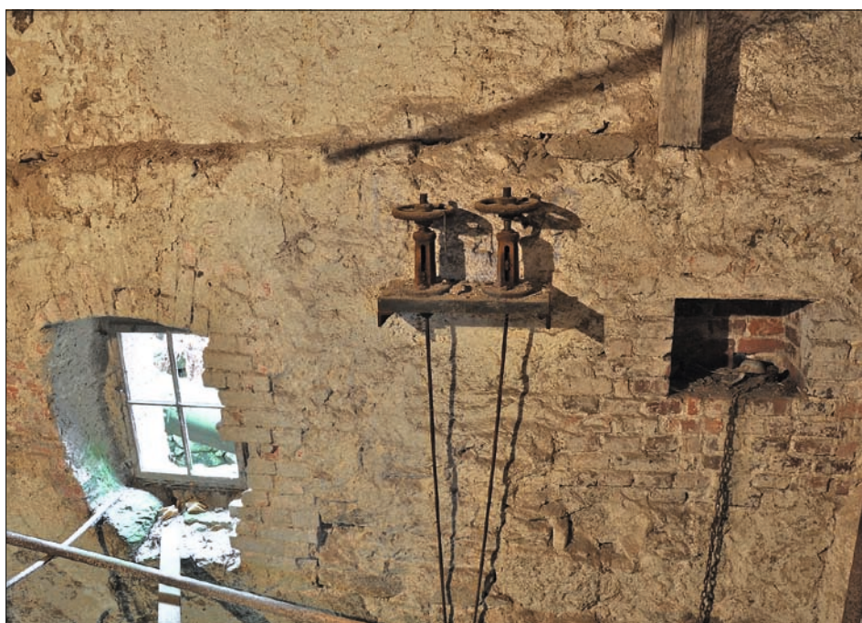
Obr. 26: Dětřichovec, mlýn čp. 30, mlýnice č. 1.01 – pohled na návodní stěnu (foto M. Ouhrabka, 2013).
