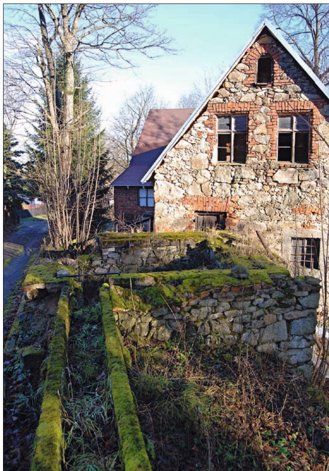
Obr. 11: Dětřichovec, mlýn čp. 30, jihozápadní průčelí – štitová část v prvním plánu. V popředí betonový žlab náhonu, ústící do vodního zámku.
