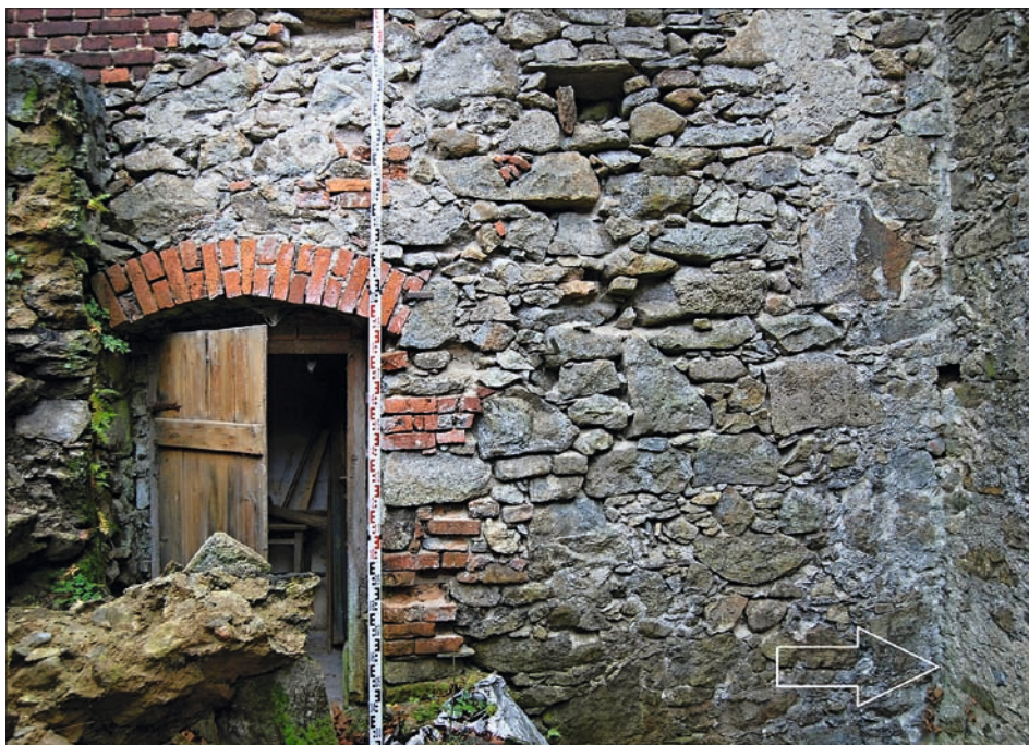
Obr. 15: Dětřichovec, mlýn čp. 30, jihozápadní průčelí – lednice, detail napojení zdi na severozápadní průčelí a bočního vstupu do síně.
