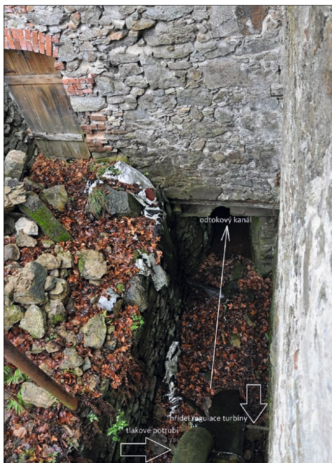
Obr. 16: Dětřichovec, mlýn čp. 30, jihozápadní průčelí – lednice, detail počátku odpadního (odtokového) kanálu, odvádějící vodu z lednice zpět do vodoteče.
