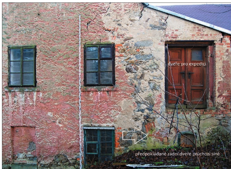
Obr. 19: Dětrichovec, mlýn čp. 30, severozápadní průčelí – východní část; šipkou označen záklenek původního dveřního otvoru průchozí síně, nad ním mladší dveřní otvor expedice mlečům.
