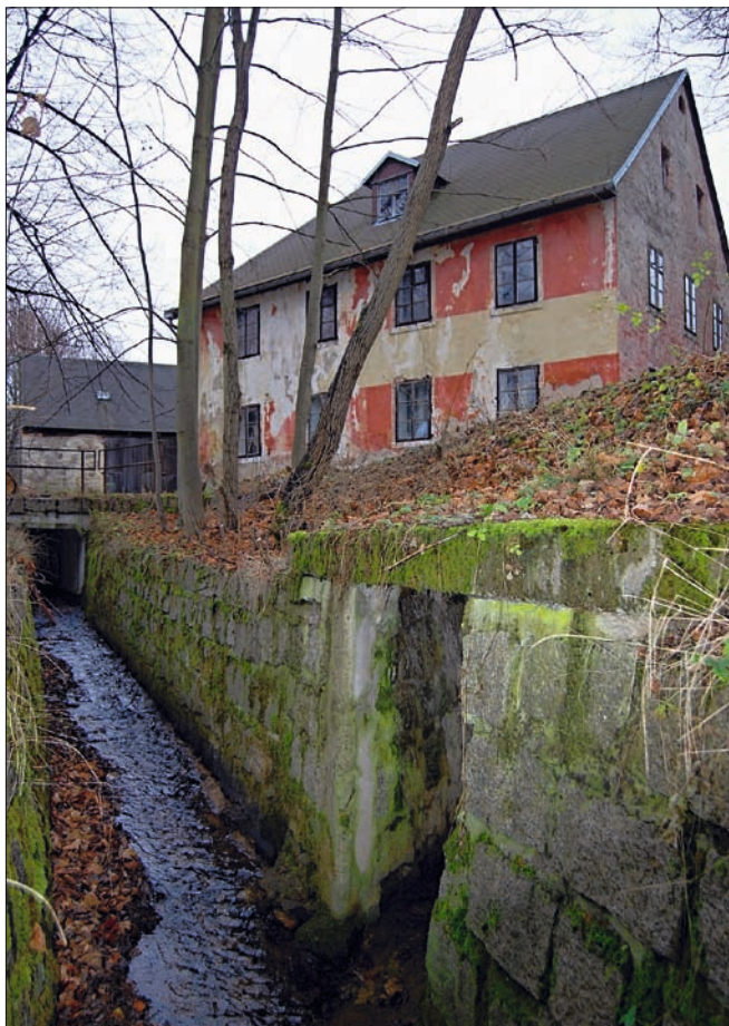
Obr. 18: Dětrichovce, mlýn čp. 30, ústí odtokového kanálu, v pozadí pravá část severovýchodního průčelí objektu.
