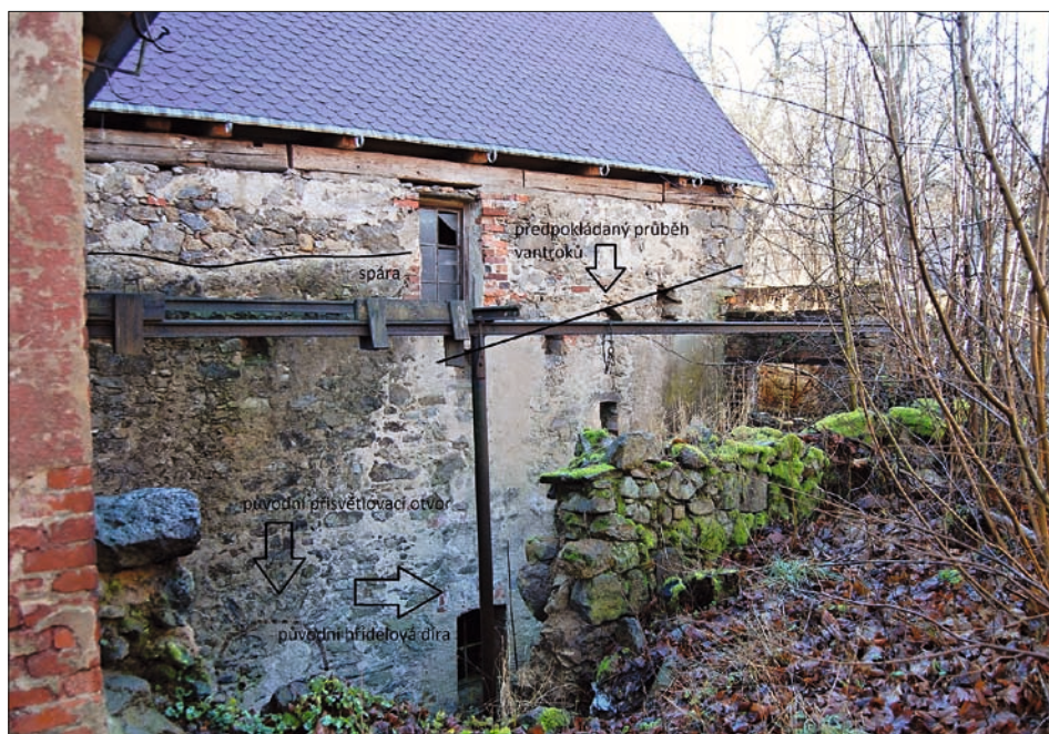
Obr. 12: Dětřichovec, mlýn čp. 30, severozápadní průčelí – lednice, návodní stěna mlýnice.
