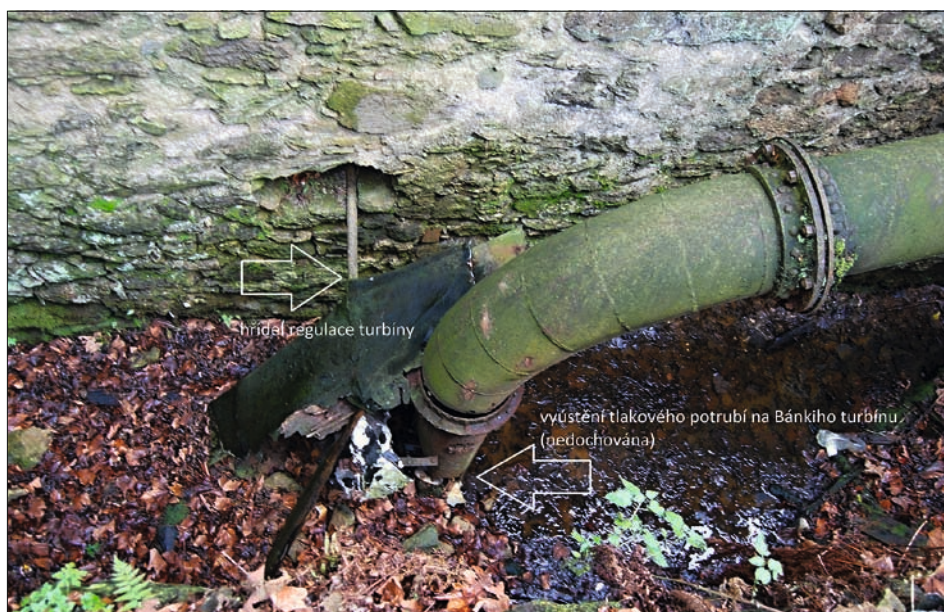
Obr. 14: Dětřichovec, mlýn čp. 30, severozápadní průčelí – lednice, detail ukončení tlakového potrubí u nedochované Bánkiho turbíny. Zdivem prostupuje táhlo regulace turbíny.
