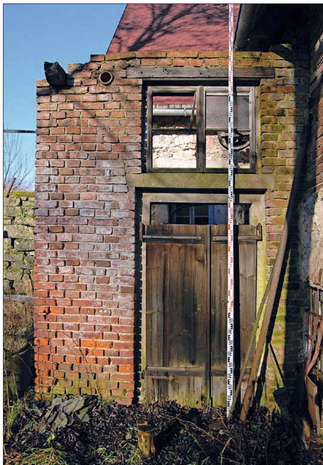
Obr. 9: Dětřichovec, mlýn čp. 30, jihovýchodní průčelí – přístavba pro stacionární motor.
