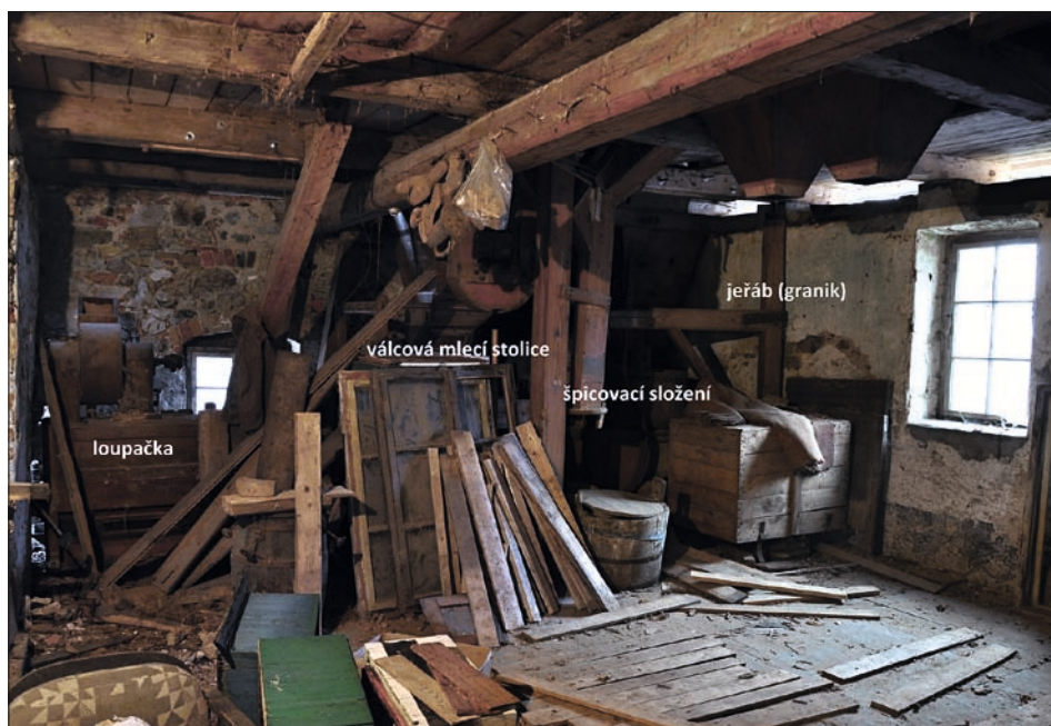
Obr. 27: Dětřichovec, mlýn čp. 30, mlýnice č. 2.01 – pohled k jihozápadní stěně (foto M. Ouhrabka, 2013).
